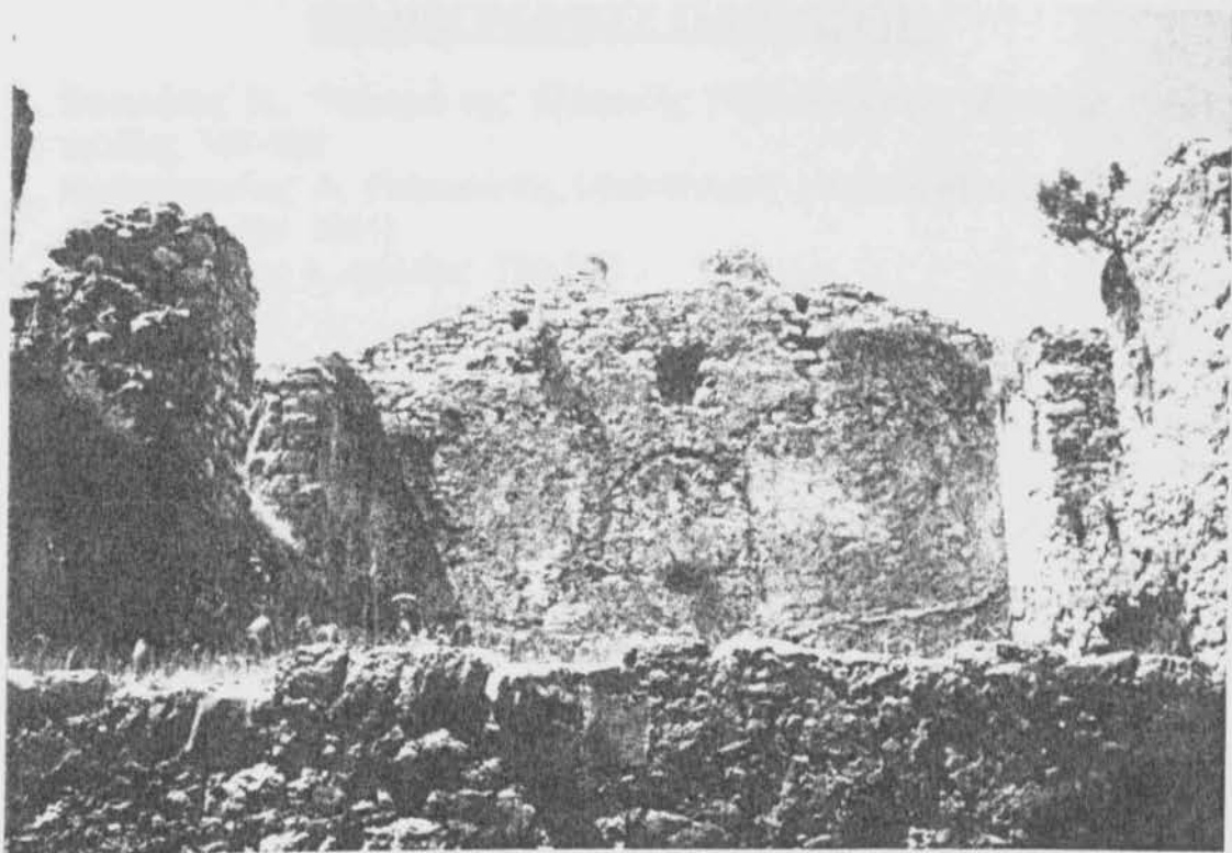
Εικόνα 68 : Η εσωτερική όψη του άνω τμήματος της Βορινής τοιχοποιίας.
