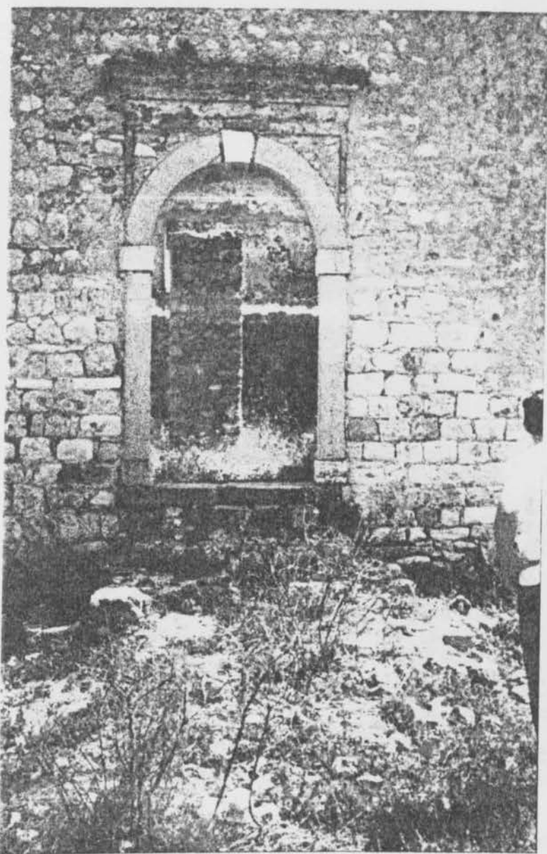
Εικόνα 59 : Η Βόρεια είσοδος του Αποσκοπέιου. Διακρίνεται η μάλλον μεταγενέστερη τοξοτή στέγη και το παλαιό υπέρθυρο.
