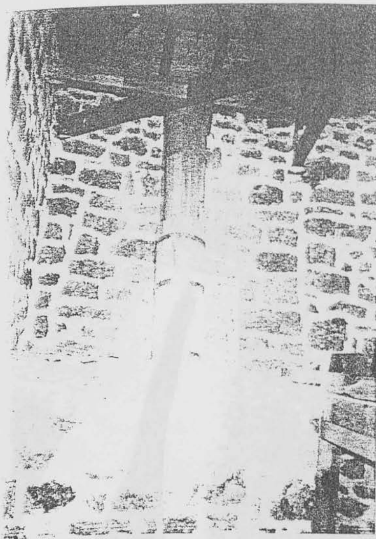
Φώτο 4. Έργα για την πτώση του νερού στην πτερωτή. Αποχώρι Μετσόβου.
