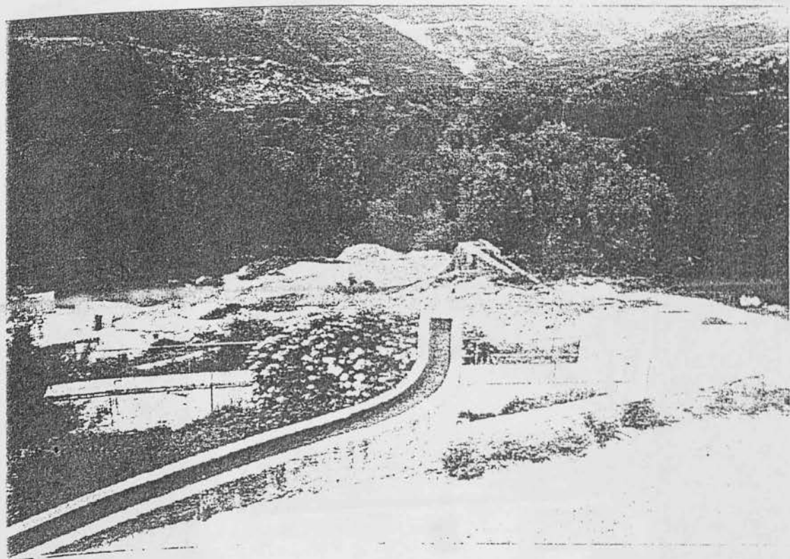
Φώτο 44. Στο Ανθοχώρι εκτός από τον νερόμυλο λειτουργούν και νεροτριβές και μαντάνι. Στην φωτογραφία διακρίνονται τα κανάλια που οδηγούν το νερό σε αυτές τις εγκαταστάσεις.
