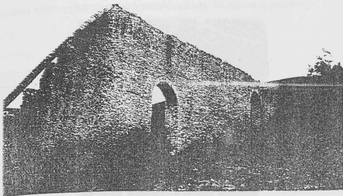
Φώτο 5. Υδραγωγείο νερόμυλου.
