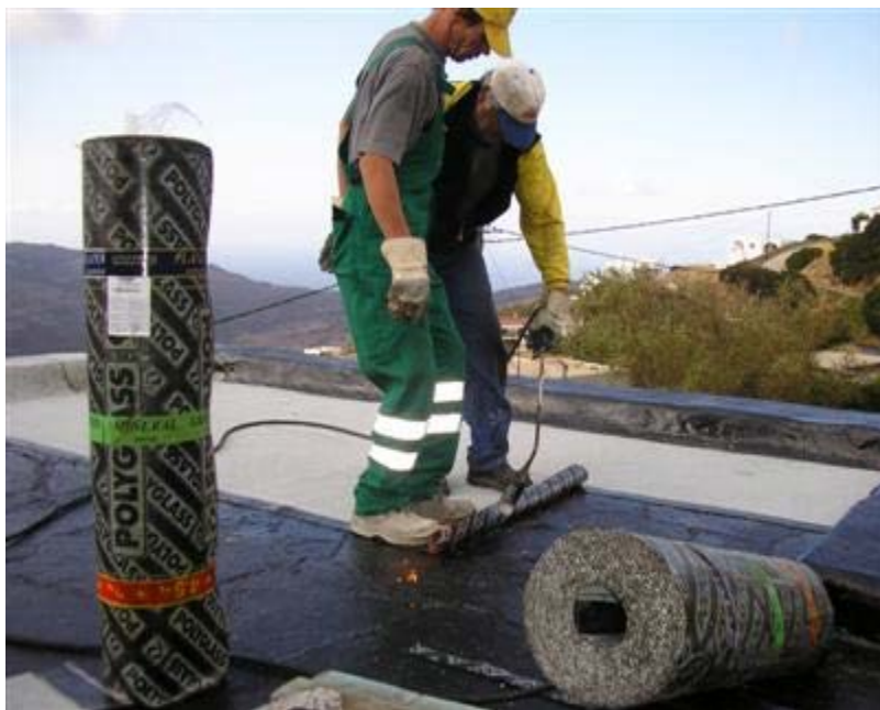
Εικόνα 5. Διαδικασία μόνωσης κτιριακού κελύφους.
