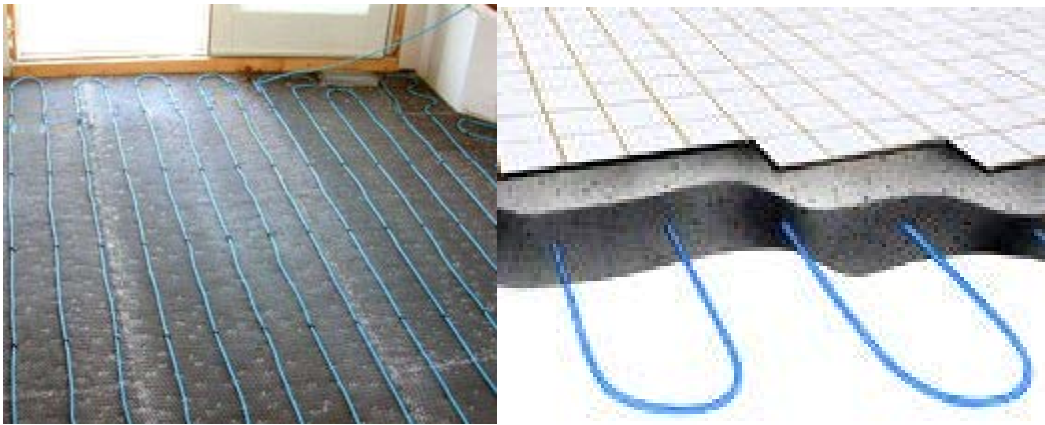
Εικόνα 8. Σύστημα ενδοδαπέδιας θέρμανσης
