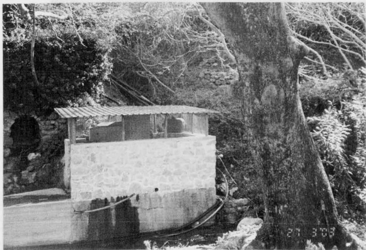
Γενική άποψη Περιβάλλοντα χώρου
