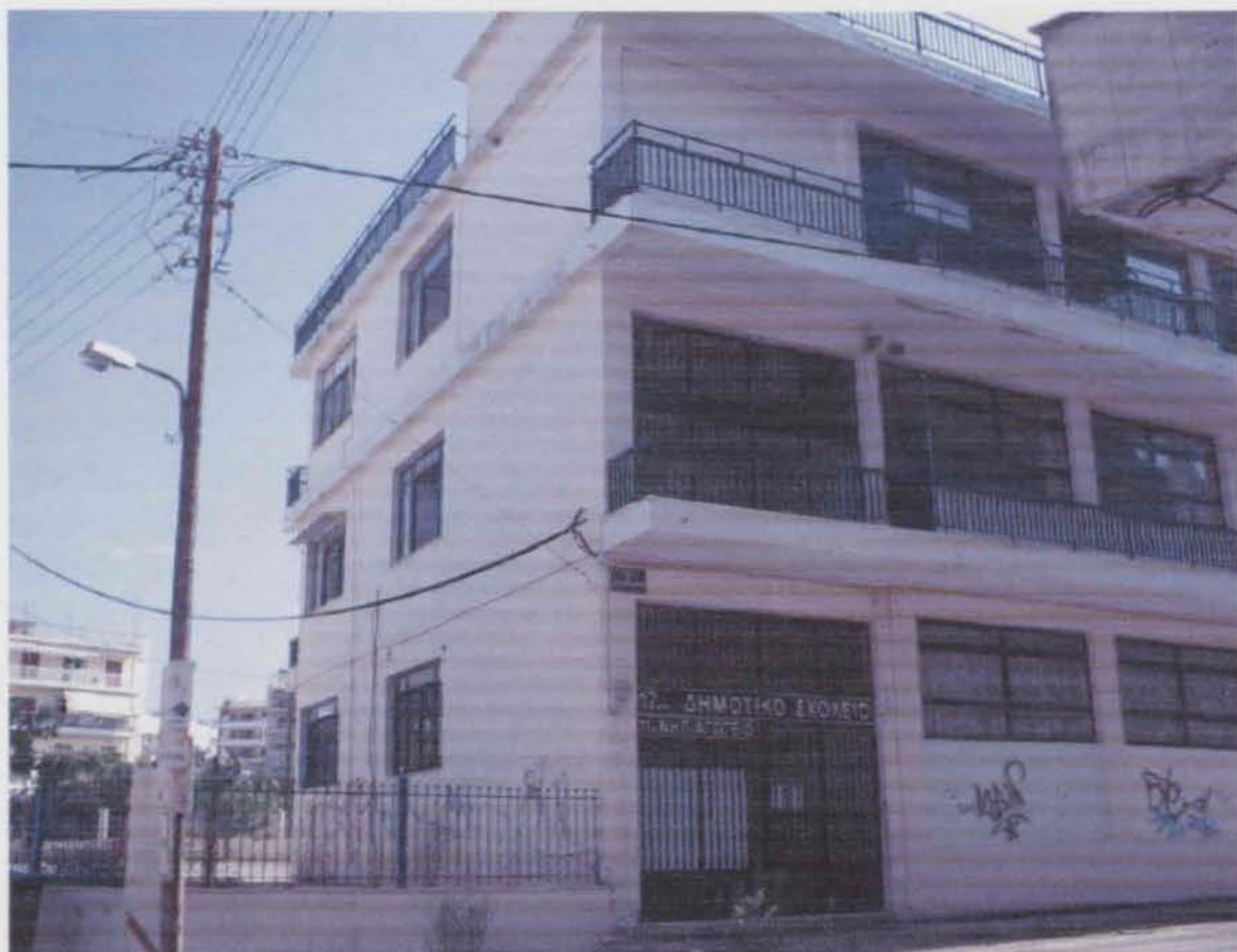
4) 17 ο Δημοτικό Σχολείο επί της οδού Χέντερσον
