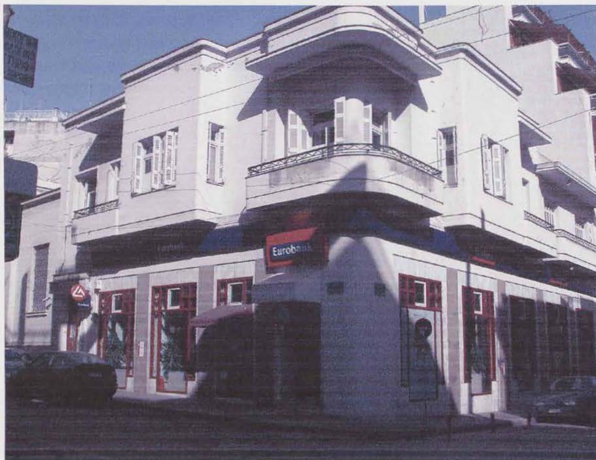
8) Eurobank στη συμβολή των οδών Βότση και Αναστασιάδη
