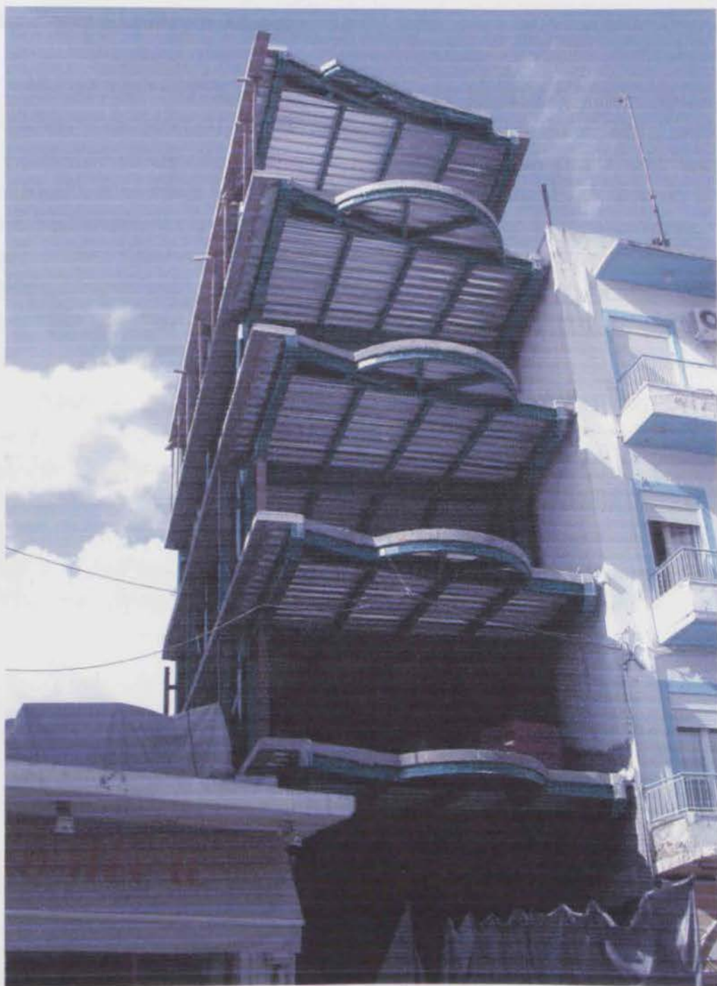
34) Σύμμεικτη κατασκευή επί της οδού Τσαλδάρη
