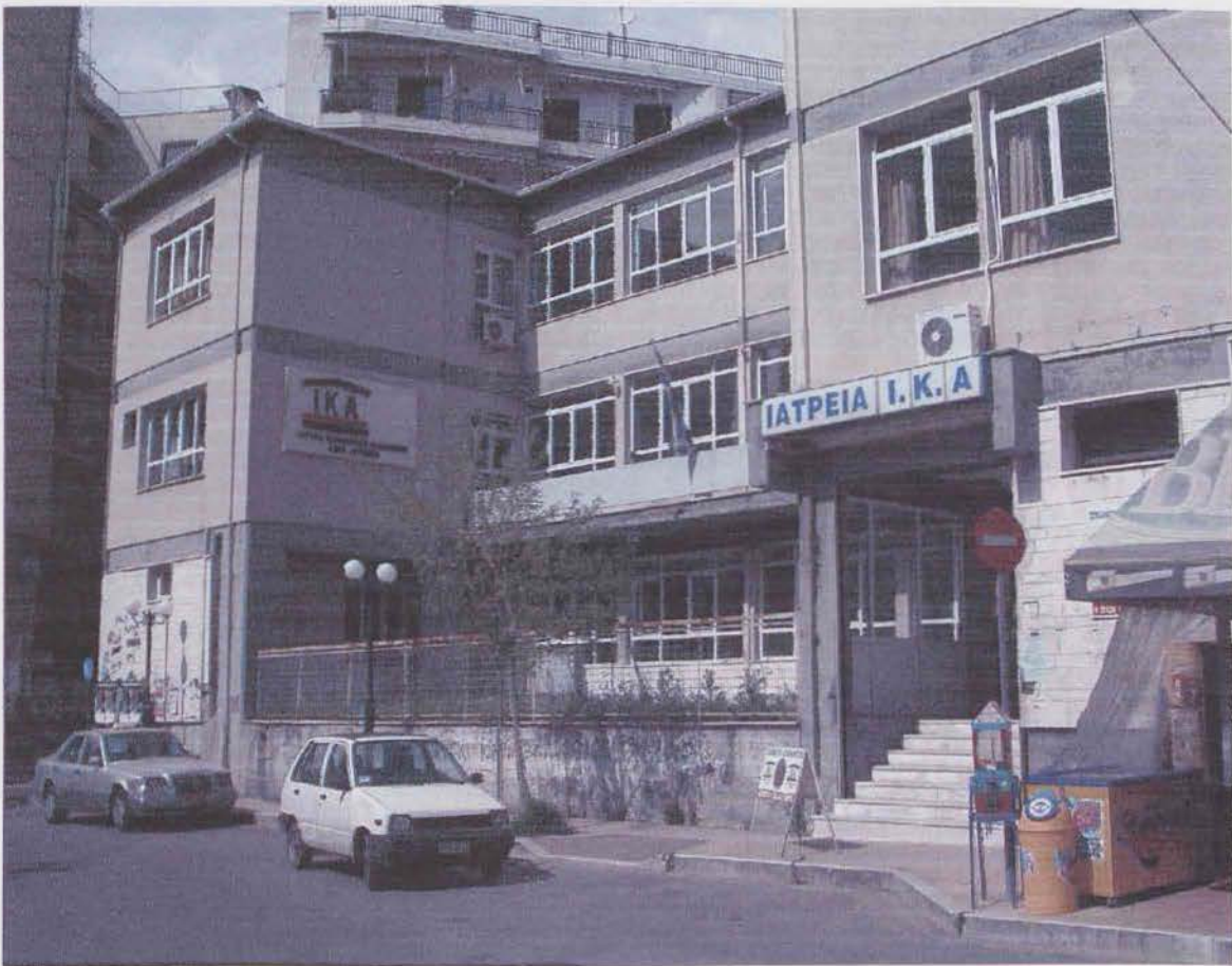
2) Υποκατάστημα Ι.Κ.Α. στην οδό Λουτιώτου
