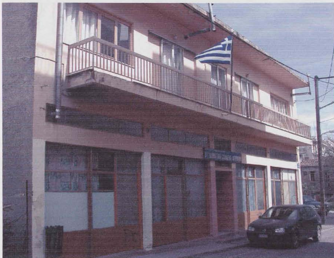
2) 6 ο Δημοτικό Σχολείο επί της οδού Ιερού Λόχου
