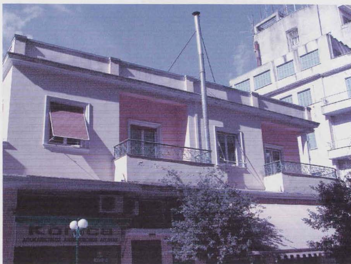
7) Δημοτικό Ωδείο στην οδό Ηλία Ηλιού
