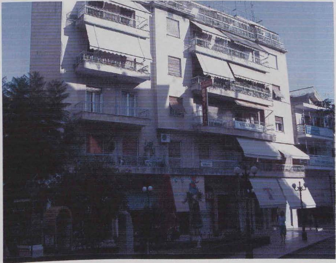
33) Πολυκατοικία του 1970 επί της οδού Παπαστράτου
