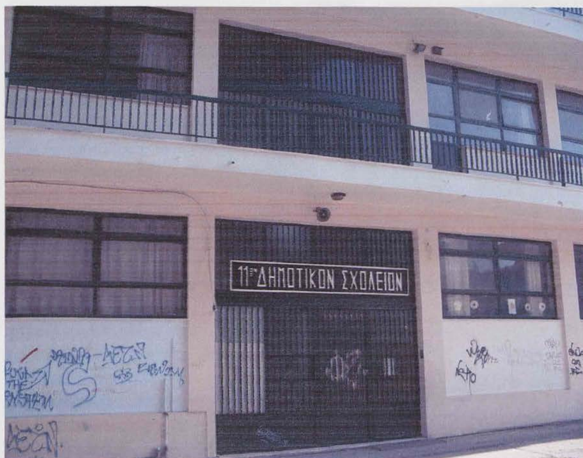
3) 11 ο Δημοτικό Σχολείο επί της οδού Χέντερσον
