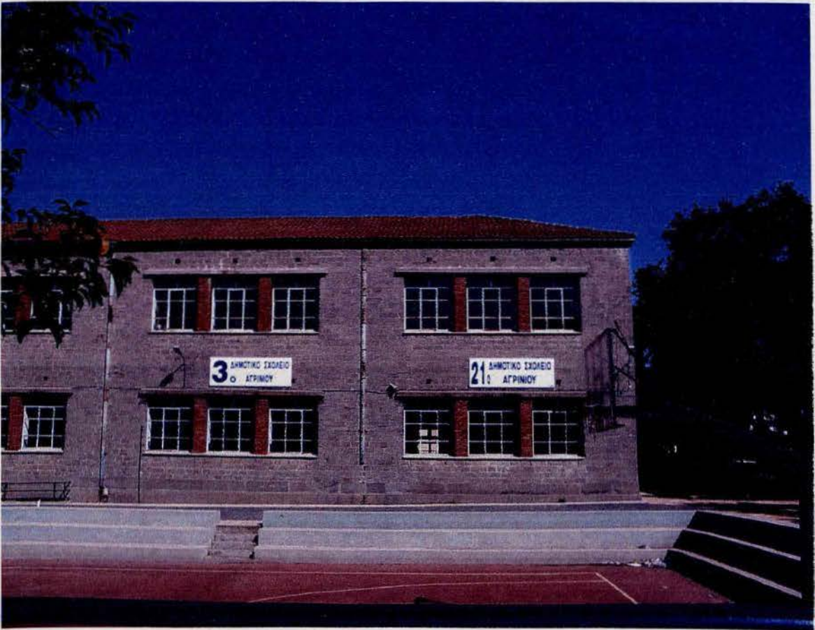
1) 3 ο και 24 ο Δημοτικό Σχολείο επί της οδού Α. Ρήκα
