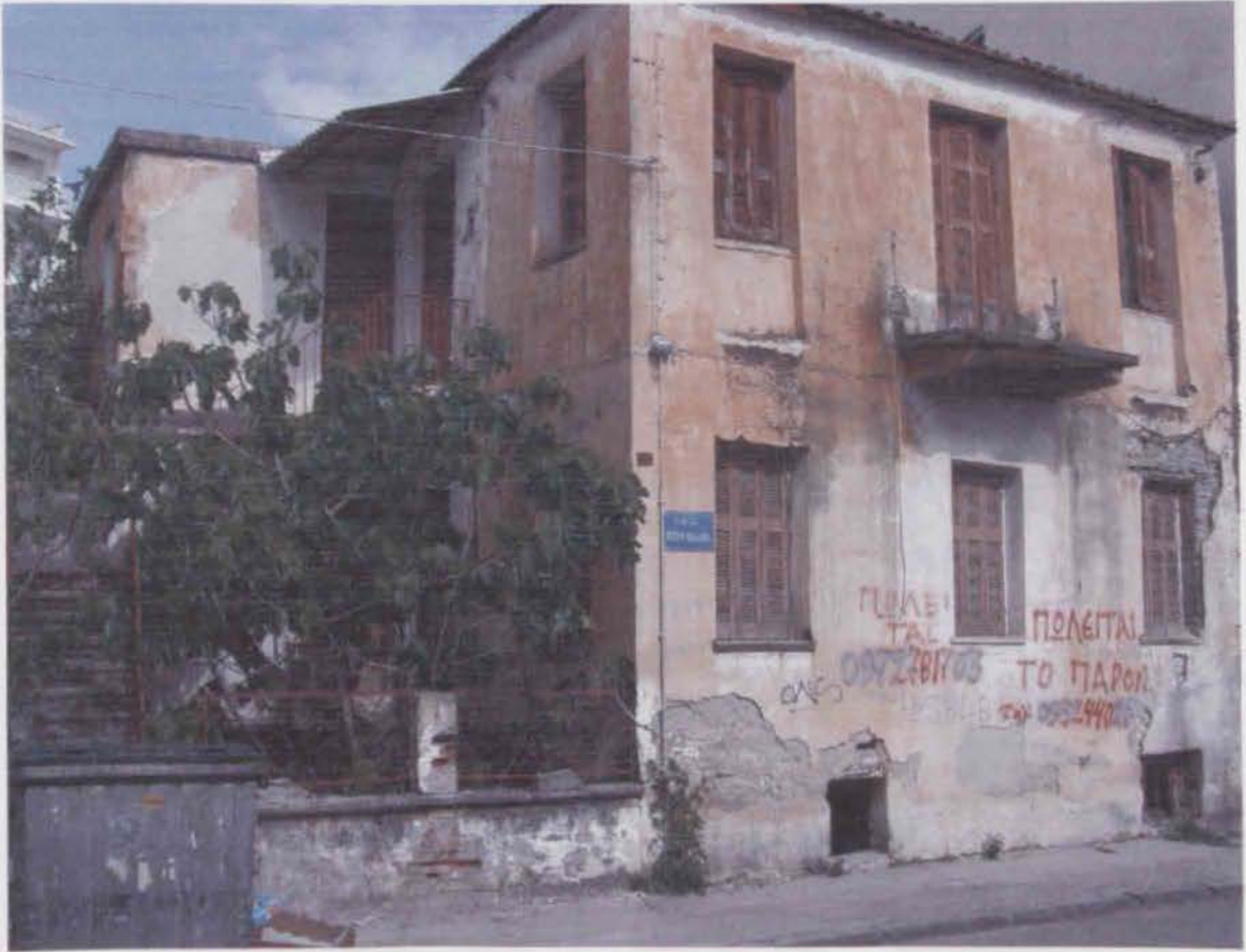
9) Εγκαταλελημένο πέτρινο κτίσμα επί της οδού Κωστή Παλαμά (Βραχωρίτικο)
