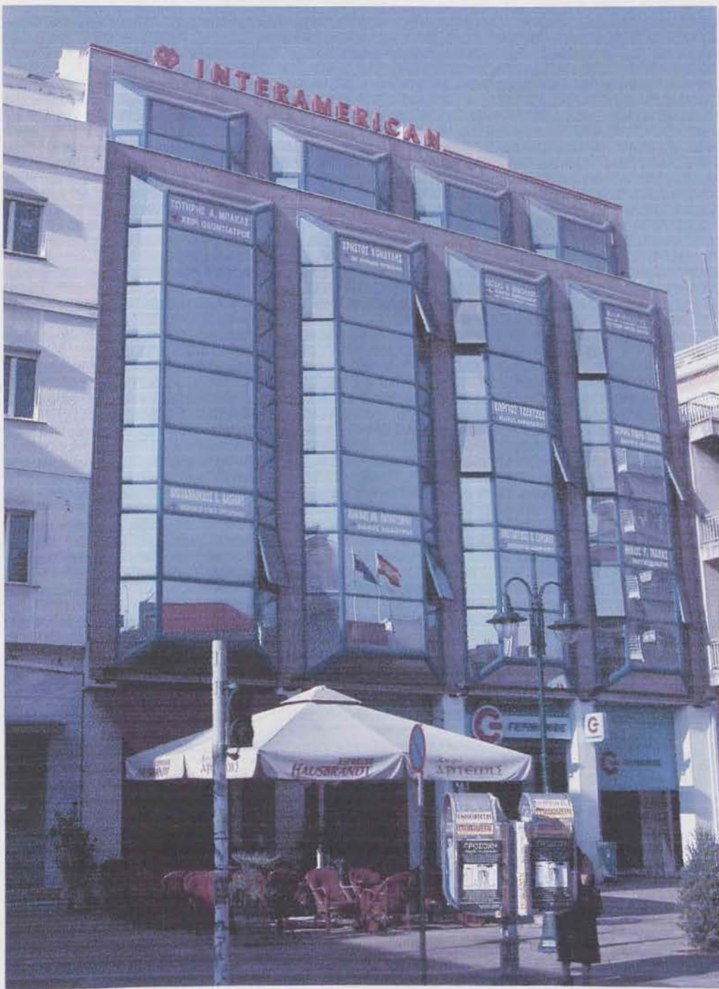
30) Πολυκατοικία σύγχρονης αρχιτεκτονικής επί της Πλατείας Ειρήνης
