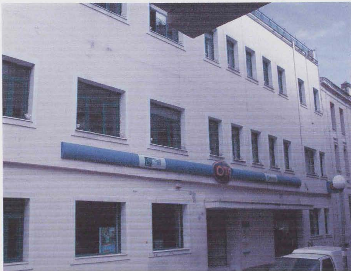
5) Κτίριο Ο.Τ.Ε. στην οδό Σούλου
