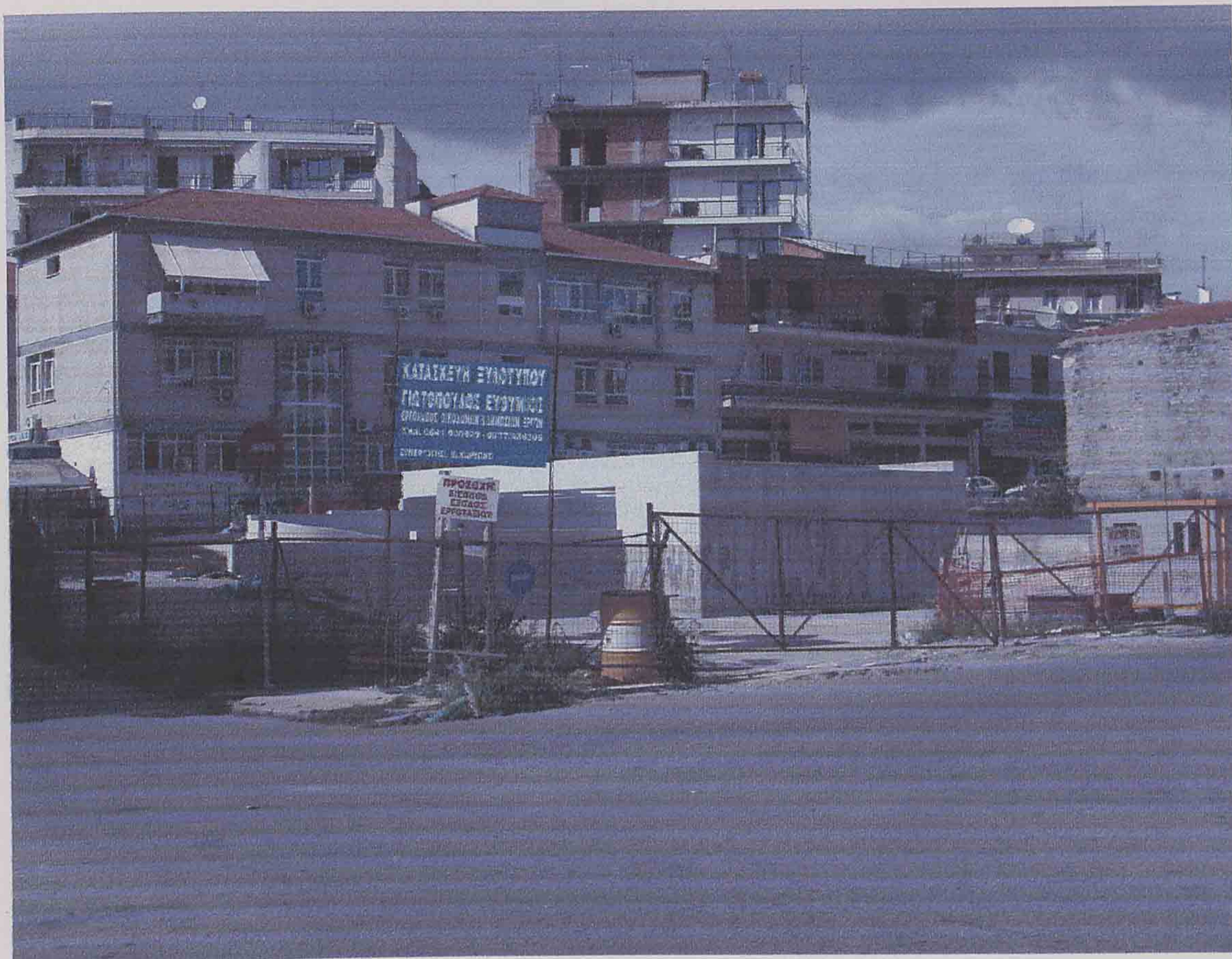
Υπόγειο Parking στην περιοχή του κέντρου
