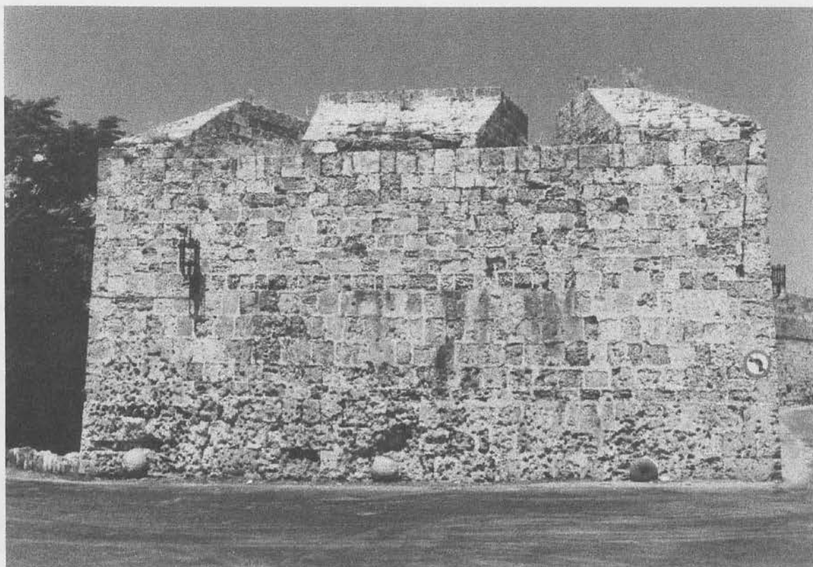
Όψη προμαχώνα. Εξωτερική πλευρά των τειχών Νότιο - Ανατολική πλευρά ( Γλώσσα Ιταλίας )
