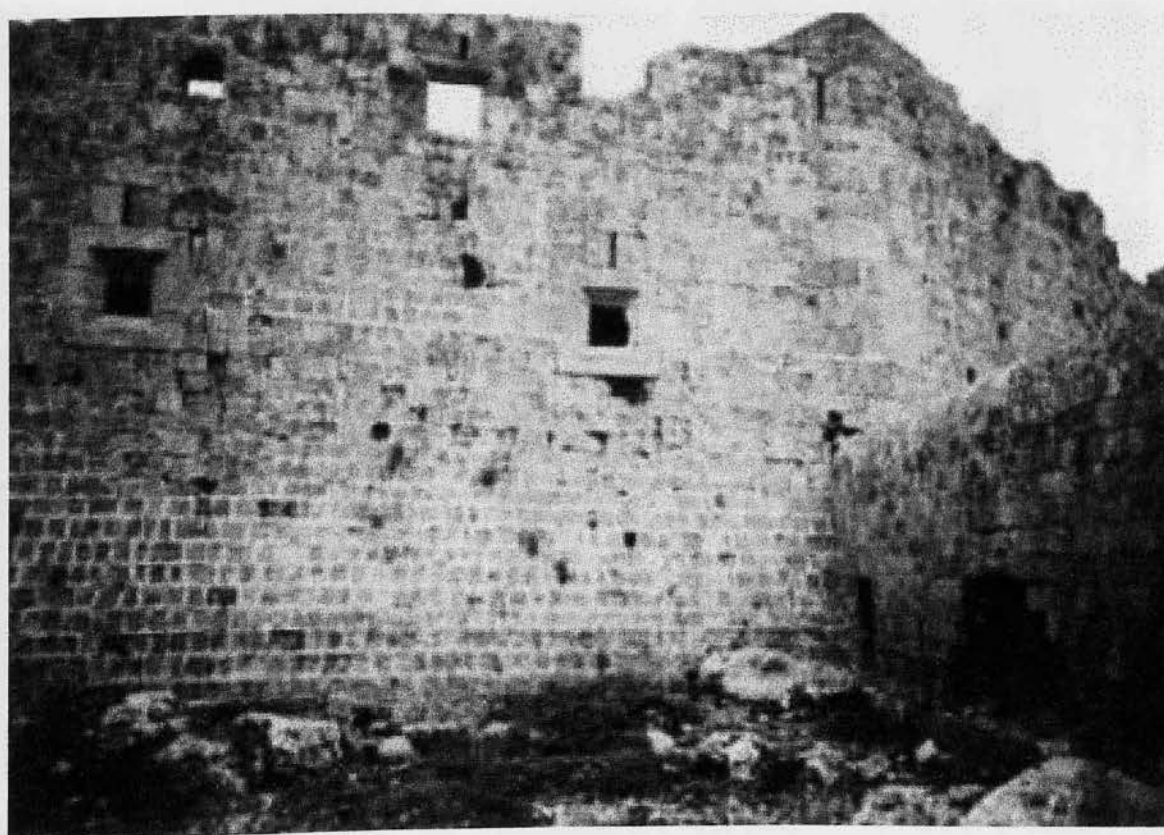
Εσωτερική αποτύπωση των τειχών του πύργου του Αγίου Ιωάννου - Κοσκινού, Νότια πλευρά ( Γλώσσα Προβηγγίας )
