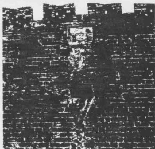
(σχ. 59 – 60) Αποτέλεσμα φθοράς από διαφορεική καθίζηση στο πρόχωμα της Αγγλίας - διαμπερής ρωγμή στην ανατολική πλευρά του προμαχώνα του Αγίου Γεωργίου
