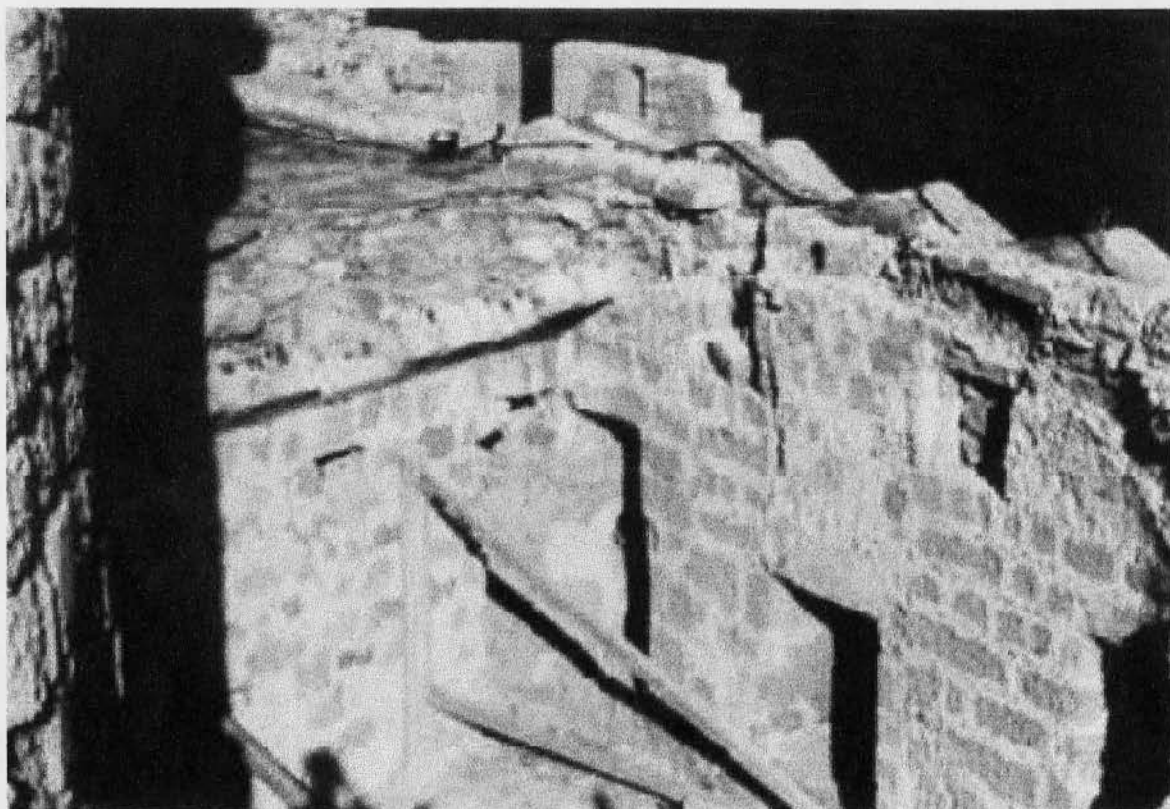
Λεπτομέρεια περιτειχίσματος στο εξωτερικό του φρουρίου του Αγίου Νικολάου, στο λιμάνι, Εσωτερική πλευρά του φρουρίου. Βόρεια πλευρά ( Γλώσσα Καστίλης )
