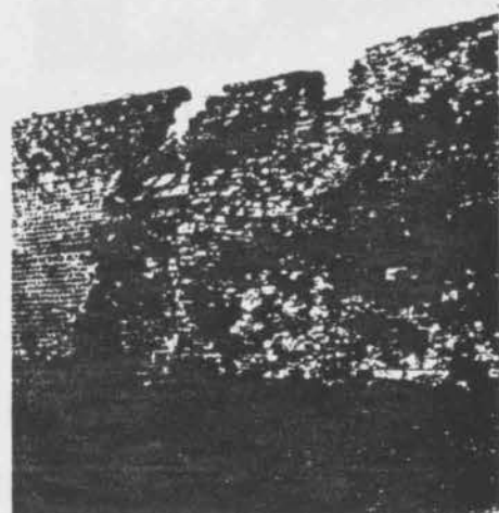
(σχ. 59 – 60) Αποτέλεσμα φθοράς από διαφορεική καθίζηση στο πρόχωμα της Αγγλίας - διαμπερής ρωγμή στην ανατολική πλευρά του προμαχώνα του Αγίου Γεωργίου
