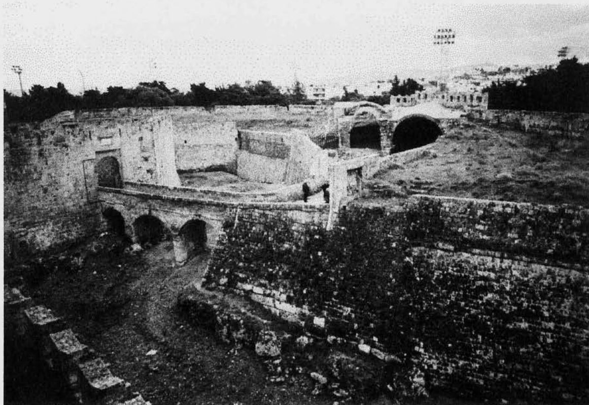
Εσωτερικό του πύργου του Αγίου Ιωάννου - Κοσκινού. Εσωτερικό τμήμα των τειχών. Νότια πλευρά ( Γλώσσα Προβηγγίας )
