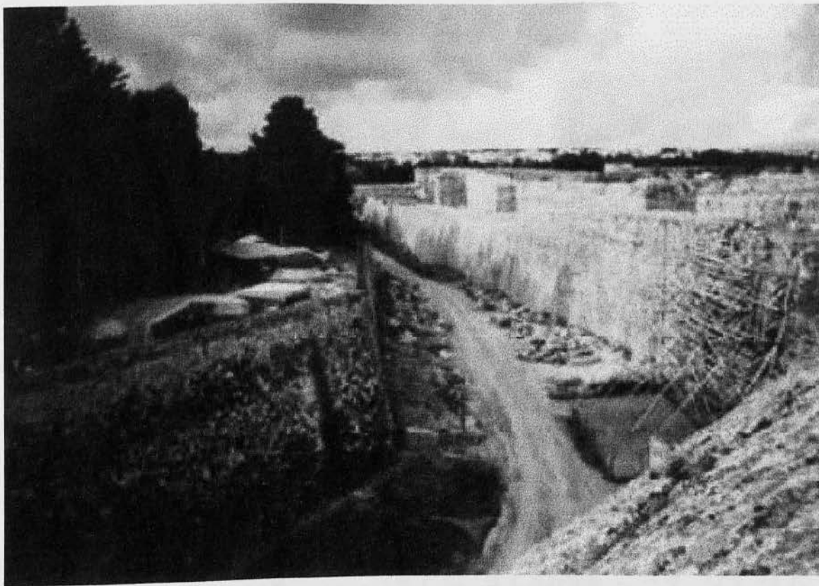
Εσωτερικό τάφρου στον πύργο του Αγίου Ιωάννου - Κοσκινού, όπου φαίνεται η Contrascarra και το εξωτερικό των τειχών. Νότια πλευρά ( Γλώσσα Προβηγγίας )
