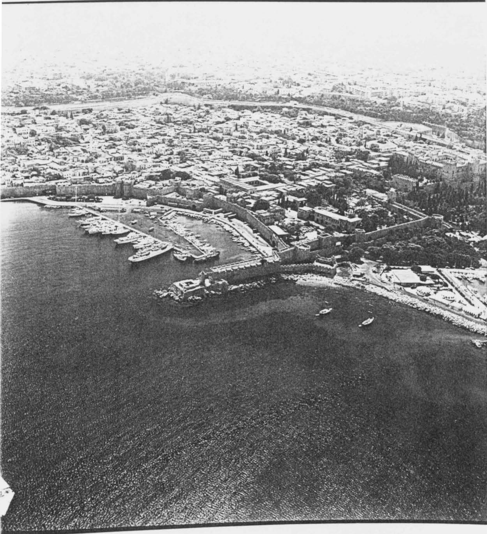
Θαλασσινό τείχος - Πύργος ΝΑΙΛΛΑΣ, Βόρειο - ανατολική πλευρά (Γλώσσα Καβίλλης)
