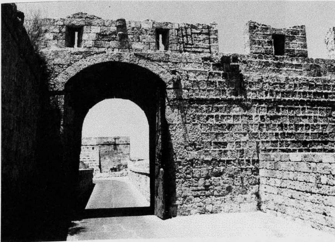
Λεπτομέρεια της πύλης στον πύργο του Αγίου Ιωάννου - Κοσκινού, Εσωτερική πλευρά των τειχών. Νότια πλευρά ( Γλώσσα Προβηγγίας )
