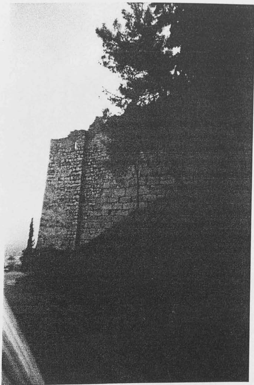
Τμήμα των τειχών του κάστρου της Λαμίας, στο οποίο φαίνεται η χρήση μεγάλων λίθων.
