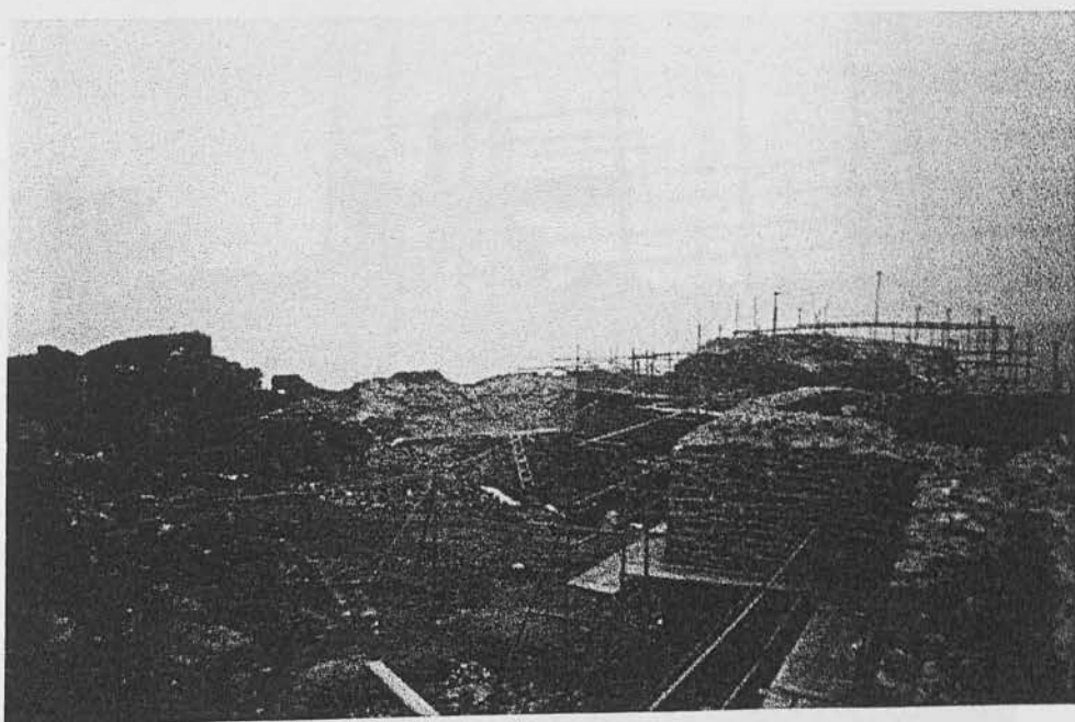
Στο βάθος διακρίνουμε την ενίσχυση της παλαιάς τοιχοποιίας με σκυρόδεμα.
