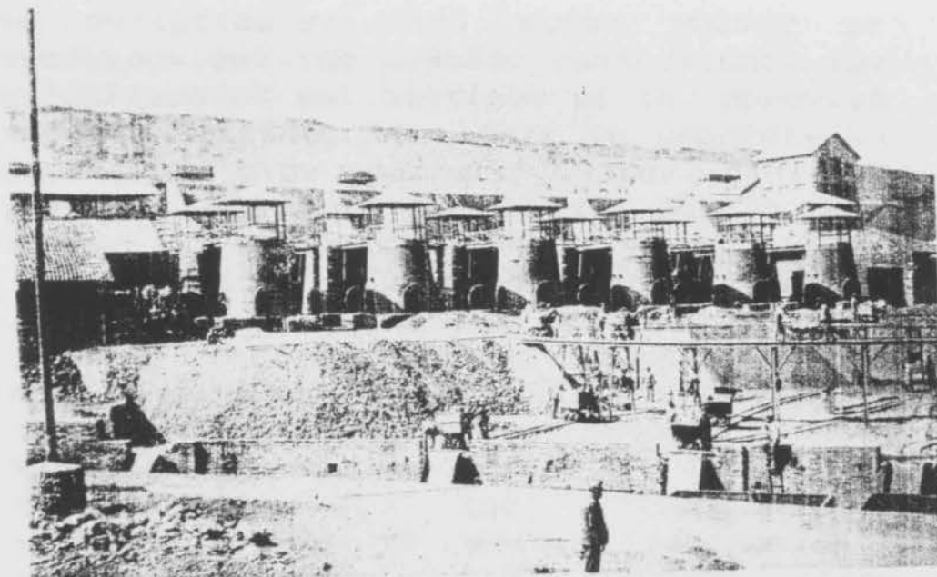
ΚΑΜΙΝΟΙ ΚΑΛΑΜΙΝΑΣ ΤΗΣ ΓΑΛΛΙΚΗΣ ΕΤΑΙΡΕΙΑΣ ΤΗ ΔΕΚΑΕΤΙΑ ΤΟΥ 1920
