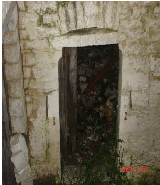
Η θύρα με ανάγλυφη διαμόρφωση στο άνω μέρος των παραστάδων και τοξωτό φεγγίτη
