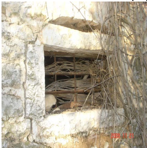
Τα παράθυρα με το τυφλό φεγγίτη στο άνω μέρος του πρεκιού
