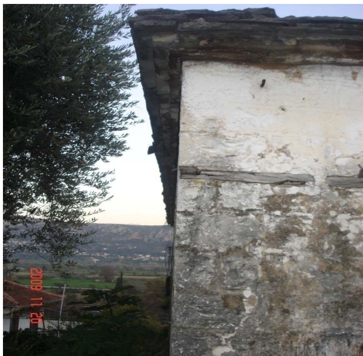
Αποσαθρωμένο κονίαμα δομής
