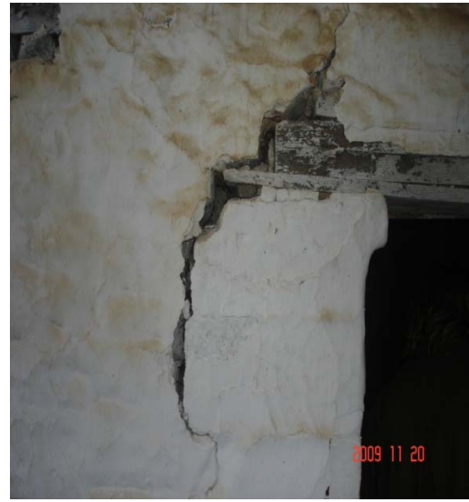
Ρηγάτωση τοιχοποιίας
