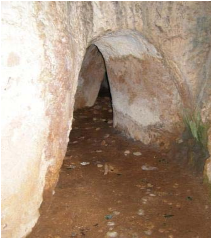
Εσωτερικό Υπόγειας σήραγγας στην περιοχή του του Κοκκινόπηλου
