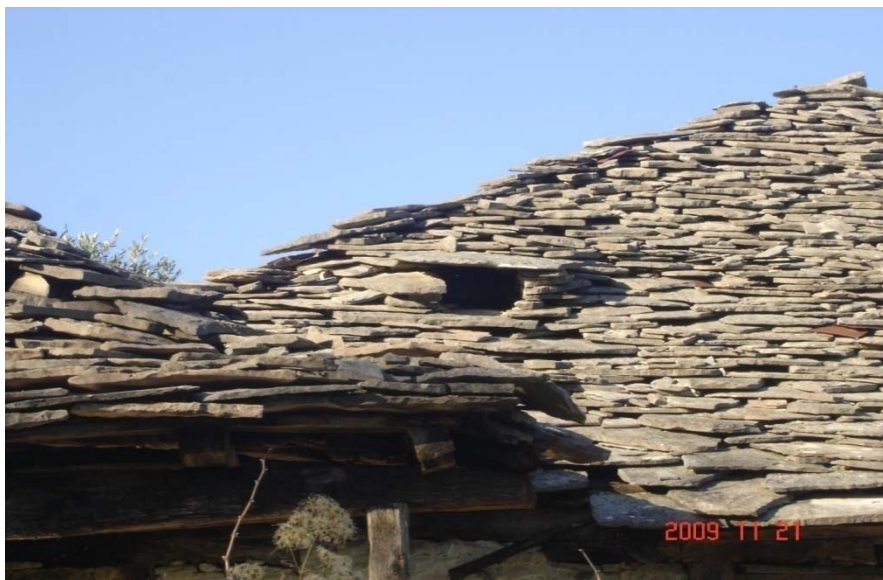
Μικρό άνοιγμα στη στέγη
