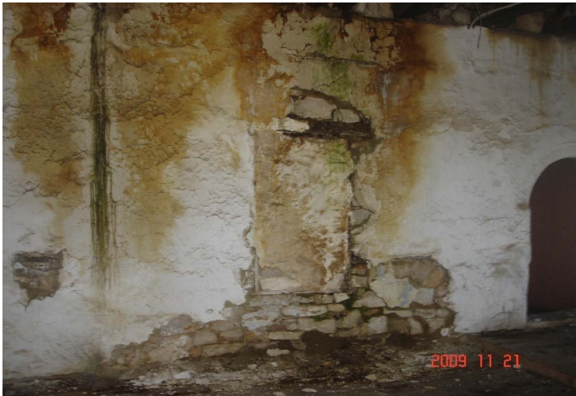
Αποσαθρωμένο κονίαμα δομής
