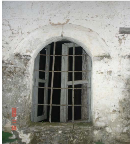
Τα μεσαίου μεγέθους παράθυρα με τη τοξοτή απόληξη στο πρέκι.
