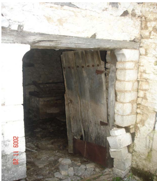
Θύρα με διαμορφωμένη μείωση στο άνω μέρος των παραστάδων.
