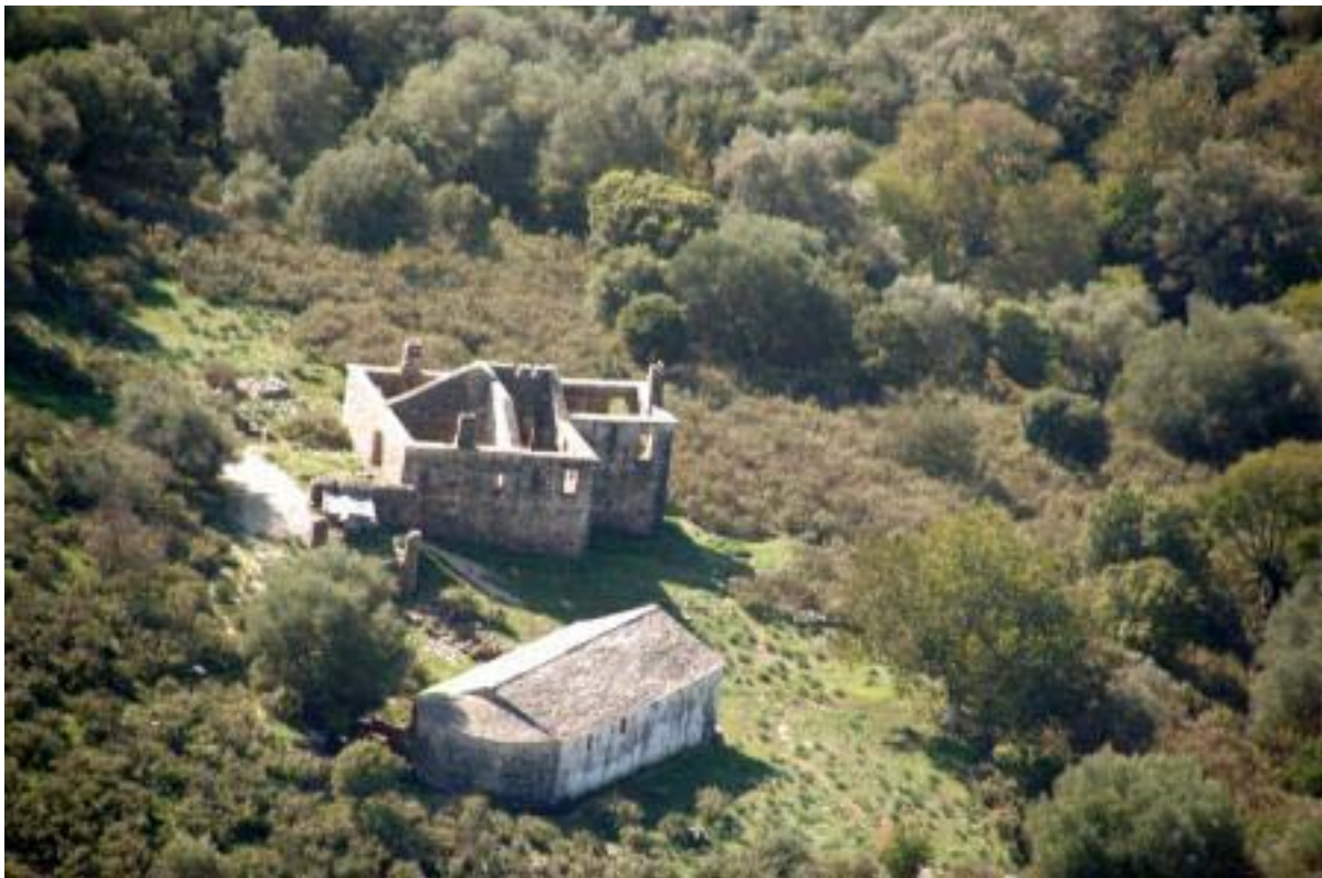
Αεροφωτογραφία του συγκροτήματος κτιρίων της Ι.Μ. Κοιμήσεως της Θεοτόκου
