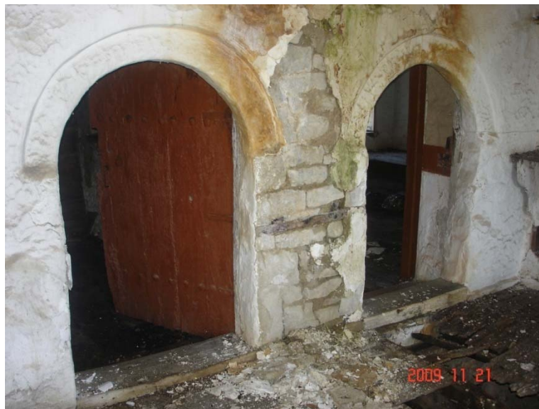
Τοξωτές Θύρες στο ανώι
