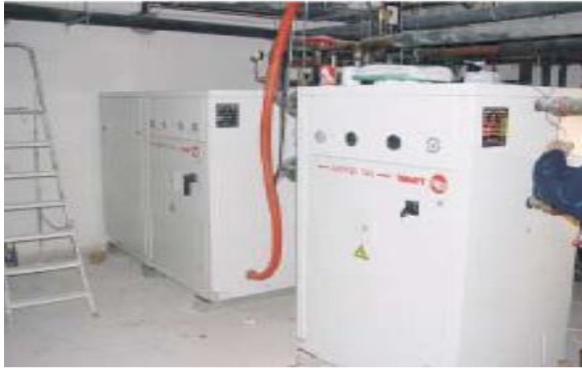
Εικ.3.20 Γεωθερμική αντλία θερμότητας
