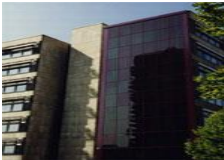
Εικ. 3.8 Φωτοβολταϊκά σε όψη κτηρίου
