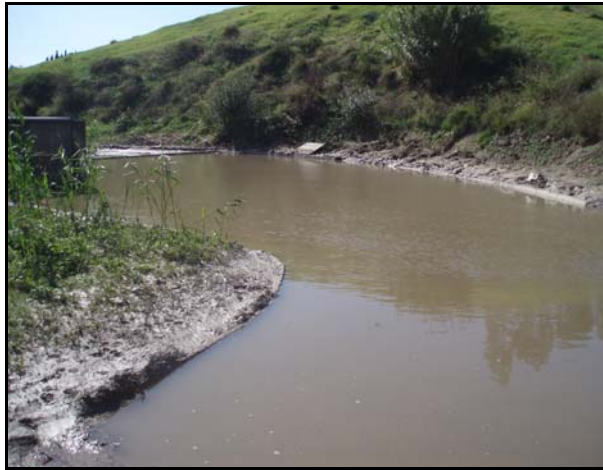
Εικόνα 3.80: Σημείο εισροής νερού στο πάρκο.
