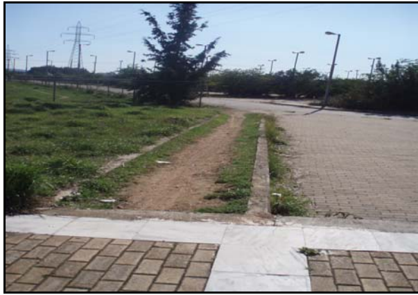
Εικόνα 3.22: Ράμπα για ΑΜΕΑ
