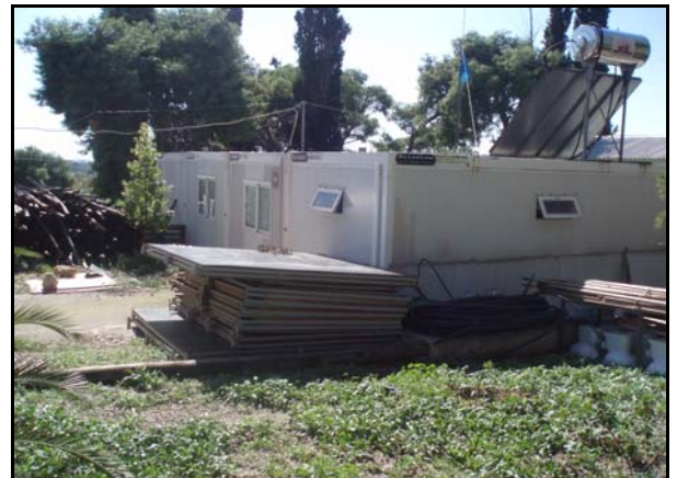
Εικόνα 3.67: Λυόμενη εγκατάσταση Σ.Ε.Π
