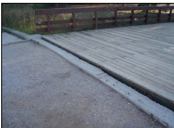
Εικόνα 3.33 : Γέφυρα στη λίμνη Ναϊάδα.
