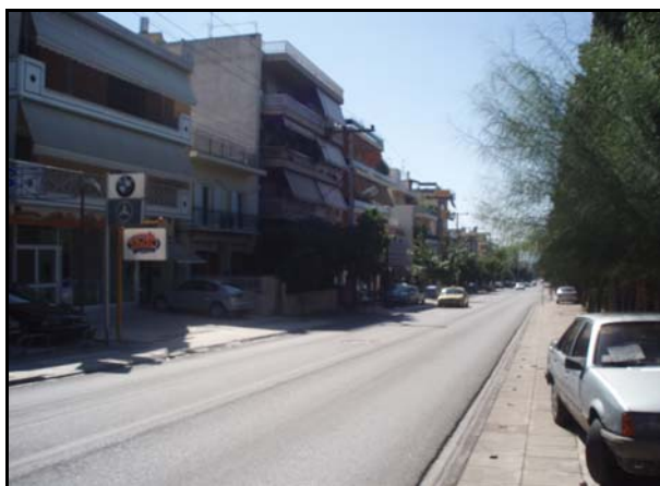
Εικόνα 1.18 : Φωτογραφία επί της οδού Δημοκρατίας
