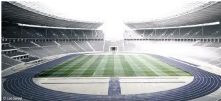
Εικόνα 1.7: Ενδοδαπέδια Θέρμανση σε Στάδιο
