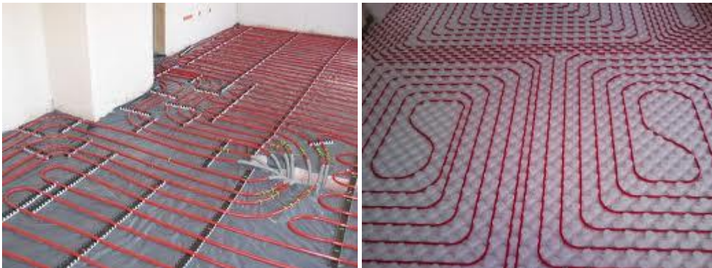
Εικόνα 1.8: Εγκατάσταση Ενδοδαπέδιας Θέρμανσης
