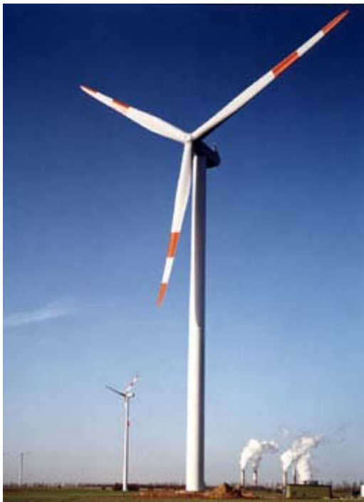
Εικόνα 4.1 σωληνωτός πύργος Α/Γ οριζοντίου άξονα
