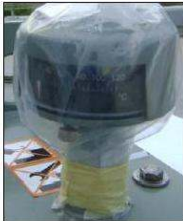
Σχήμα 5.11: Θερμόμετρο ΜΣ
