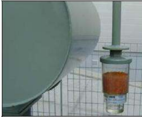
Σχήμα 5.14: Αφυγραντήρας
