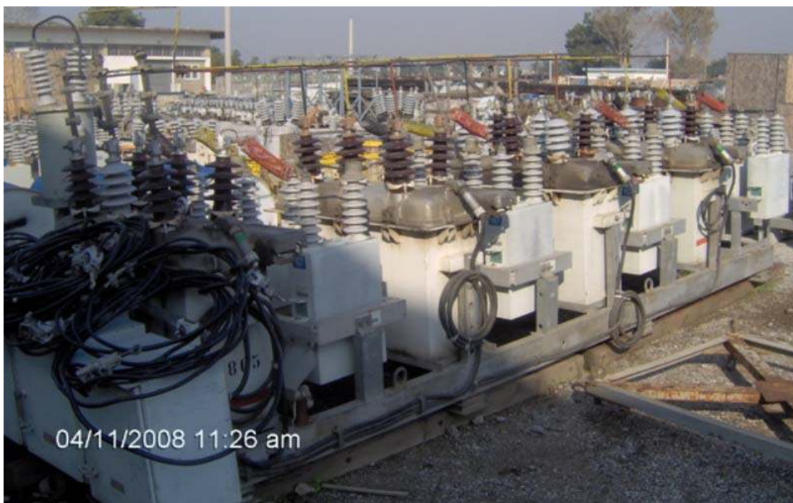
Σχήμα 6.6: Συστοιχία αποζεύξιμων πυκνωτών
