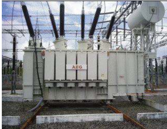
Σχήμα 5.2: ΜΣ υποσταθμού 250 MVA
