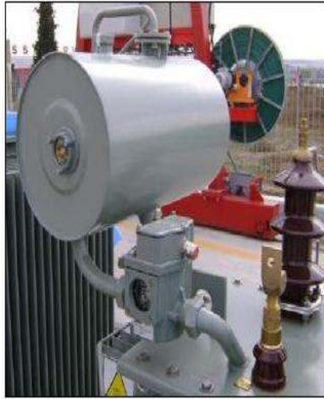
Σχήμα 5.10: Δοχείο Διαστολής και HN Buchholz
