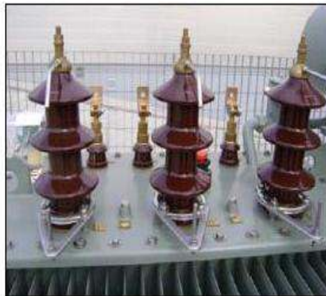
Σχήμα 5.7: Ακροδέκτες ΥΤ και ΧΤ
