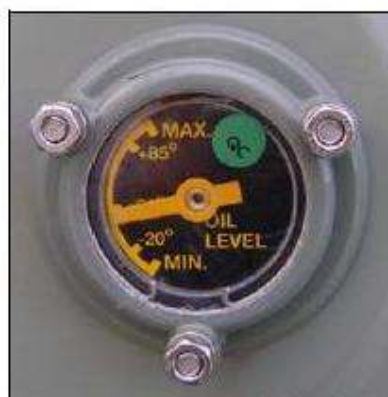
Σχήμα 5.13: Στάθμη λαδιού στο Δοχείο διαστολής
