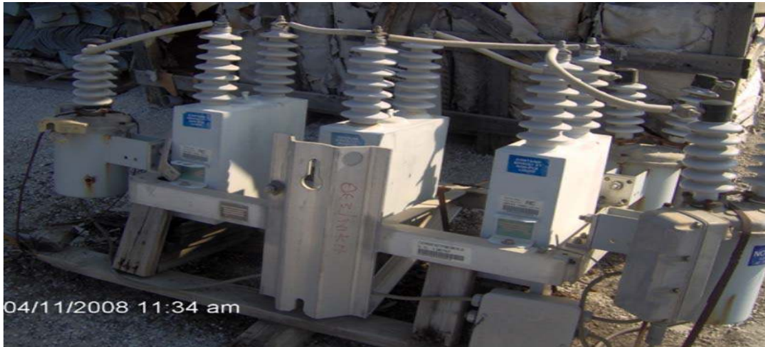
Σχήμα 6.5: Συστοιχία μόνιμων πυκνωτών σε συνδεσμολογία αστέρα
