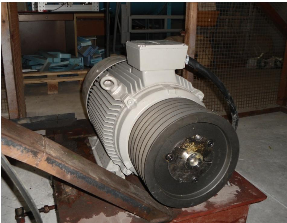
Εικόνα 5: Φωτογραφία από την τοποθέτηση του επαγωγικού κινητήρα στο Εργαστήριο Μετρήσεων Τεχνικών Μεγεθών
