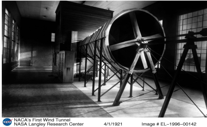
Εικόνα 1.1: Ατμοσφαιρική αεροσήραγγα 5 ποδών (1.5m) του ερευνητικού κέντρου Langley της NASA (Langley Research Center Hampton, Va).
