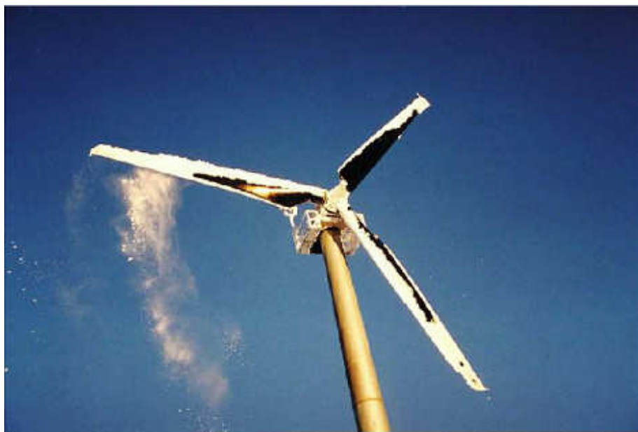
Εικόνα 5.2 : Παγετός σε ανεμογεννήτρια
