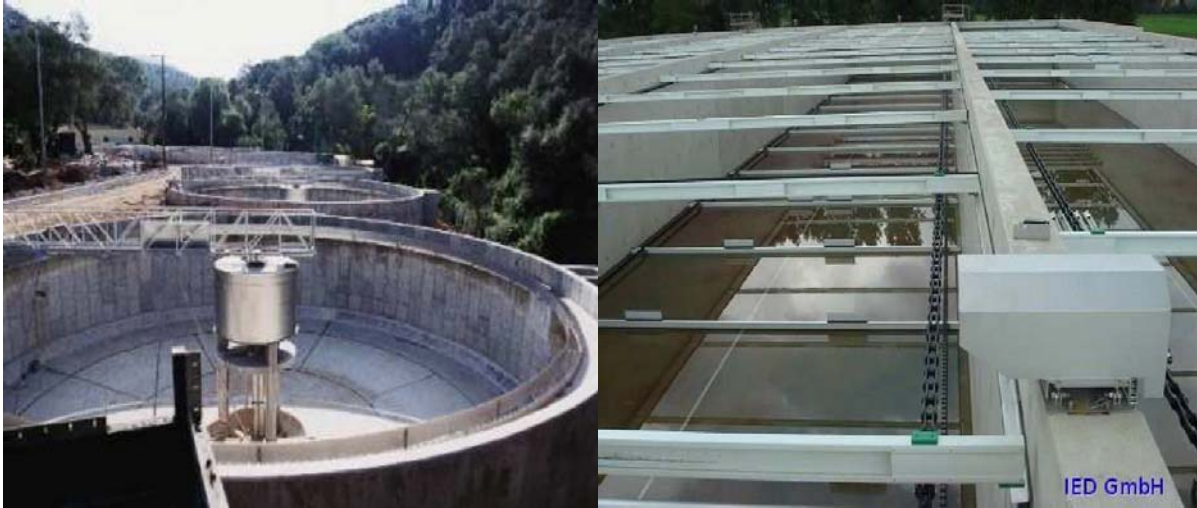
Εικόνα 3.3. Κυκλική και ορθογώνια δεξαμενή καθίζησης
