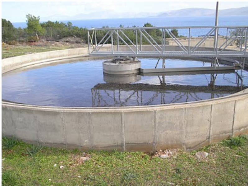
Εικόνα 3.8. Κυκλικές δεξαμενές καθίζησης Ερμιονίδας
