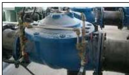
Εικόνα 2.9 Ηλεκτροβάνα
