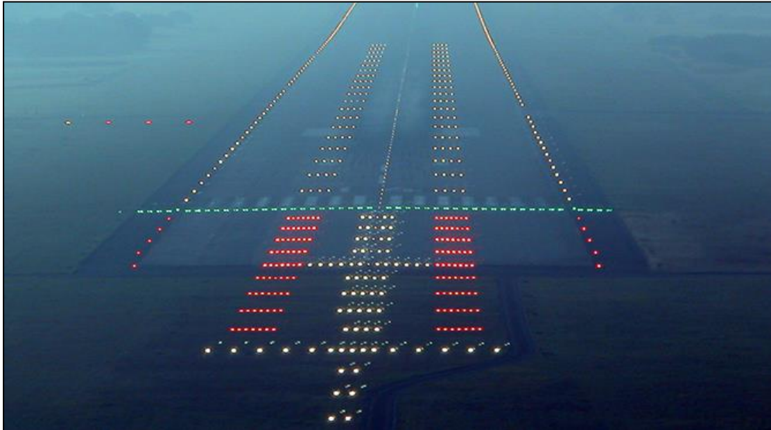
Εικόνα: Διάδρομος με ολοκληρωμένο σύστημα ακριβούς προσέγγισης II, III
