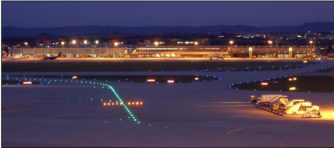
Εικόνα: Φώτα σήμανσης τροχοδρόμων
