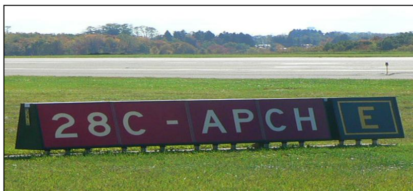
Εικόνα: Πινακίδα απαγόρευσης και πληροφοριών τροχοδρόμου
