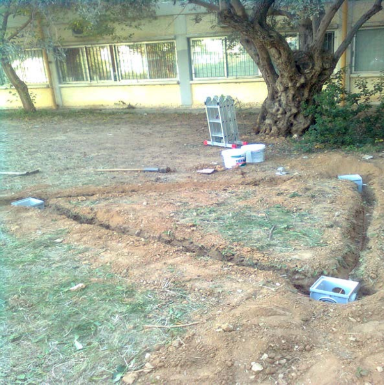
Εικόνα 2 Βασικό σκάμμα τριγώνου γείωσης
