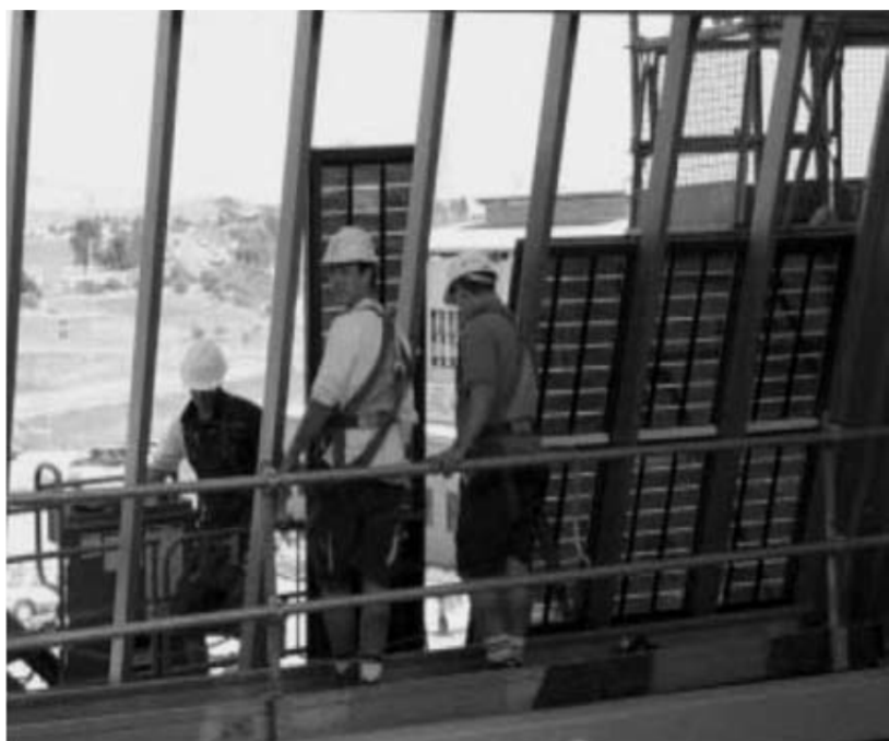
Σχήμα 4.25 Μια από τις προσόψεις του νέου Ενεργειακού Κέντρου CSIRO, στο Νιουκάσλ (Αυστραλία), έγινε με χρήση ηλιακών πάνελ τοίχου της Dyesol. (Φωτογραφία από CSIRO και Dyesol).
