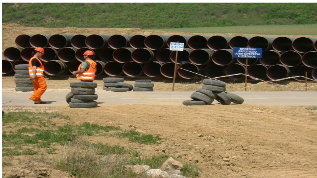
Εικόνα 35 - Σωστή προειδοποιητική σήμανση - Τακτική φύλαξη και αποθήκευση υλικών - Χρήση Μ.Α.Π.
