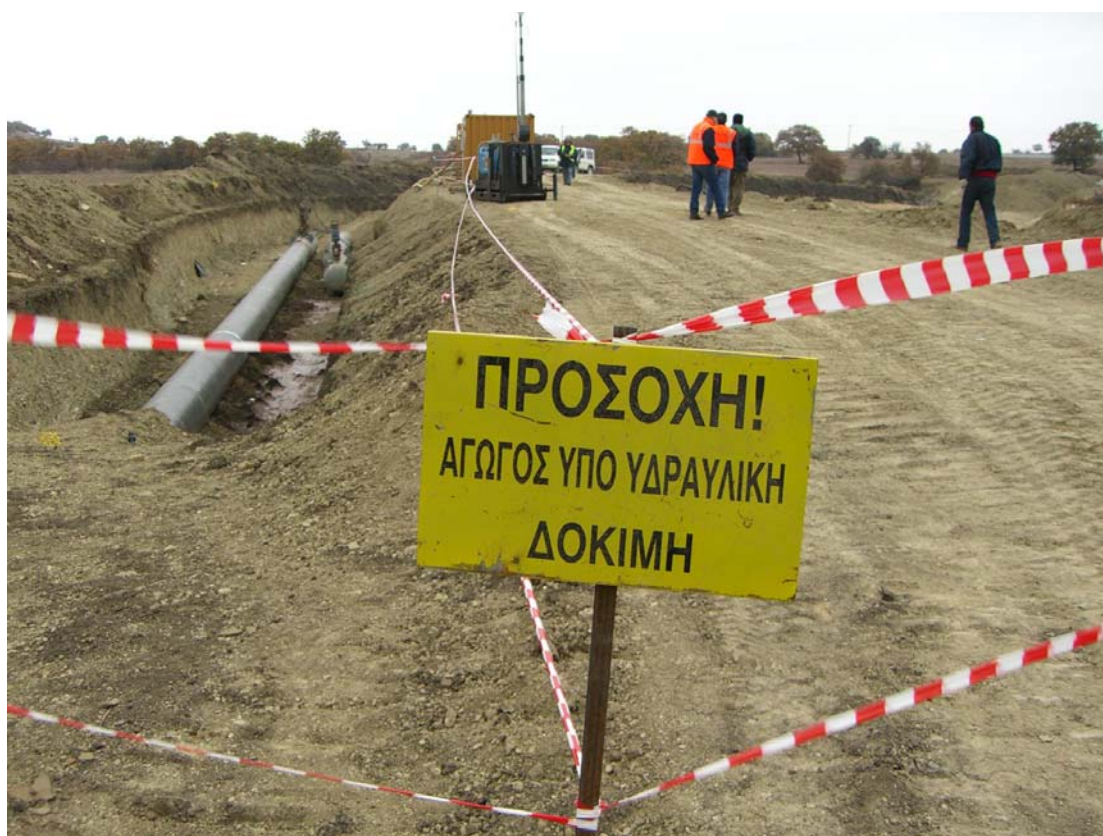
Εικόνα 33 - Σωστή προειδοποιητική σήμανση
