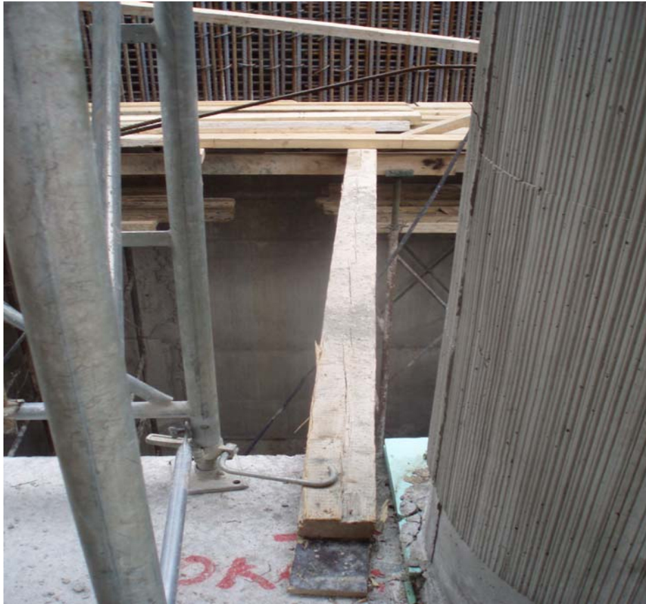
Εικόνα 13 - Απαράδεκτη έδραση σκαλωσιών
