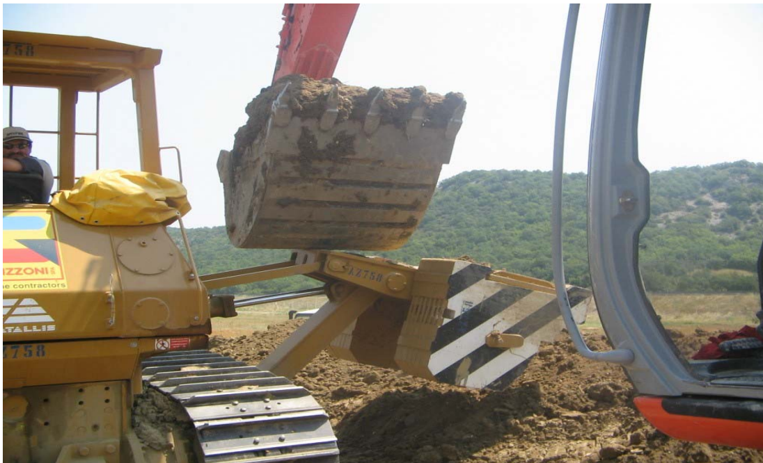
Εικόνα 39 - Πολύ κοντινή απόσταση εργασίας μηχανών
