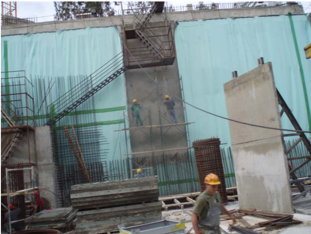
Εικόνα 7 - Μερική προστασία έναντι πτώσης. Ασφαλής περίφραξη εργοταξίου και ασφαλής σκάλα
