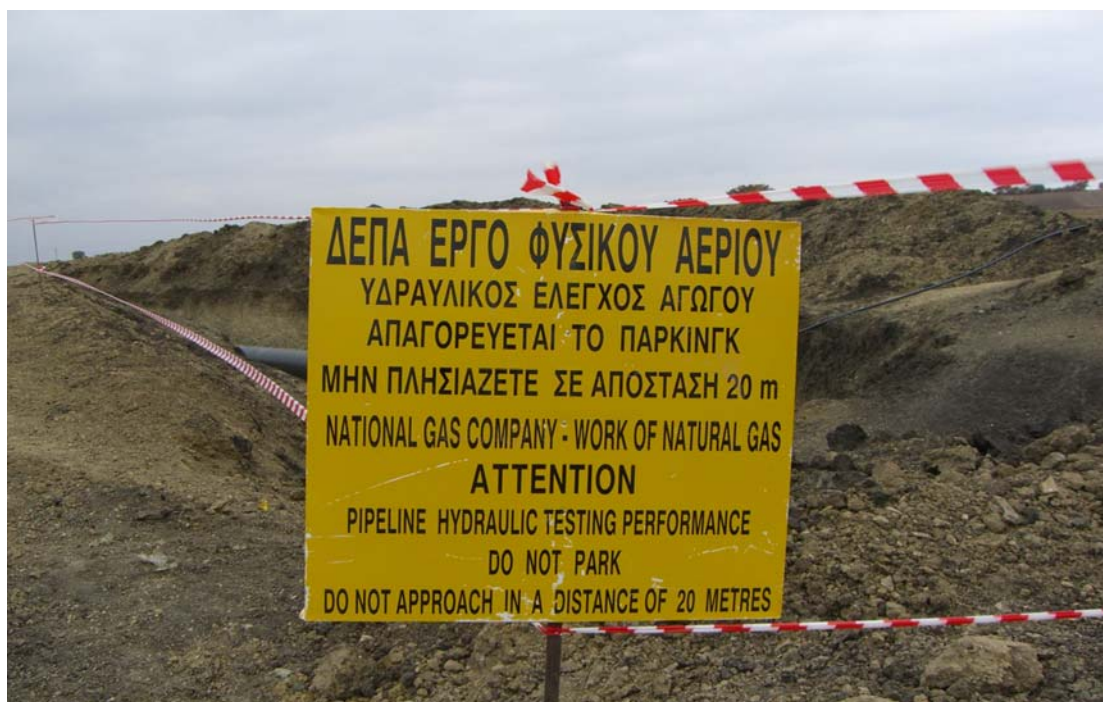
Εικόνα 32 - Σωστή προειδοποιητική σήμανση
