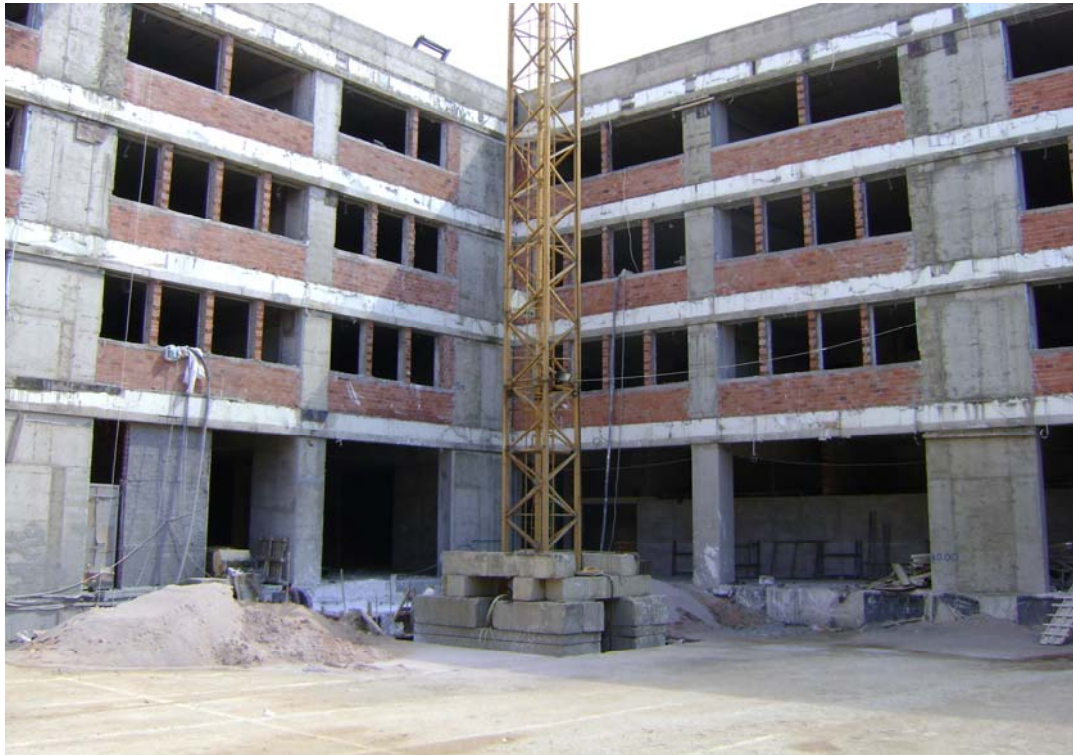
Εικόνα 42 - Σωστή έδραση γερανού
