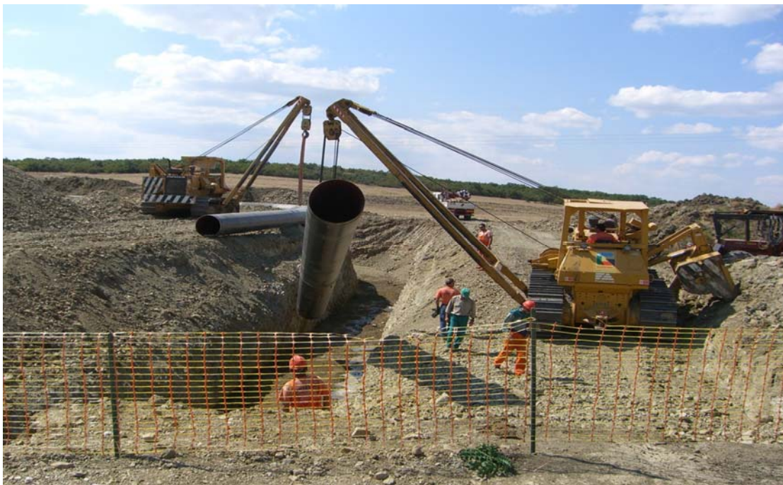
Εικόνα 31 - Σωστή περίφραξη εργοταξίου
