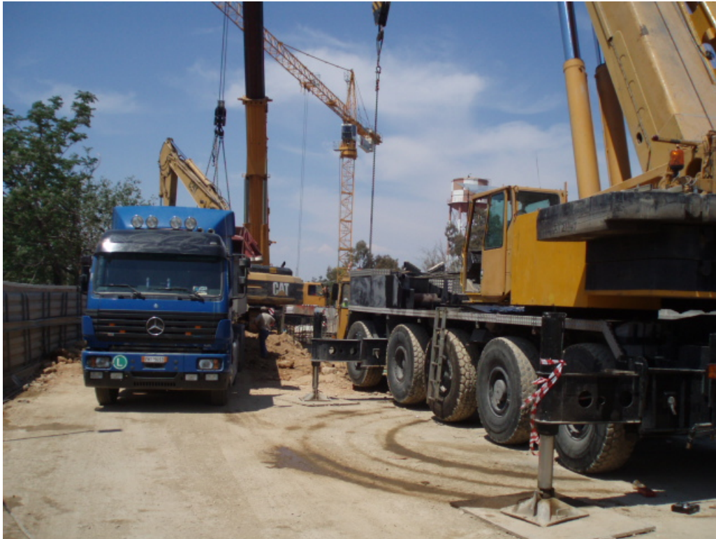
Εικόνα 19 - Καλή έδραση μηχανήματος
