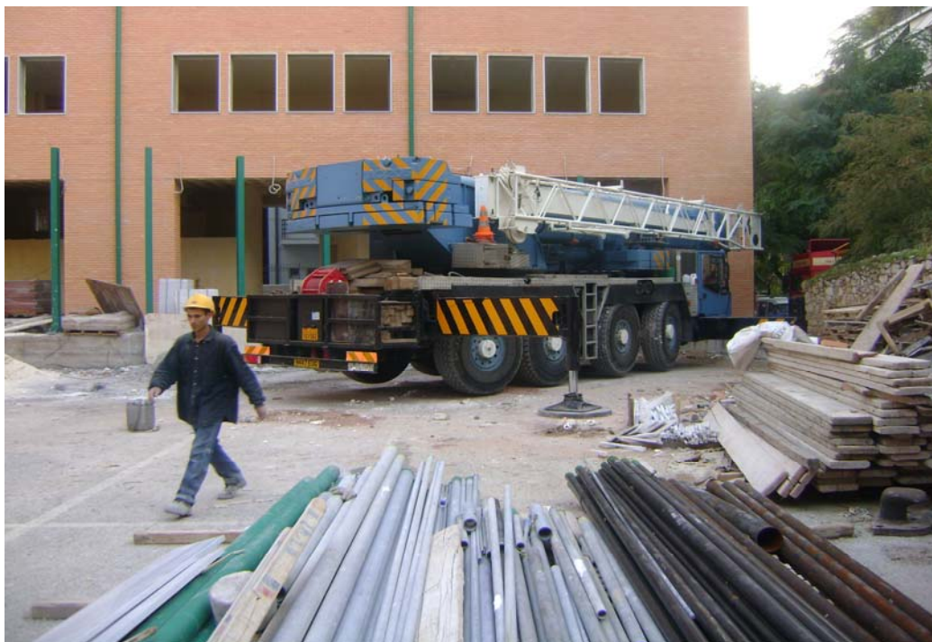
Εικόνα 43 - Σωστή έδραση μηχανήματος - Τήρηση Μ.Α.Π. - Τακτικό εργοτάξιο
