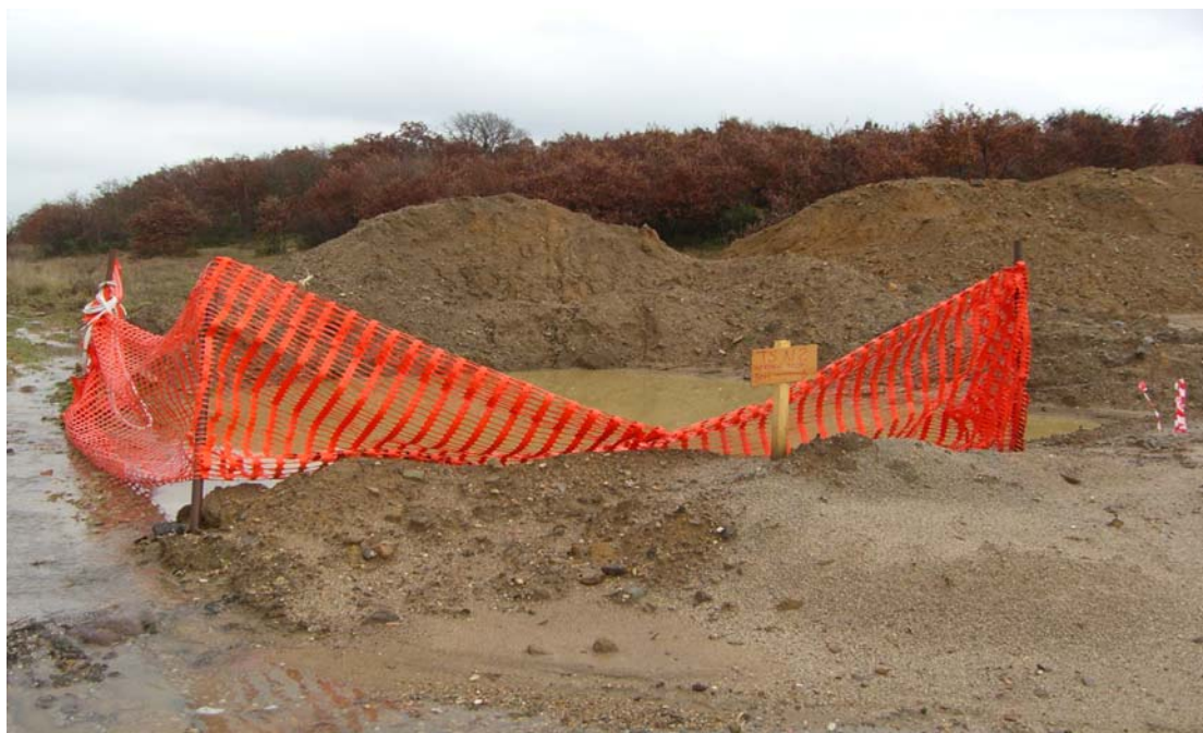
Εικόνα 34 - Σωστή περίφραξη λιμνάζοντων υδάτων
