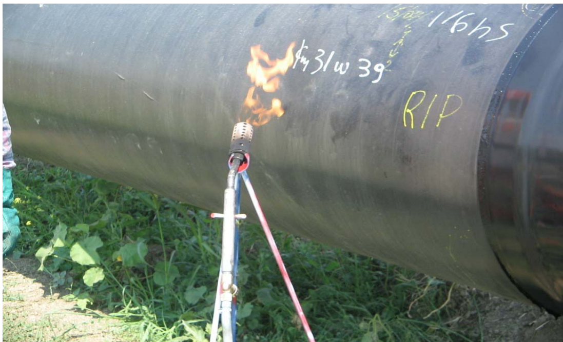
Εικόνα 29 - Αγωγός προπανίου - Σωστή στήριξη
