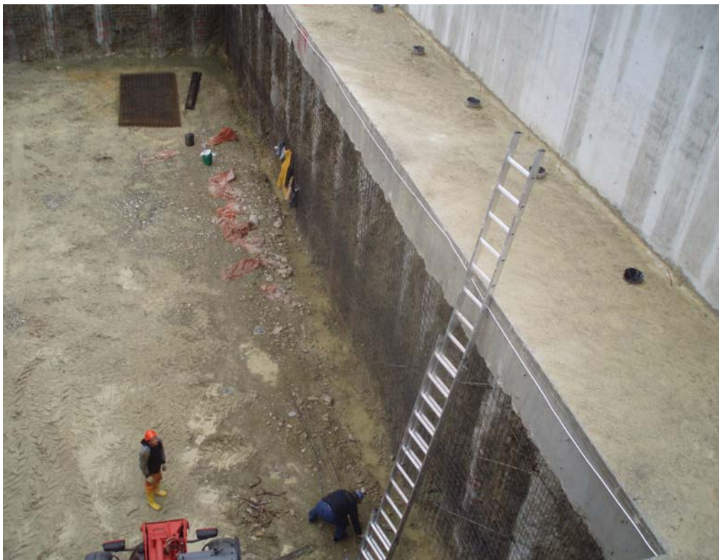
Εικόνα 14 - Η σκάλα δεν είναι δεμένη όπως πρέπει
