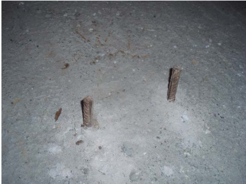
Εικόνα 2 - Δεν υπάρχει σήμανση επικινδυνότητας
