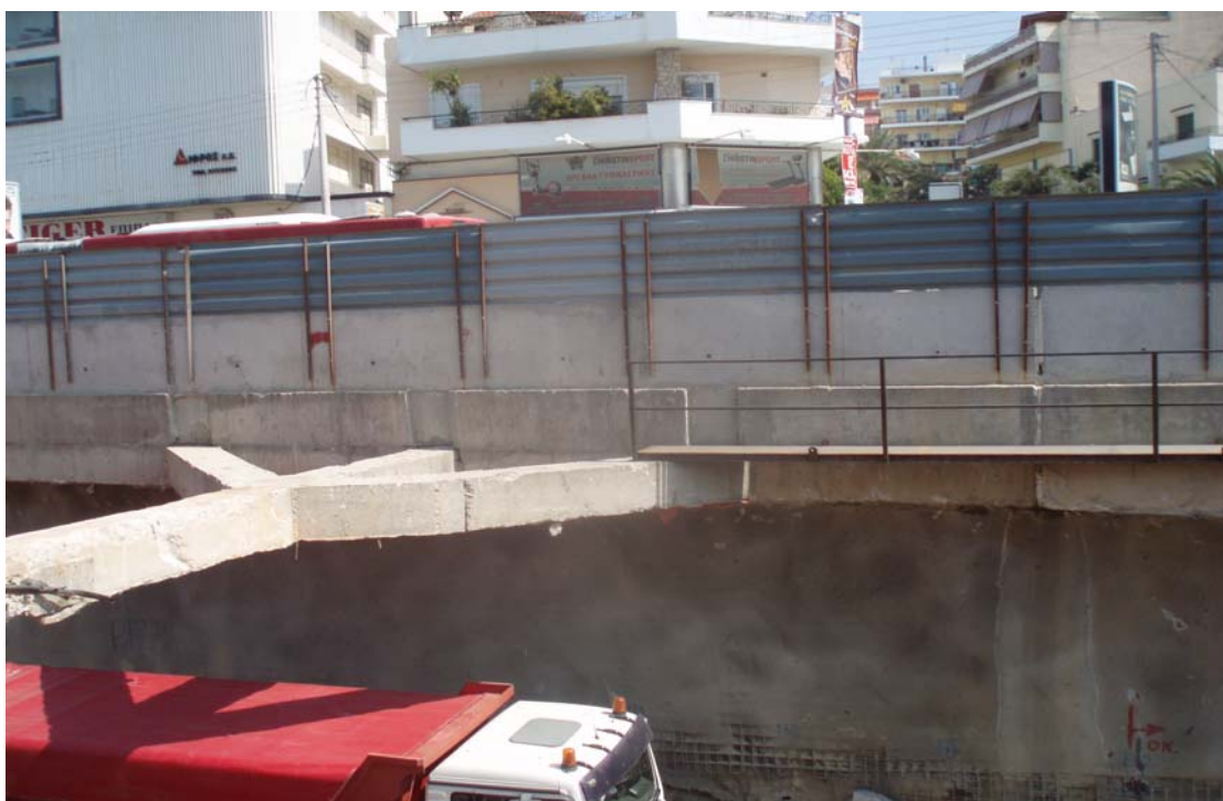
Εικόνα 11 - Ασφαλής περίφραξη του εργοταξίου
