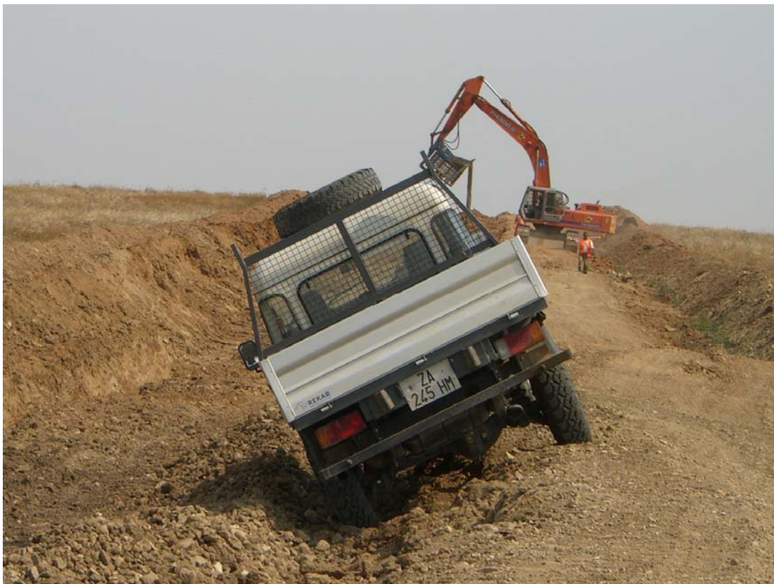
Εικόνα 37 - Αποτέλεσμα κακής περιφραξης και σηματοδότησης
