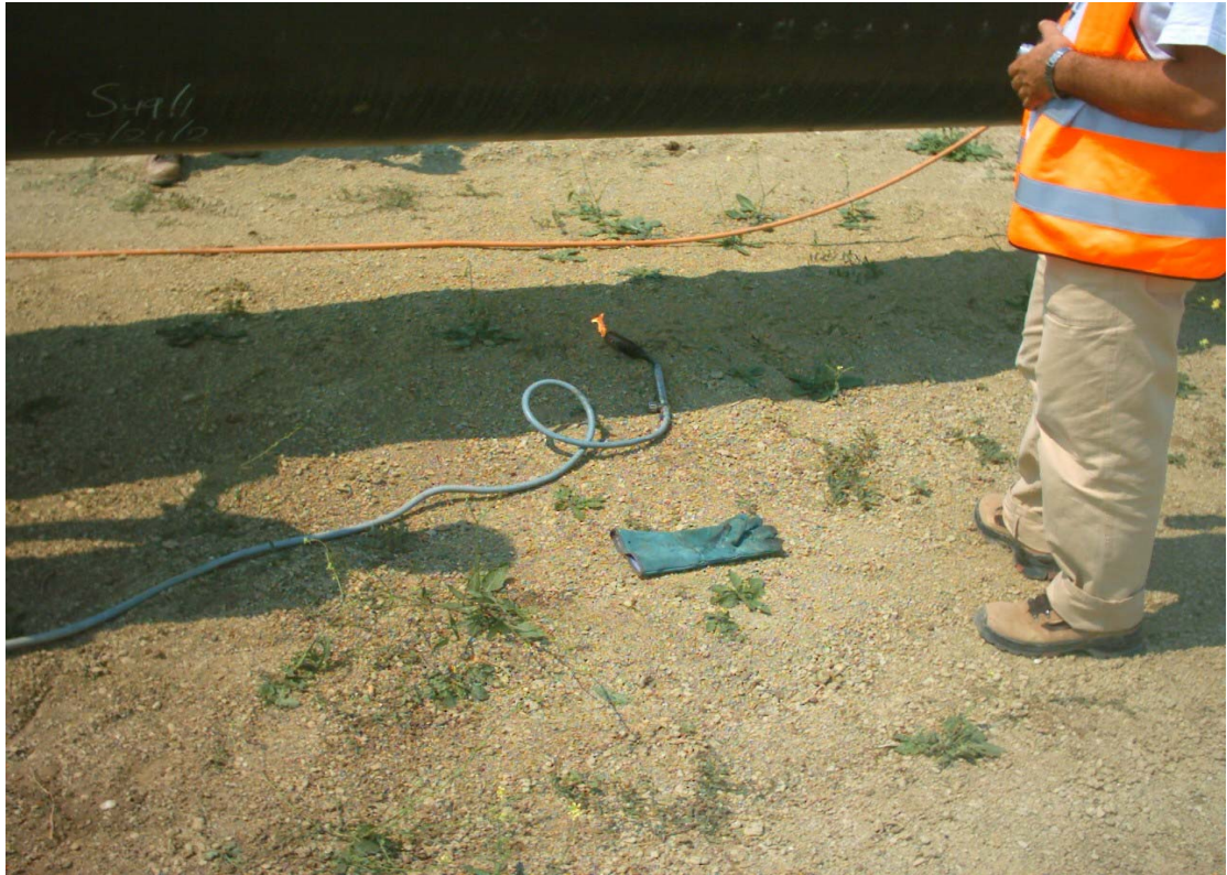
Εικόνα 28 - Αγωγός προπανίου - Απαράδεκτη στήριξη
