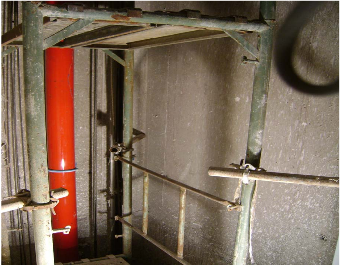
Εικόνα 44 - Σωστή συναρμολόγηση ικριώματος
