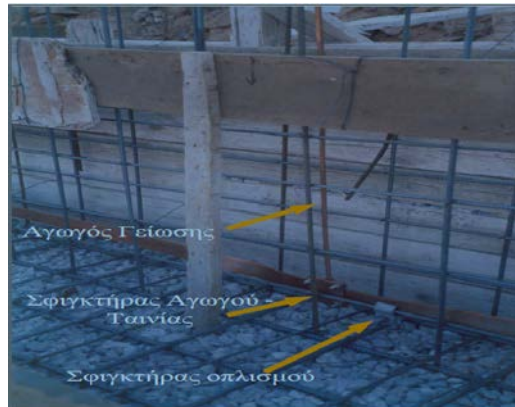
Σχήμα : Εγκατάσταση θεμελιακής γείωσης
