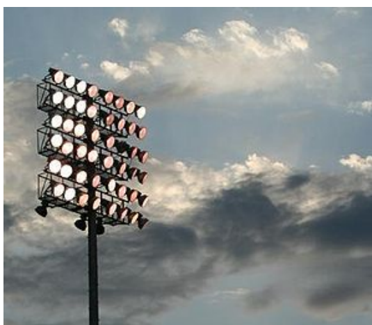
Σχήμα 2.8.: Διαφορετικά χρώματα στους λαμπτήρες ΜΗ κατά την έναυση τους
