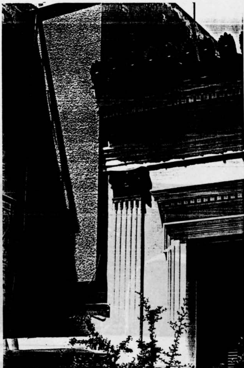
ΦΩΤΟ. 21 : Διακρίνονται αρκετά στοιχεία του νεοκλασικισμού: (από πάνω προς τα κάτω) ακροκέραμα, οδοντωτή ταινία γείσου, επιστύλιο, κιονόκρανο, παραστάδα και κορνίζα ανοίγματος.
