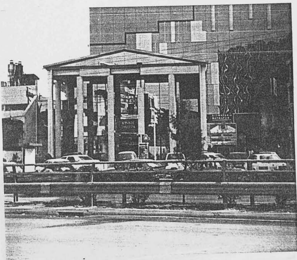
ΦΩΤΟ. 81 : Μεταμοντέρνο κτίριο επί της οδού Κηφισίας. Διακρίνεται το αέτωμα με τα διακοσμητικά υποστυλώματα καθώς επίσης και ένα κρεμαστό (!!) υποστυλώμα χωρίς στατική ή διακοσμητική λειτουργία.
