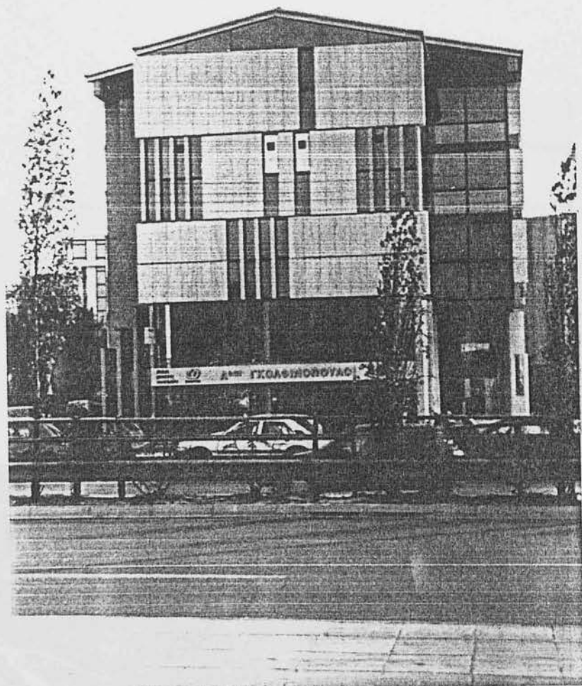
ΦΩΤΟ. 79 : Μεταμοντέρνο κτίριο επί της οδού Κηφισίας. Διακρίνεται καθαρά το αέτωμα (νεοκλασικό στοιχείο) καθώς επίσης και τα περιττά στοιχεία που << διακοσμούν >> την πρόσοψη.
