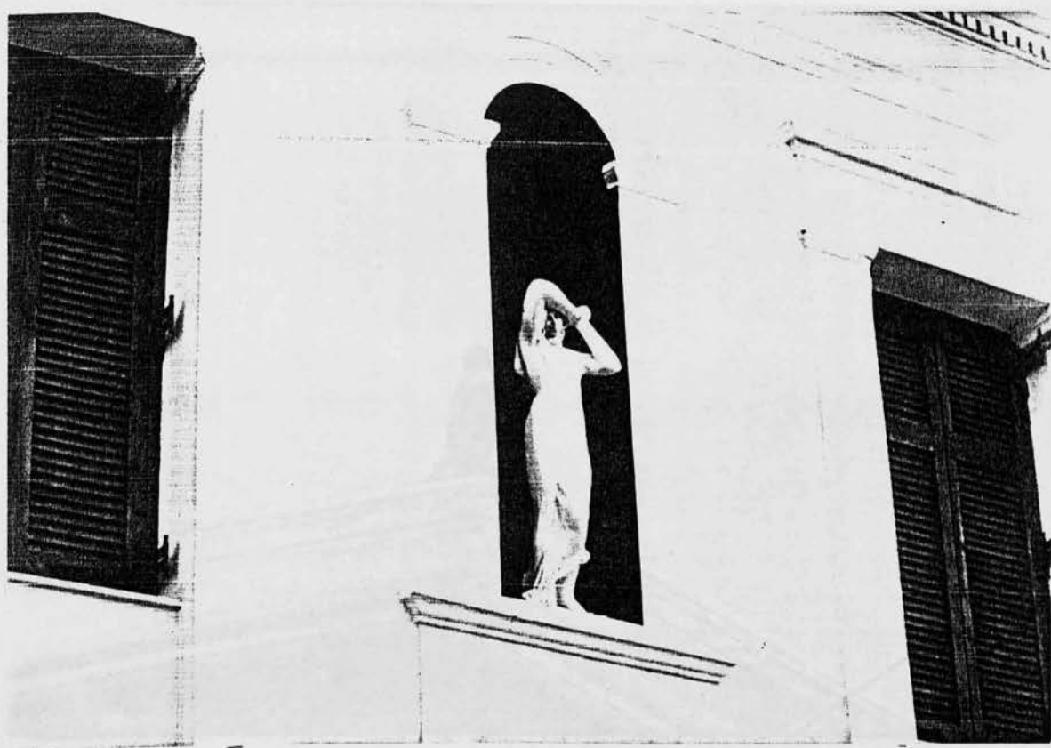
ΦΩΤΟ. 9 : Εσοχή με άγαμα, παραστάδες ειατέρωθεν και ημικυκλική κορνίζα στο πάνω μέρος.
