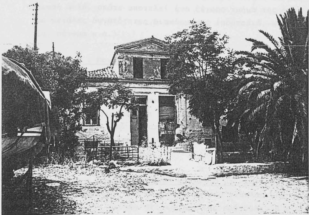
ΦΩΤΟ. 77 : Ο παιδικός σταθμός.
