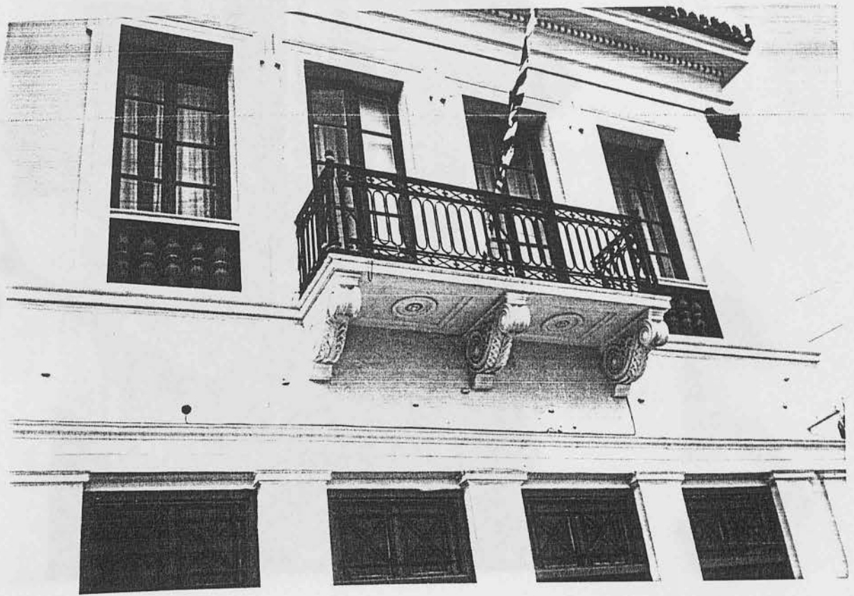
ΦΩΤΟ. 3 : Μπαλιόνι όπου διακρίνονται καθαρά α) στο πάνω μέρος σφυρήλατο χειροποίητο κιγκλίδωμα και β) στο κάτω μέρος τρία μαρμάρινα σιαλιστά διακοσμητικά φουρούσια.
