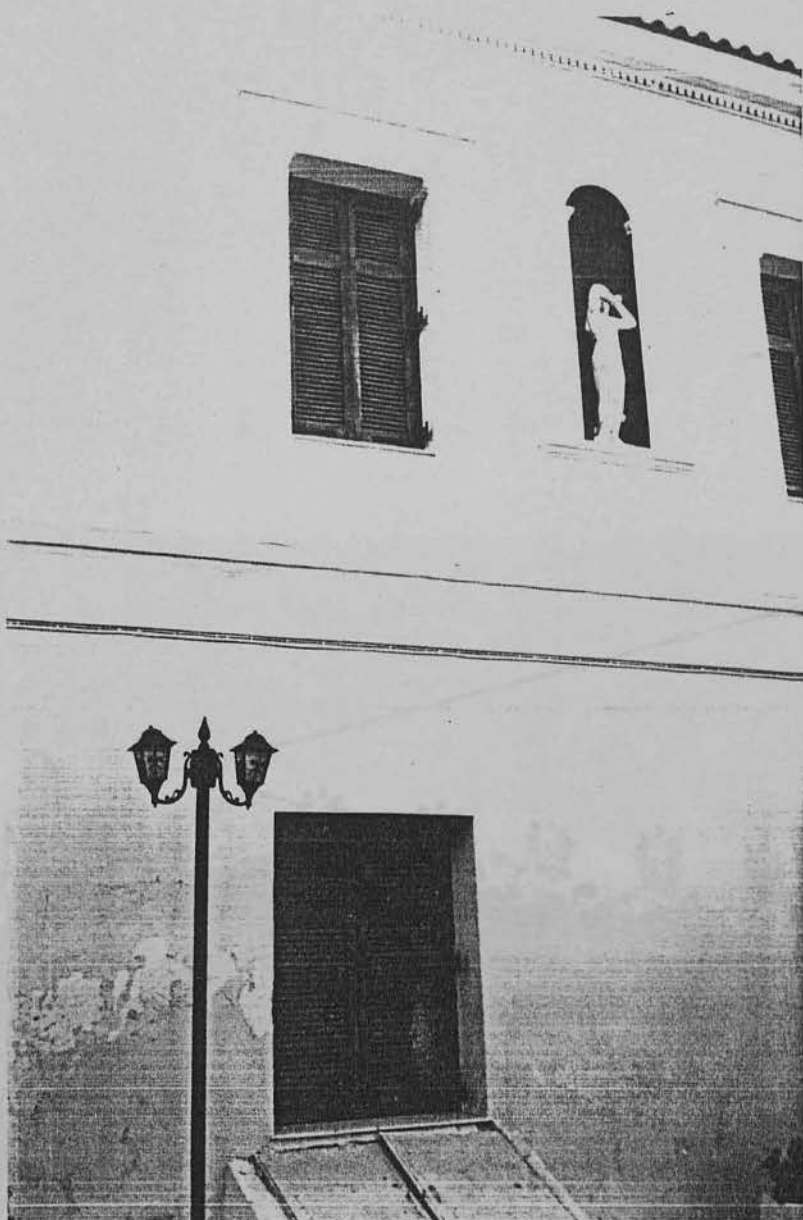
ΦΩΤΟ. 25 : Διακρίνεται καθαρά μεταξύ ισογείου και πρώτου ορόφου διακοσμητική μεσαία ζώνη.
