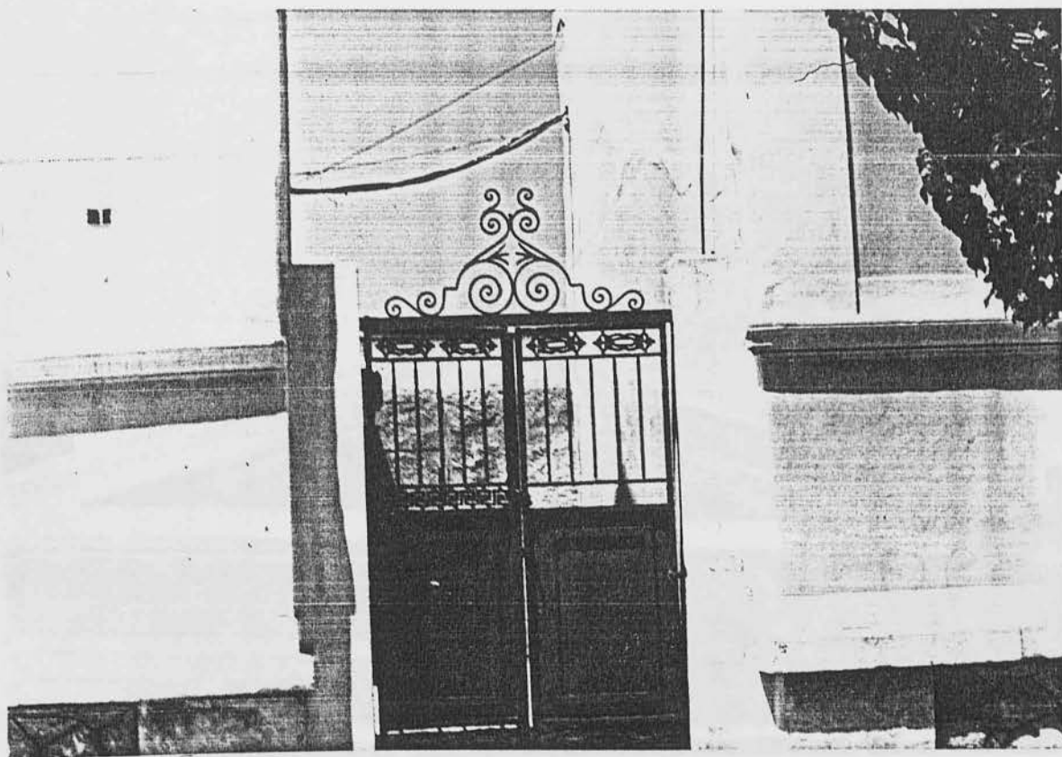
ΦΩΤΟ. 13 : Χειροποίητη μεταλλοτεχνία σε πόρτα αυλής.
