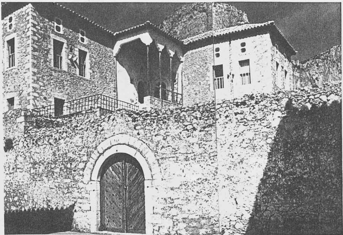
Νότια όψη. Το συγκρότημα συμπληρώνεται με ισόγειο βοηθητικό κτίσμα στο βάθος της αυλής, με ένα πλευρικό μαντρότοιχο γεμάτο πολεμίστρες.
