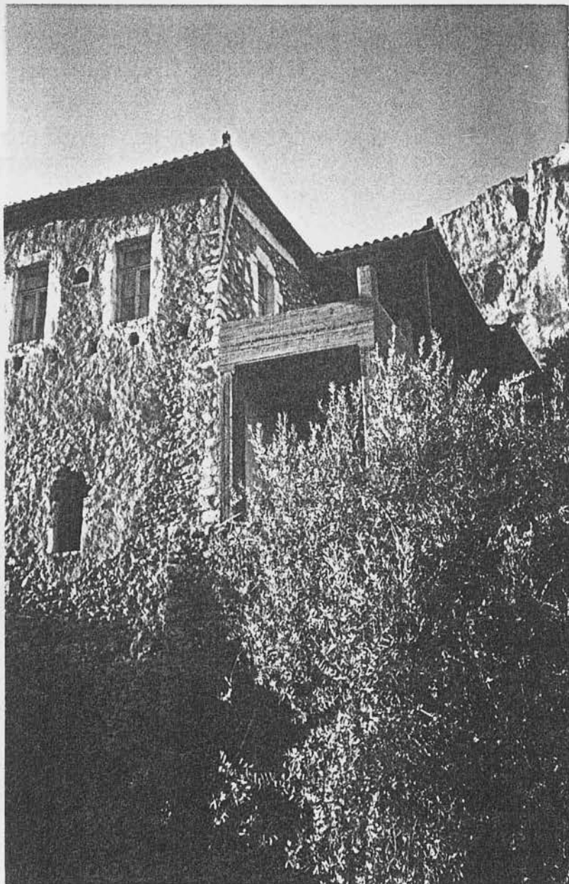
Πέτρινο παραδοσιακό διόροφο καλύβι με προσθήκη νέων στοιχείων από οπλισμένο σκυρόδεμα
