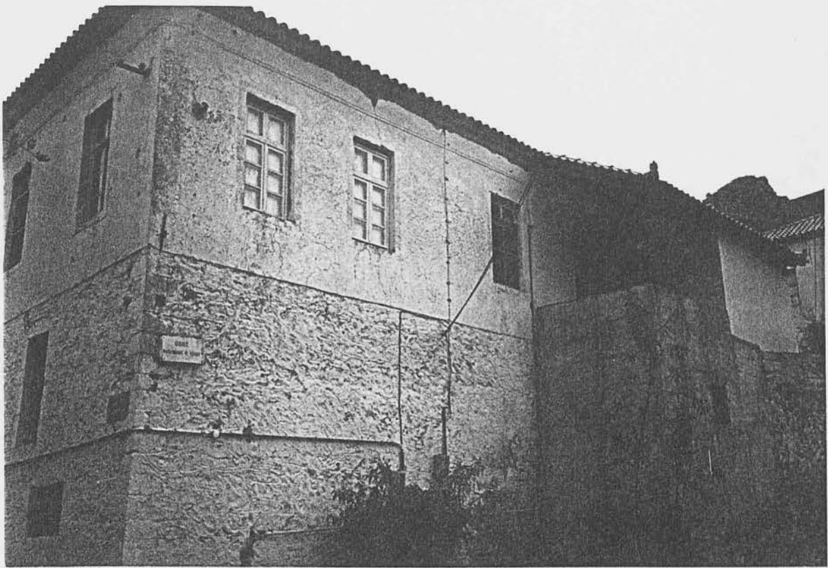
Επιδιορθωμένο διόροφο καλύβι στη στέγη και στο χαγιάτι
