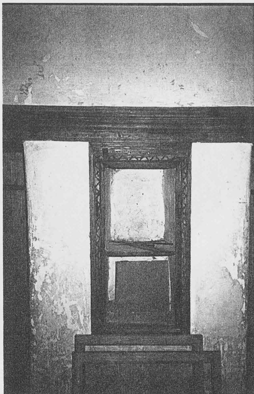
Εσοχή εσωτερικά σε τοίχο για διαμόρφωση ντουλαπιού.
