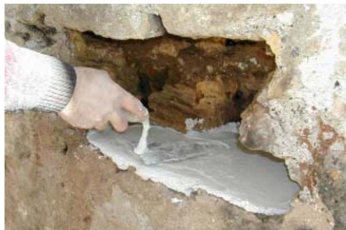
Εικ. 7.3, 7.4: Εισαγωγή νέου κονιάματος στους αρμούς της τοιχοδομής (χειρονακτικά).
