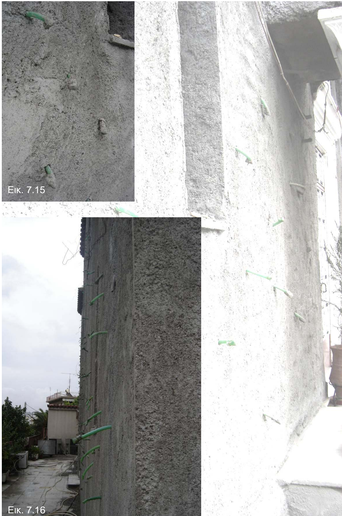
Εικ. 7.15 - 7.16: Εφαρμογή ενέσεων σε κτίριο από φέρουσα τοιχοποιία.
