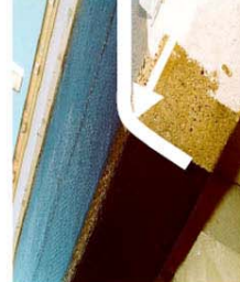
Εικόνα 4: Εξομάλυνση ακμών
