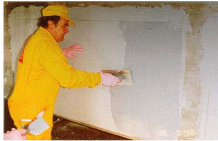
Εικόνα 6: Προεπάλειψη με Sikadur 330
