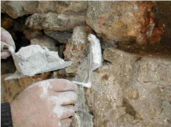
Σχ.7.2: Αρμολόγημα: α) Διεύρυνση χειλιών ρωγμής, β) εισαγωγή κονιάματος με ψιλό μυστρί και γ) διαμόρφωση τελικής επιφάνειας τοιχοποιίας με επίχρισμα.
