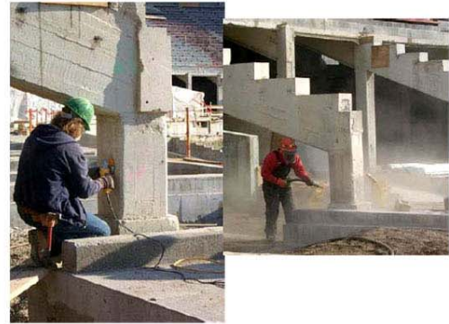
Εικόνα 2: Προετοιμασία υποστρώματος
