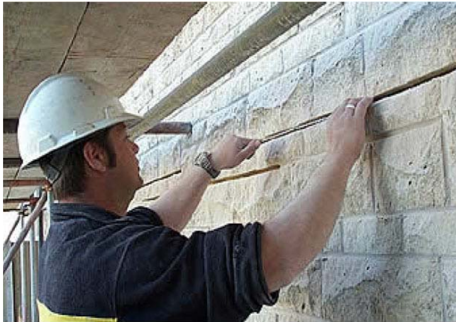
Εικ. 7.29: Εισαγωγή ράβδου σε λιθοδομή από εξειδικευμένο τεχνικό.
