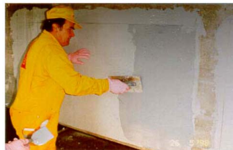
Εικόνα 6: Προεπάλειψη με Sikadur 330
