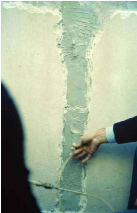
Εικ. 7.8: Εισαγωγή ενέματος σε ρωγμή.
