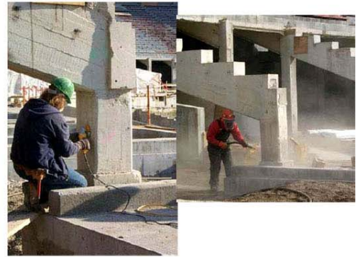
Εικόνα 2: Προετοιμασία υποστρώματος
