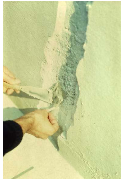
Εικ. 7.6: Προετοιμασία – στερέωση ακροφυσίων.
