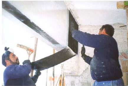
Εικόνα 7: Τοποθέτηση υφάσματος
