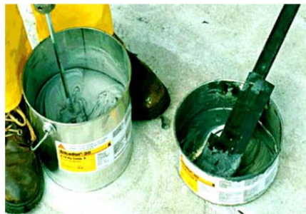
Εικόνα 5: Ανάμιξη εποξειδικής ρητίνης.
