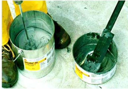
Εικόνα 5: Ανάμιξη εποξειδικής ρητίνης.
