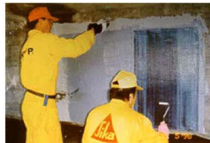
Εικόνα 8: Εμποτισμός με Sikadur 330
