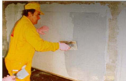
Εικόνα 6: Προεπάλειψη με Sikadur 330
