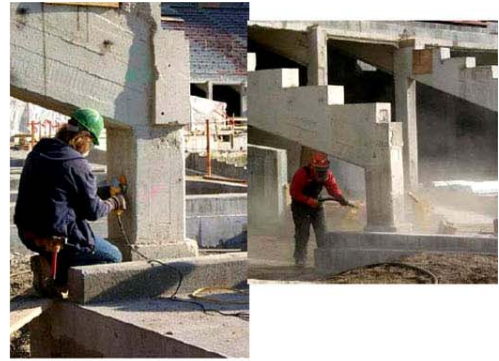
Εικόνα 2: Προετοιμασία υποστρώματος
