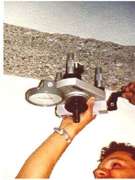
Εικόνα 1: Έλεγχος εφελκυστικής αντοχής υποστρώματος
