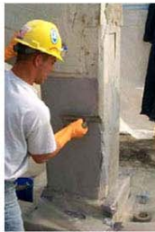
Εικόνα 3: Εξομάλυνση υποστρώματος
