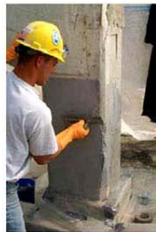
Εικόνα 3: Εξομάλυνση υποστρώματος
