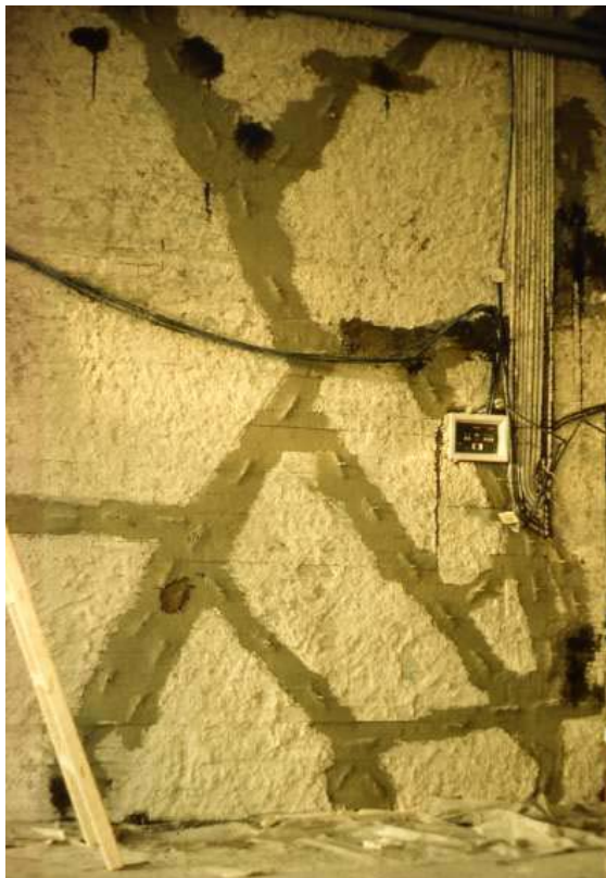
Εικ. 7.11: Τοιχοποιία ενισχυμένη με χρήση ενεμάτων.
