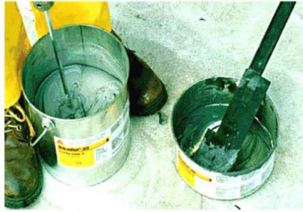
Εικόνα 5: Ανάμιξη εποξειδικής ρητίνης
