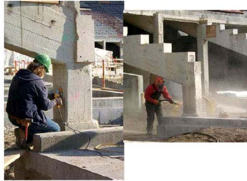
Εικόνα 2: Προετοιμασία υποστρώματος
