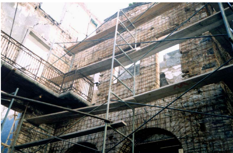
Εικ. 7.34: Ενίσχυση τοιχοποιίας με μανδύα (εκτοξευόμενου) σκυροδέματος και χρήση οπλισμού.
