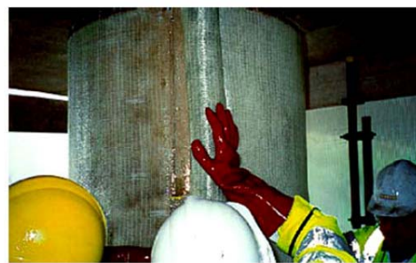
Εικόνα 8: Εμποτισμός με Sikadur 330
