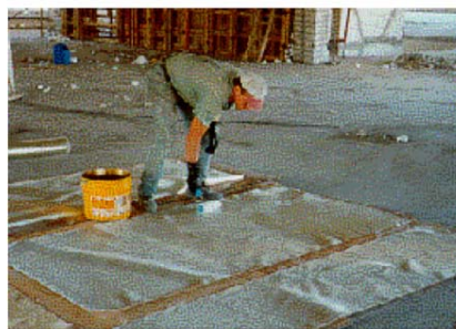
Εικόνα 7: Εμποτισμός με Sikadur 300
