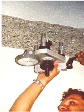
Εικόνα 1: Έλεγχος εφελκυστικής αντοχής υποστρώματος
