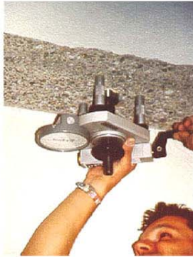
Εικόνα 1: Έλεγχος εφελκυστικής αντοχής υποστρώματος
