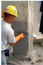
Εικόνα 3: Εξομάλυνση υποστρώματος
