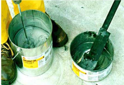
Εικόνα 5: Ανάμιξη εποξειδικής ρητίνης
