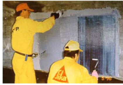
Εικόνα 8: Εμποτισμός με Sikadur 330
