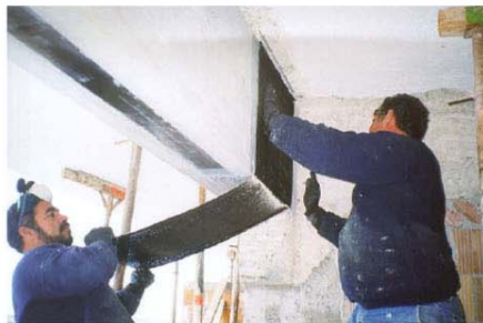
Εικόνα 7: Τοποθέτηση υφάσματος
