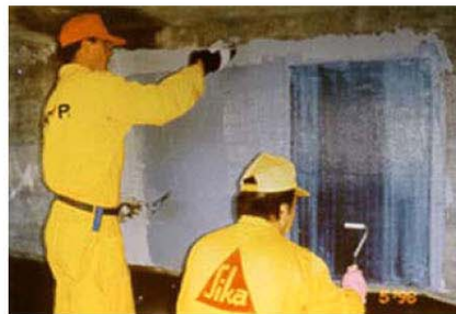
Εικόνα 8: Εμποτισμός με Sikadur 330
