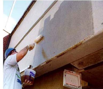
Εικόνα 6: Προεπάλειψη με Sikadur 330
