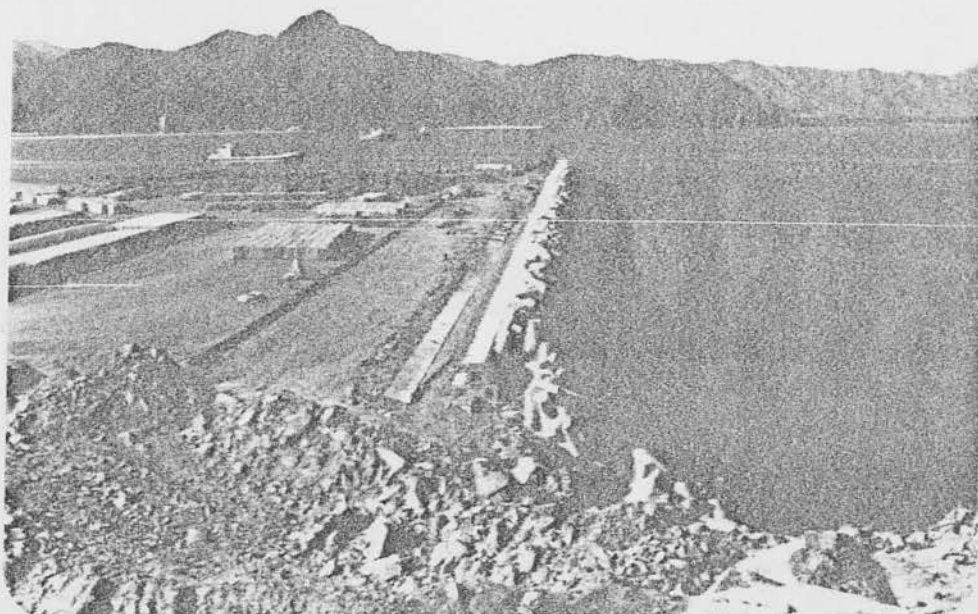
Κυματοθραύστης με προστασία πέτρας και STABITS
