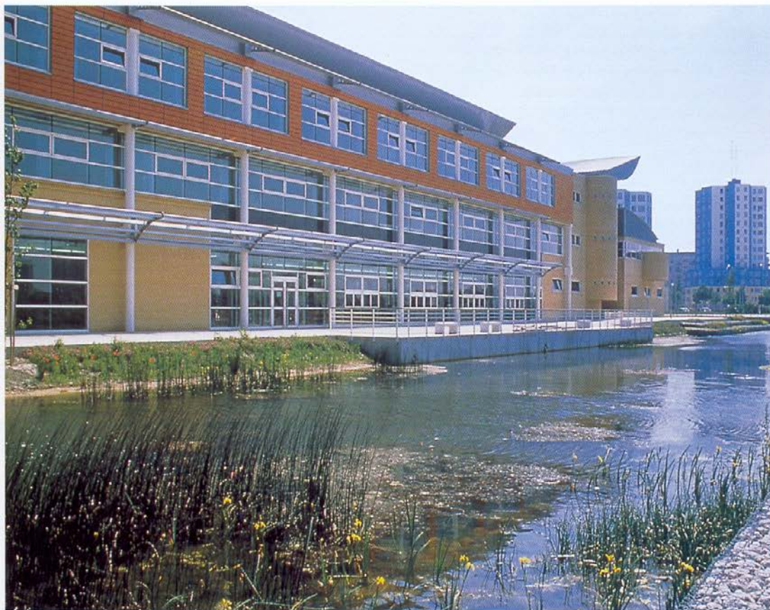
Τα νερά της βροχής ανακτώνται με συγκεντρώσή τους σε μια συλλεκτήρια λεκάνη που περιζώνει το κύριο κτίριο.
