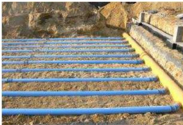
Σχήμα 1.12: Εναλλάκτης κλιματισμού εδάφους-αέρα.
