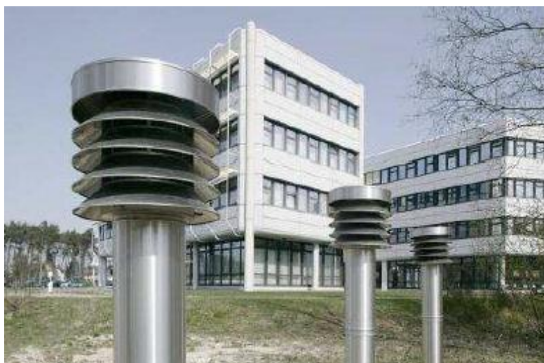
Σχήμα 1.9: Καμινάδες εξωτερικού αέρα τροφοδοσίας που χρησιμοποιούν φίλτρο G4 σύμφωνα με το DIN EN 779.
