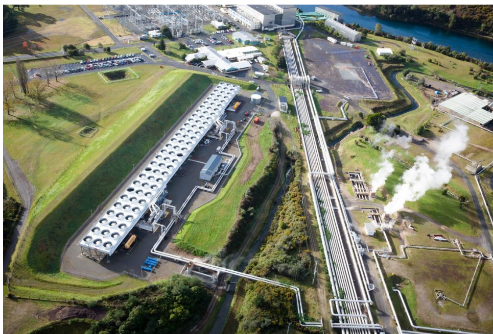
Σχήμα 4.6 Wairakei geothermal power plant (Νέα Ζηλανδία)
