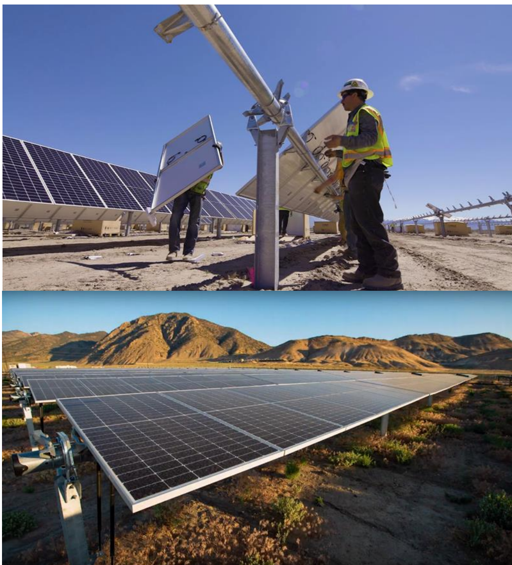
Σχήμα 7.3 Εγκατάσταση φωτοβολταϊκών πλαισίων στο Tungsten Mountain της Νεβάδα, ΗΠΑ [42].
