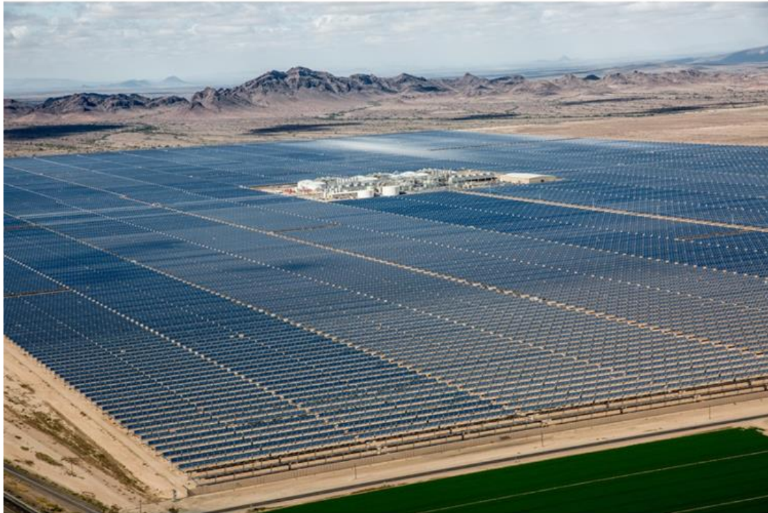
Σχήμα 5.6 Μονάδα Παραγωγής στο κέντρο της εγκατάστασης (Solana Solar Power Generation, Arizona)
