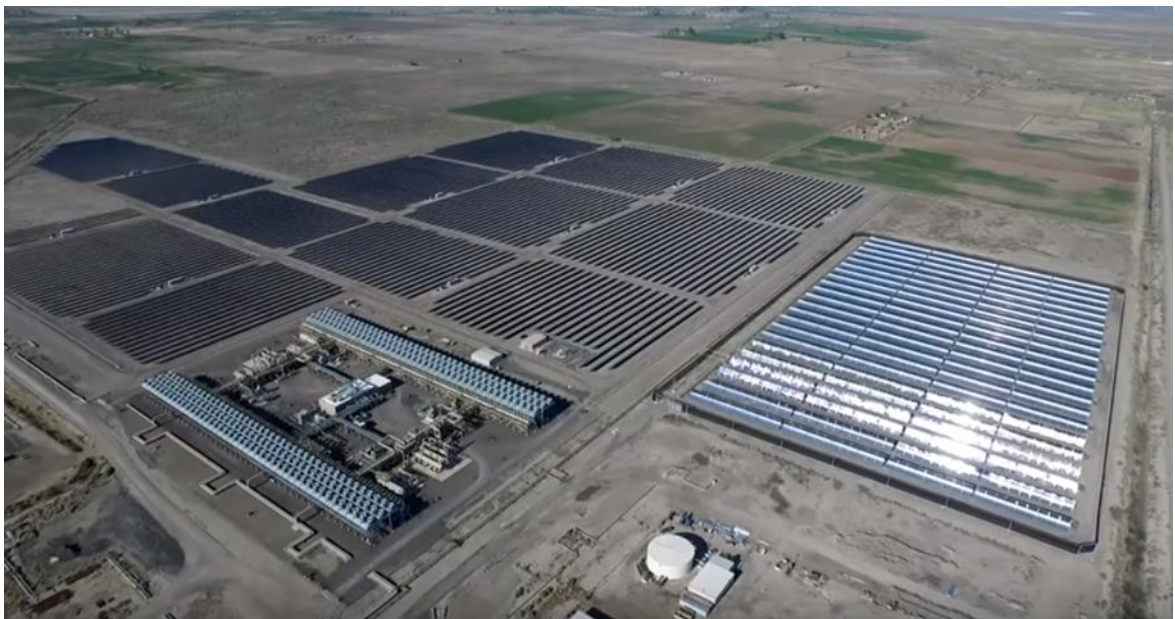
Σχήμα 7.10 Εγκατάσταση τριών ανανεώσιμων πηγών ενέργειας στο Stillwater της Νεβάδα, ΗΠΑ. (Enel's Stillwater video snapshot) [45].
