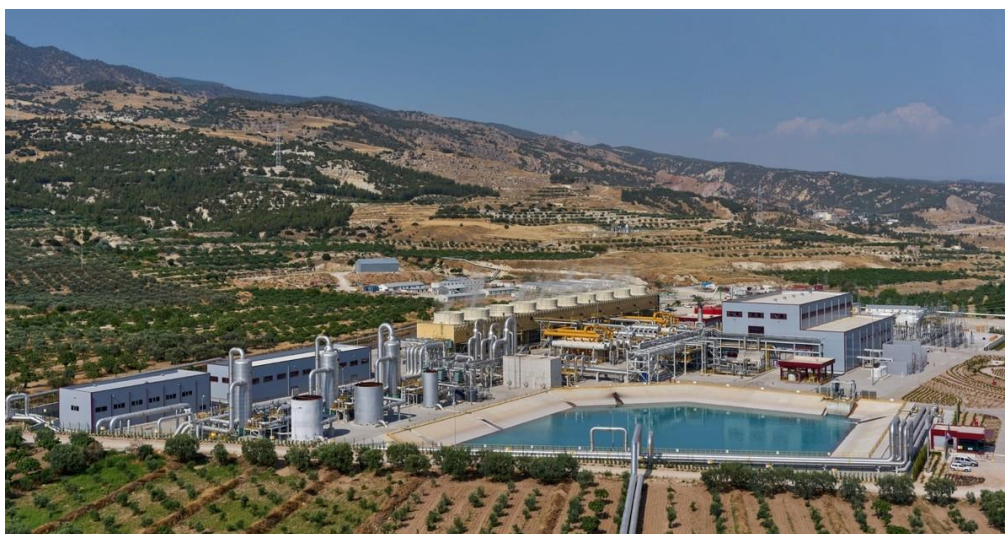
Σχήμα 4.5 Kizildere geothermal power plant (Τουρκία)
