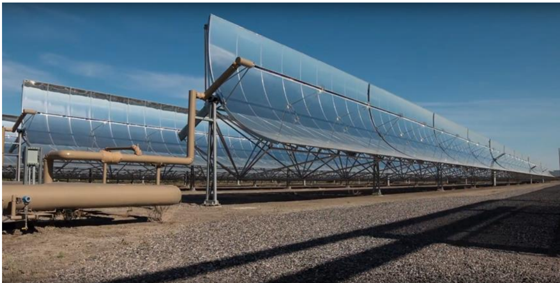
Σχήμα 7.8 Ηλιακό πεδίο παραβολικών συγκεντρωτικών συλλεκτών (CSP) στο Stillwater της Νεβάδα, ΗΠΑ. (Enel's Stillwater video snapshot) [45].
