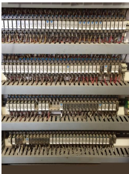
Εικόνα 1.1 Κλασικός Αυτοματισμός Με Ρελέ
