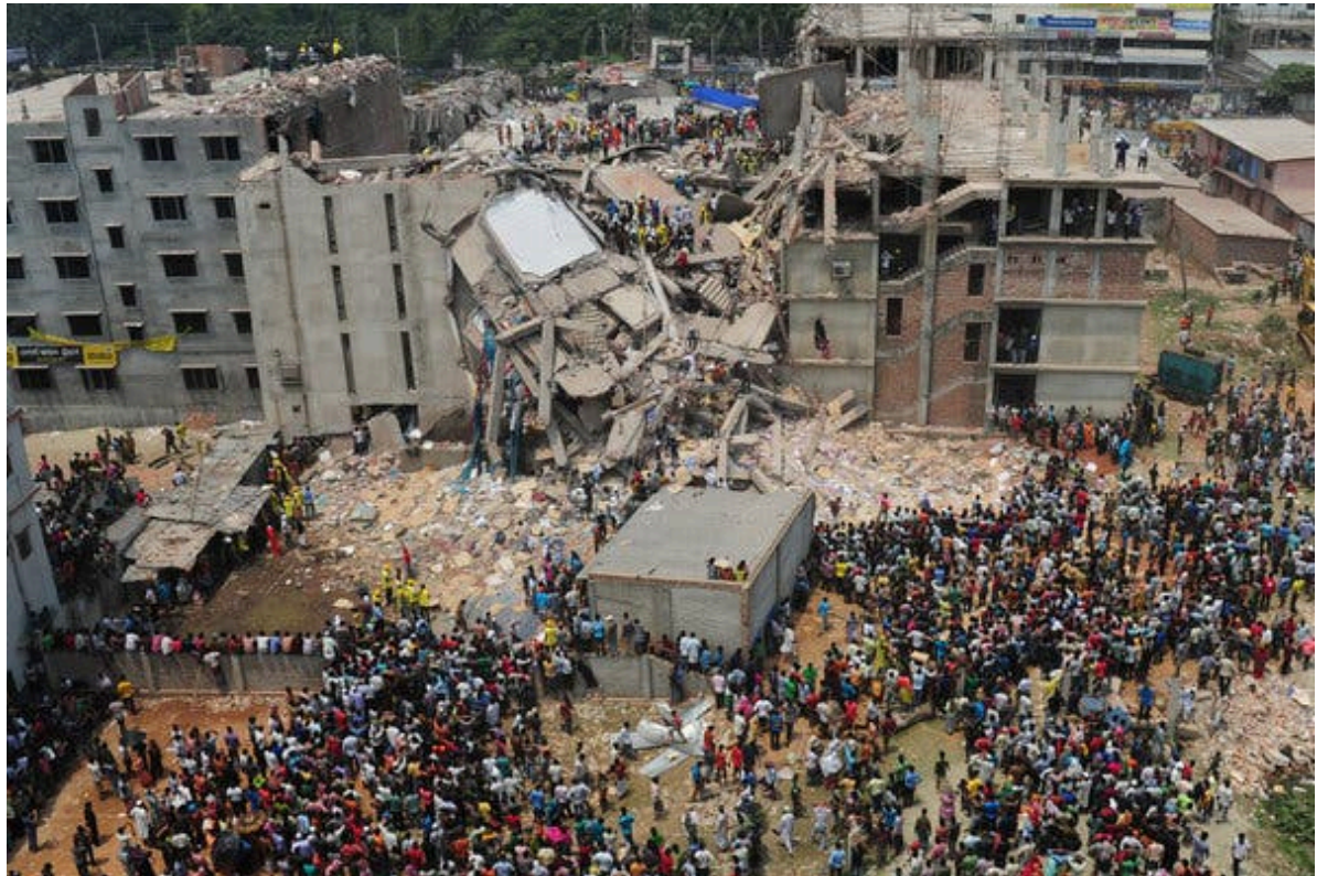
Εικόνα 14 Κατάρρευση του εργοστασίου κλωστοϋφαντουργίας Rana Plaza στο Μπαγκλαντές
