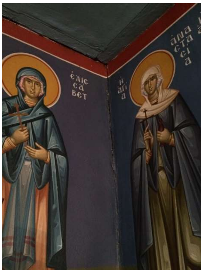
Εικόνα 27: Ρωγμές στις γωνιές της τοιχοποιίας
