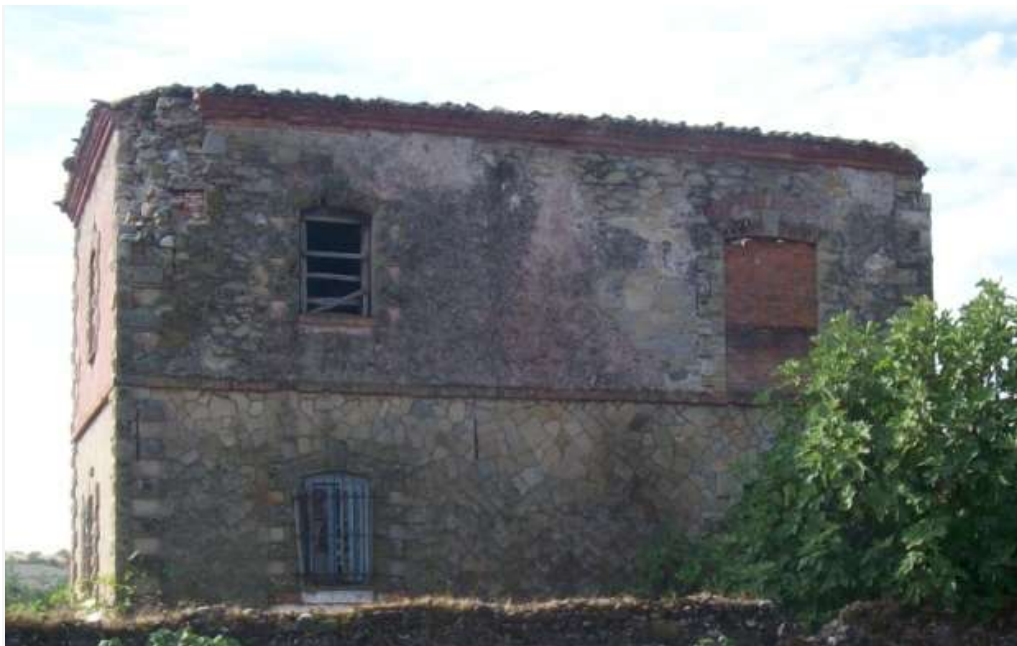
Εικόνα 67: Η πίσω όψη του κτιρίου
