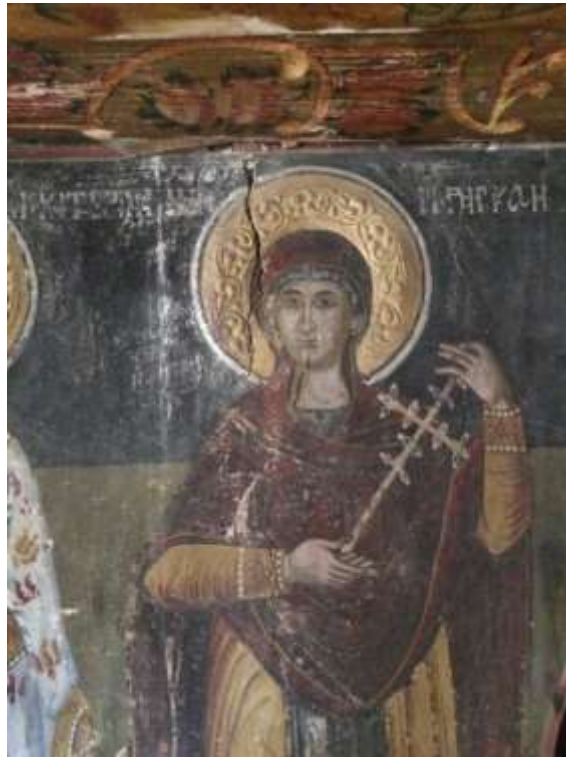
Εικόνα 19: Ρωγμές στον βόρειο τοίχο του ναού
