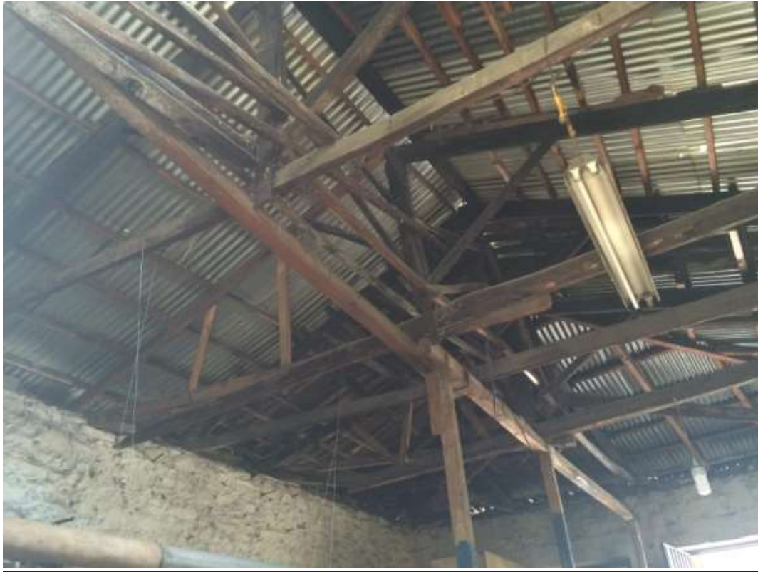
Εικόνα 61: Η ξύλινη στέγη στο εσωτερικό
