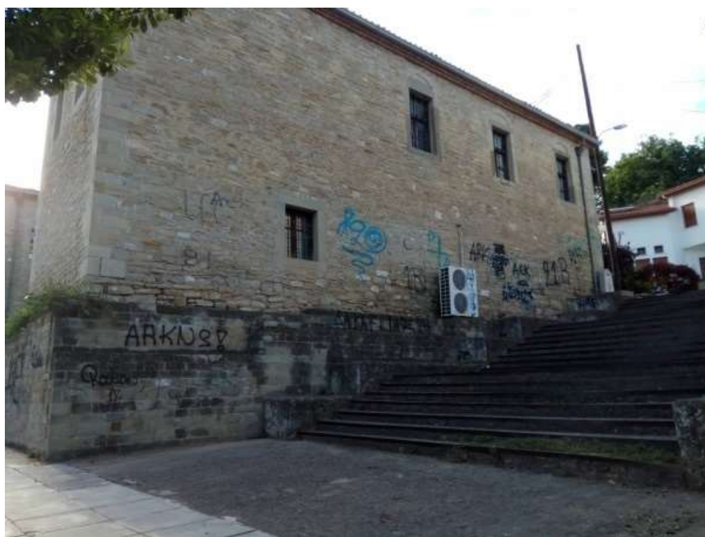
Εικόνα 58: Η πλάγια όψη της σχολής
