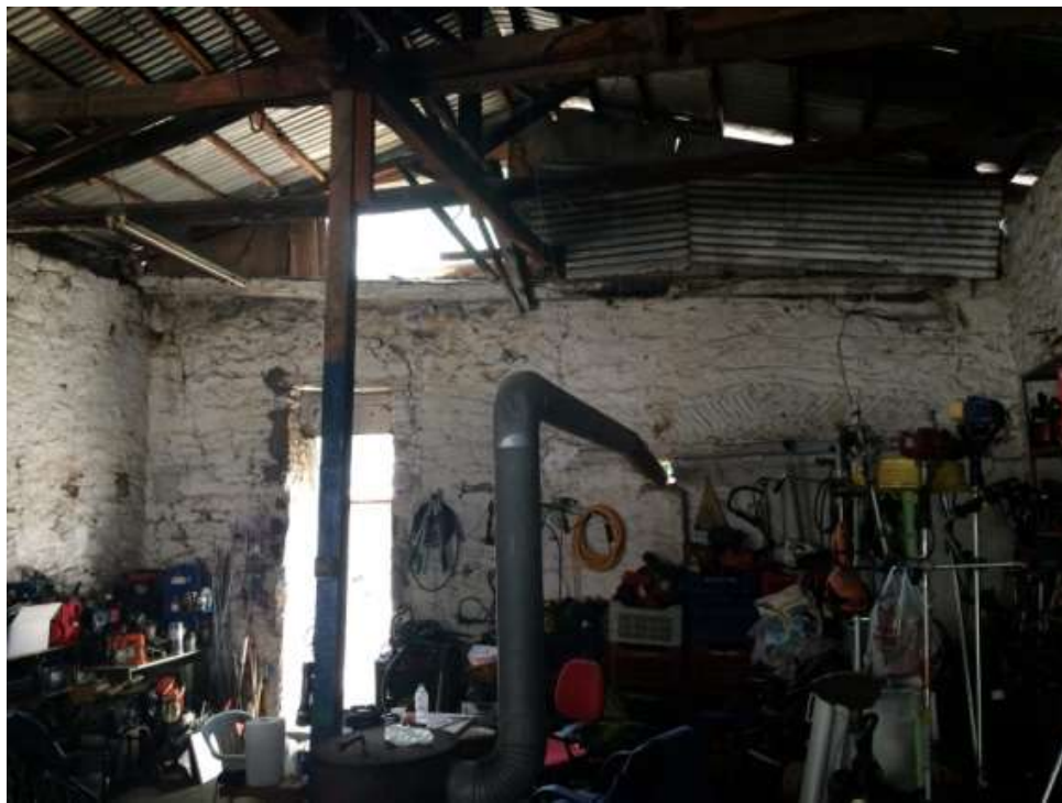
Εικόνα 62: Η ξύλινη στέγη στο εσωτερικό
