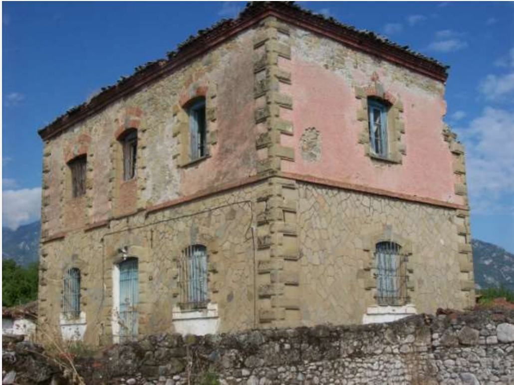
Εικόνα 66: Η πρόσοψη του κτιρίου
