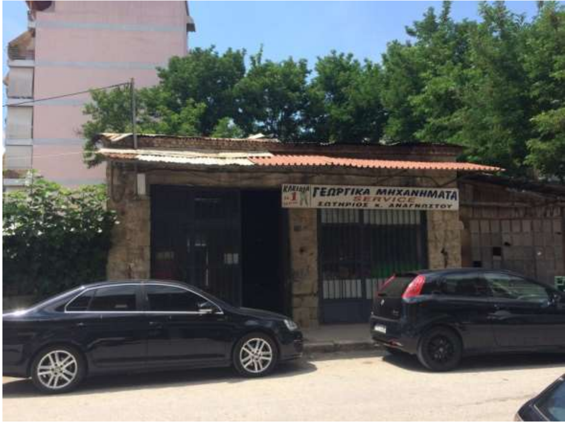
Εικόνα 59: Η πρόσοψη του κτιρίου
