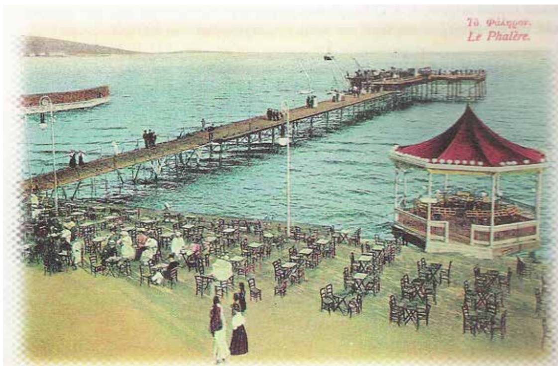
12. Γενική άποψη της εξέδρας – Παραθαλάσσιο καφενείο.
