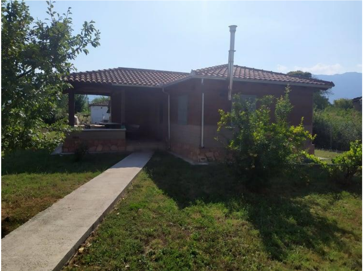
Εικόνα 40: Η κατοικία που μελετήσαμε στην Κάτω Ελάτη Τρικάλων
