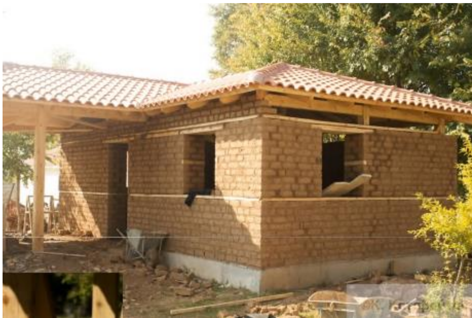
Εικόνα 7: Το κτίσμα κατά το στάδιο της κατασκευής
