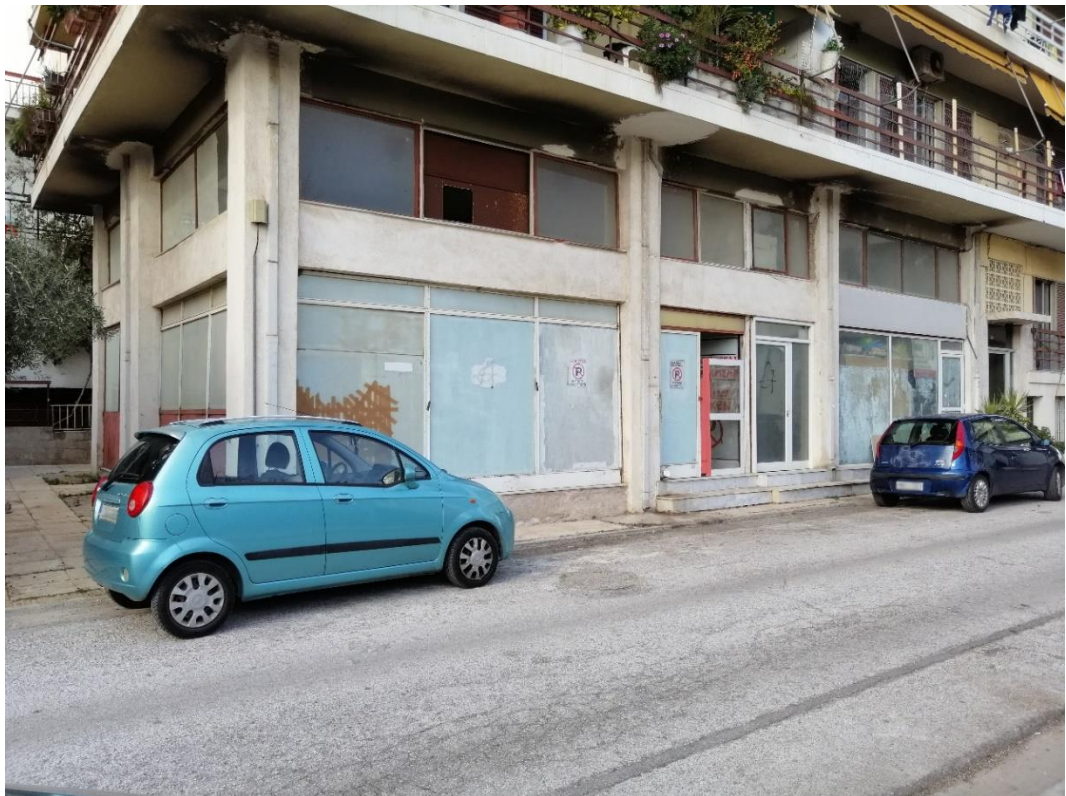
Φωτογραφία 3 Πρόσοψη καταστήματος σήμερα (τμήμα Ι)
