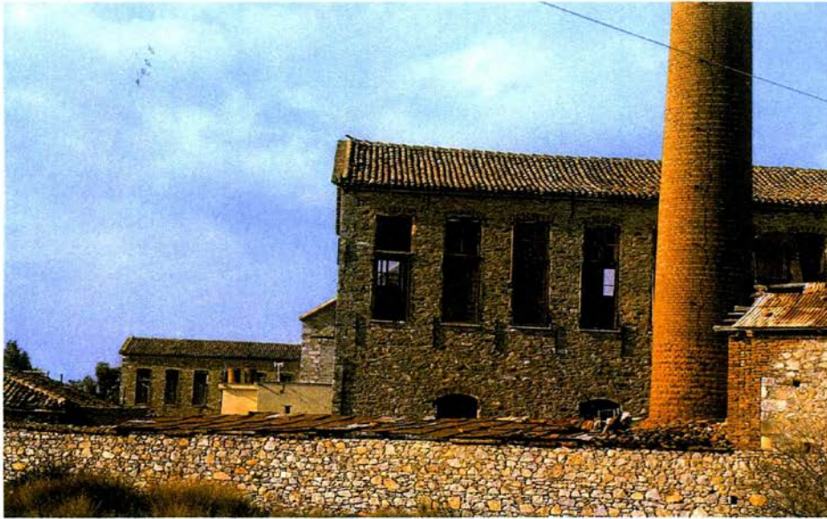
Καμινάδα εργοστασίου στο Πέραμα. Διακρίνεται το αλεξικέρανο στην καμινάδα.
