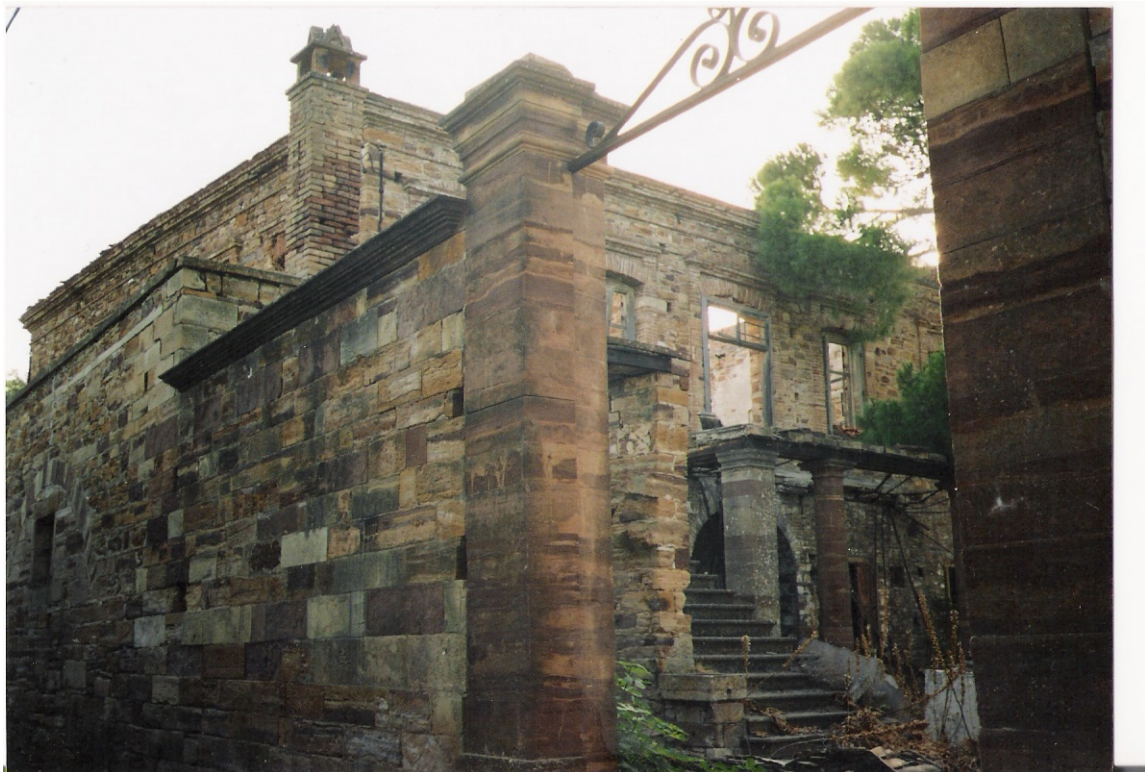
Γενική άποψη πρόσοψης- πλάγιας όψης καθώς και της κύριας πόρτας του κτιρίου
