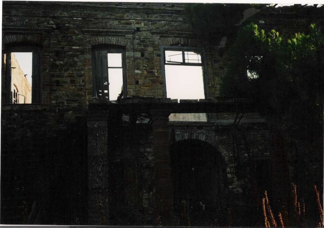
πρόσοψη κτιρίου με εμφανή τα σημάδια του χρόνου
