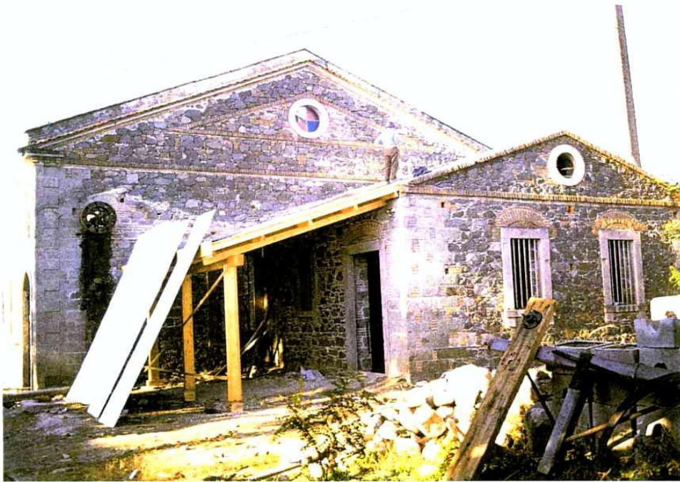
Ελαιοτριβείο Αγ. Παρασκευής. Εργασίες ανακατασκευής ξύλινου στέγαστρου μπροστά από το χώρο του αναμνηστήριου (παλιός αλευρόμυλος).
