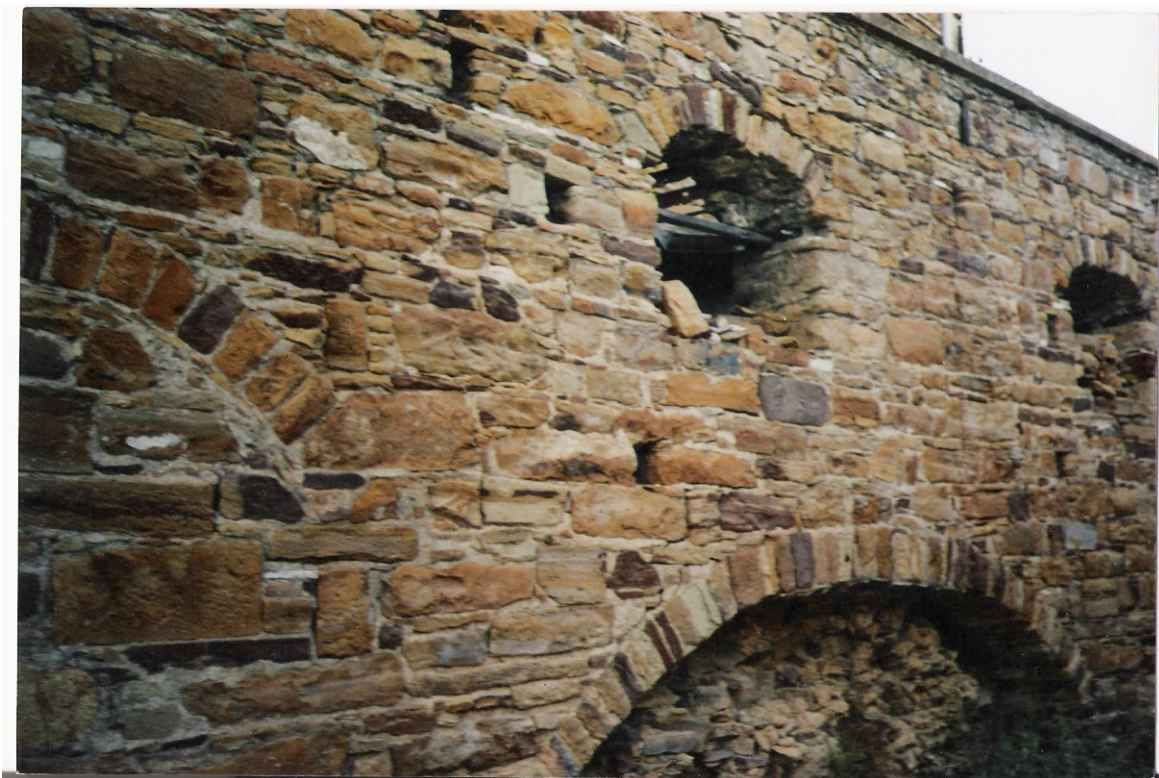
Εμφάνιση τρόπου κατασκευής της λιθοδομής του κτιρίου
