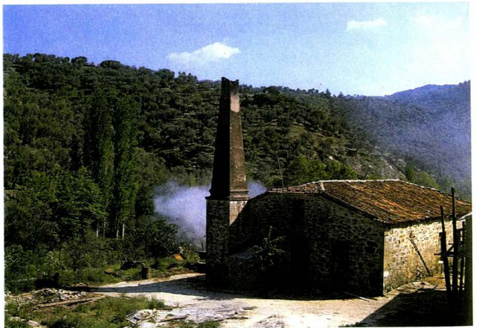
Ελαιοτριβείο στο Νεοχώρι. Αρχιτεκτονική που θυμίζει τις εκκλησίες του μάστορα Στρατήγη Καρέκου σε χωριά της Λέσβου στα μέσα του 18ου αι.
