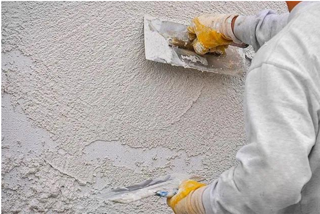
Εικόνα 49. ΑΣΒΕΣΤΟΚΟΝΙΑΜΑ, ΤΡΟΠΟΣ ΕΦΑΡΜΟΓΗΣ [Πηγή εικόνας: Μόνωση τοίχων,κονιάματα Τεχνικές λύσεις www.renovat.gr 09/2019]
