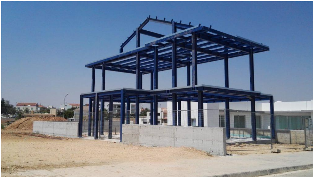
Εικόνα 20. ΜΕΤΑΛΛΙΚΟΣ ΣΚΕΛΕΤΟΣ, [Πηγή: http://www.vardiabasis.gr/ Μεταλλικές Κατασκευές ,21/01/2020 ]
