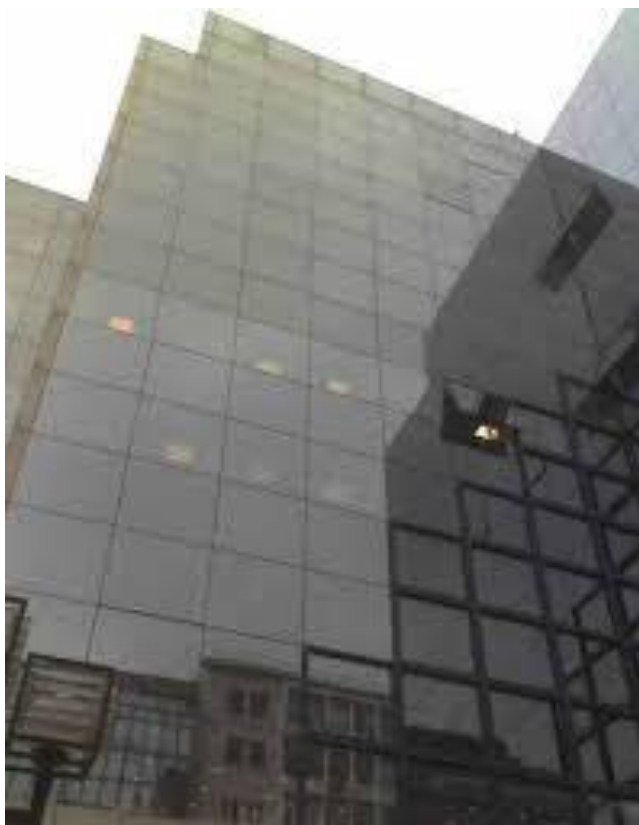
Εικόνα 35. ΤΥΠΟΣ ΔΙΑΘΛΑΣΤΙΚΟΥ ΓΥΑΛΙΟΥ, ΕΦΑΡΜΟΓΗ ΣΕ ΚΤΙΡΙΟ, [Πηγή εικόνας google search: Διαθλαστικό γυαλί, 10/2019]
