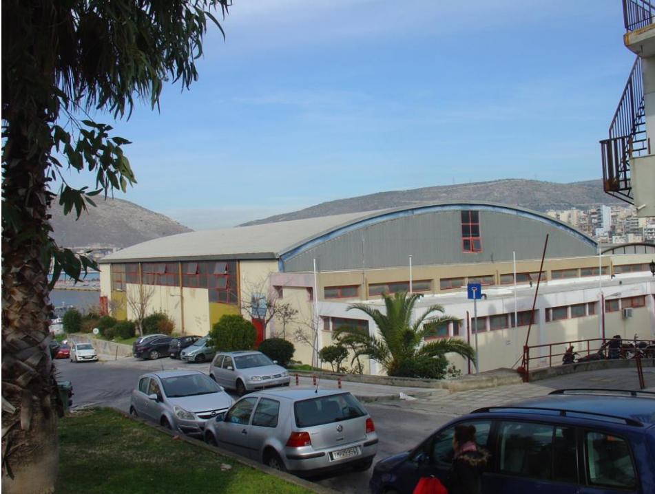
Εικόνα 4.3: Νοτιοανατολική πλευρά κολυμβητηρίου.
