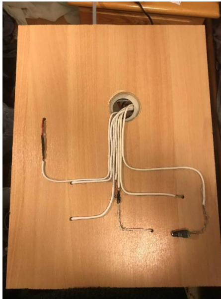
Εικόνα 35-Καλωδίωση πίσω όψη
