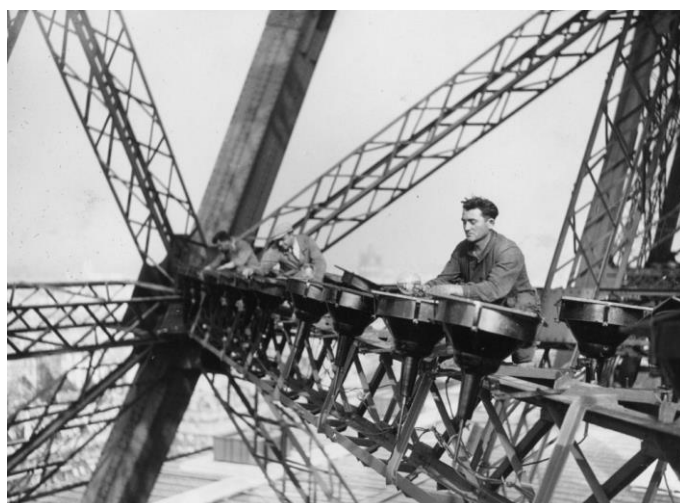
Εικόνα 26: Εργάτες κατά την κατασκευή του πύργου
