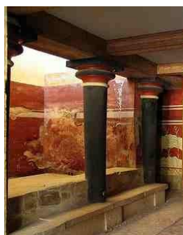
Εικόνα10:Κίονες των οποίων το μέγεθος της διατομής μειώνεται στο κάτω μέρος.
