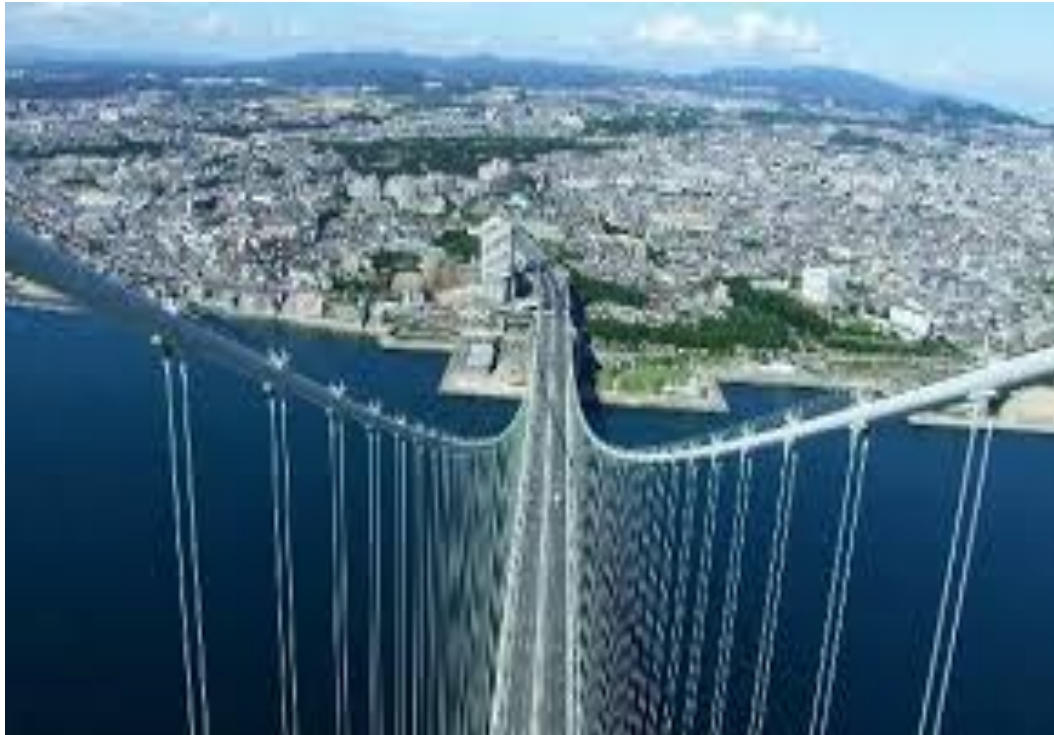
Εικόνα50: Άποψη από την κορυφή του πυλώνα.
