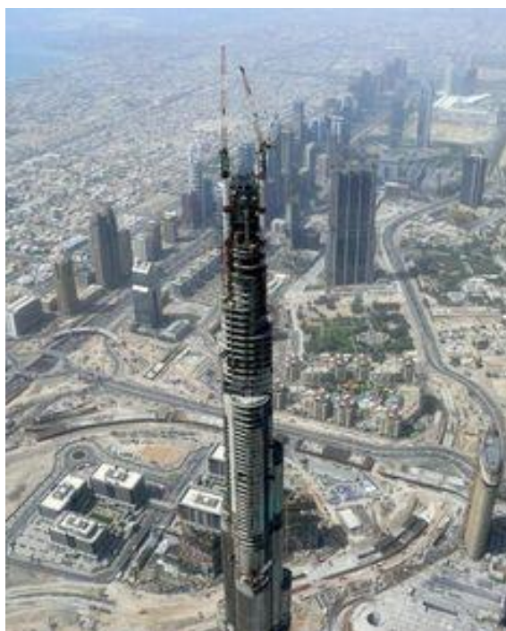
Εικόνα 36:Κατασκευή του πύργου
