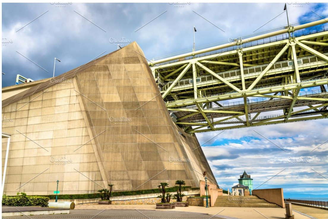
Εικόνα47: Η αγκύρωση των καλωδίων στην ακτή.
