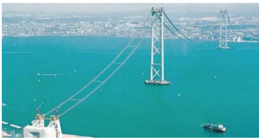
Εικόνα48: Τα δύο καλώδια κατά τη φάση της κατασκευής.
