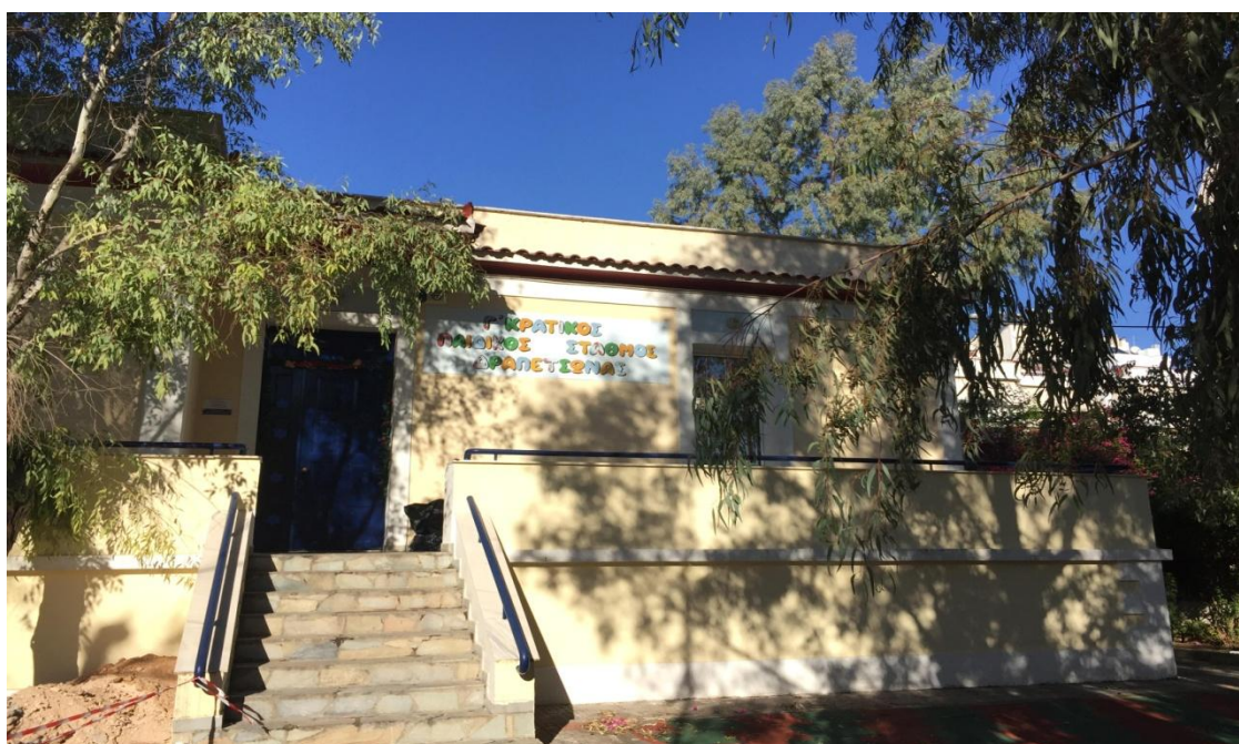
Εικόνα 16: Κύρια όψη κτιρίου
