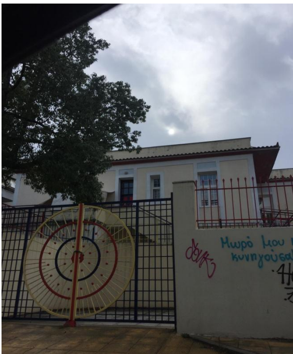
Εικόνα 19: Βόρεια όψη κτιρίου
