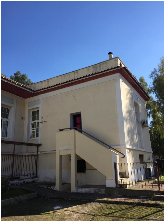
Εικόνα 17: Βόρεια όψη κτιρίου
