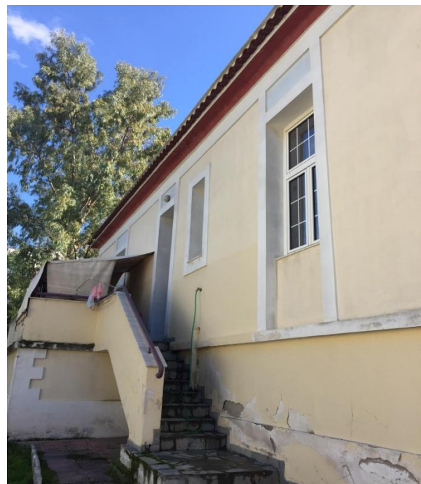
Εικόνα 20: Βόρεια όψη κτιρίου
