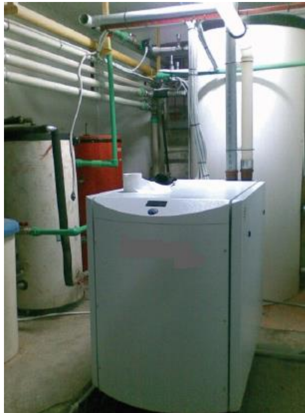
Εικόνα 4.5: Εξωτερική άποψη του ξενοδοχείου και άποψη από τις εγκαταστάσεις συμπαραγωγής
