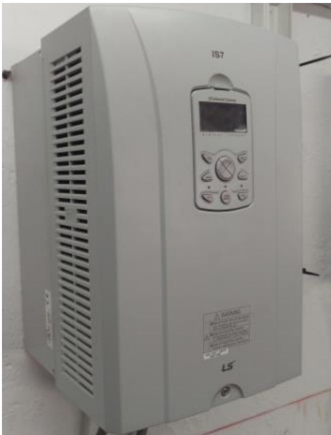
Εικόνα 8.5 Inverter της σειράς Is 7 της LG σε ΗΜ εγκατάσταση της Ε.ΥΔ.Α.Π Ν1. [5].
