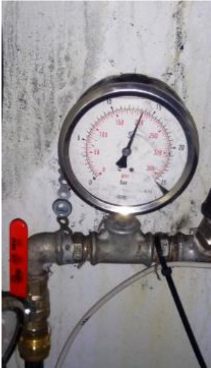
Εικόνα 3.10 Αναλογικό μανόμετρο (γλυκερίνης). [5].
