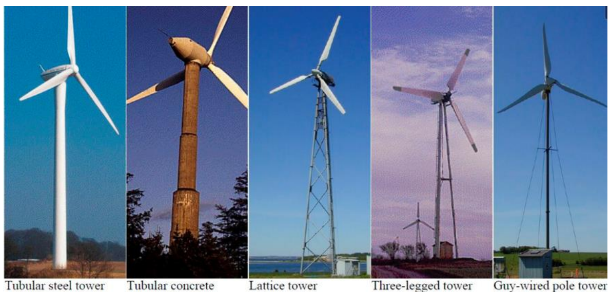
Σχήμα 1.20. Τα τρία επικρατέστερα είδη πύργων Α/Γ
