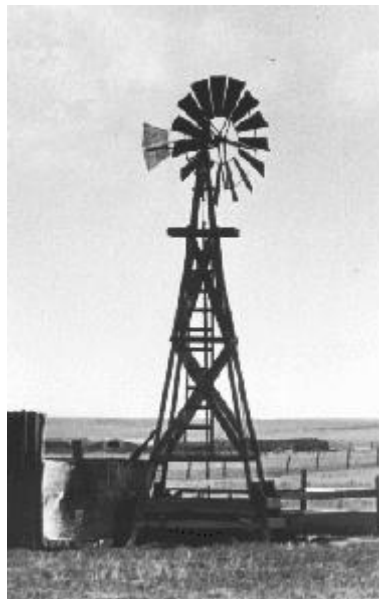
Σχήμα 1.7. Ένας ανεμόμυλος άντλησης νερού με χαλύβδινο νερό στην Αμερικάνικη Midwest (τέλη του 1800)
