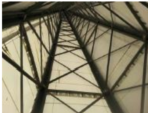
Σχήμα 1.27. Εσωτερικό δικτυωτού πύργου General Electric (Είναι ορατή και η επένδυση των όψεων)
