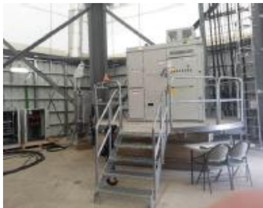
Σχήμα 1.28. Κέντρο ελέγχου στη βάση της Α/Γ
