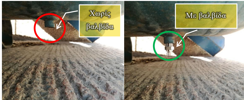
Εικόνα 8: Πριν και μετά την τοποθέτηση νέας βαλβίδας αποστράγγισης.
