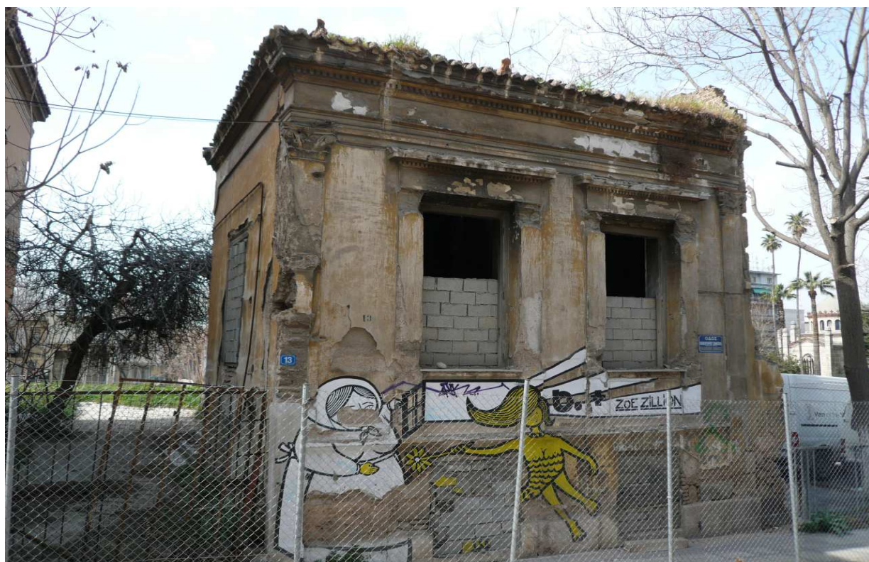
ΔΙΑΤΗΡΗΤΕΟ ΚΤΙΡΙΟ 1 (ΦΕΚ 545Δ/93) – ΟΔΟΣ ΚΑΛΟΓΗΡΟΥ ΣΑΜΟΥΗΛ
