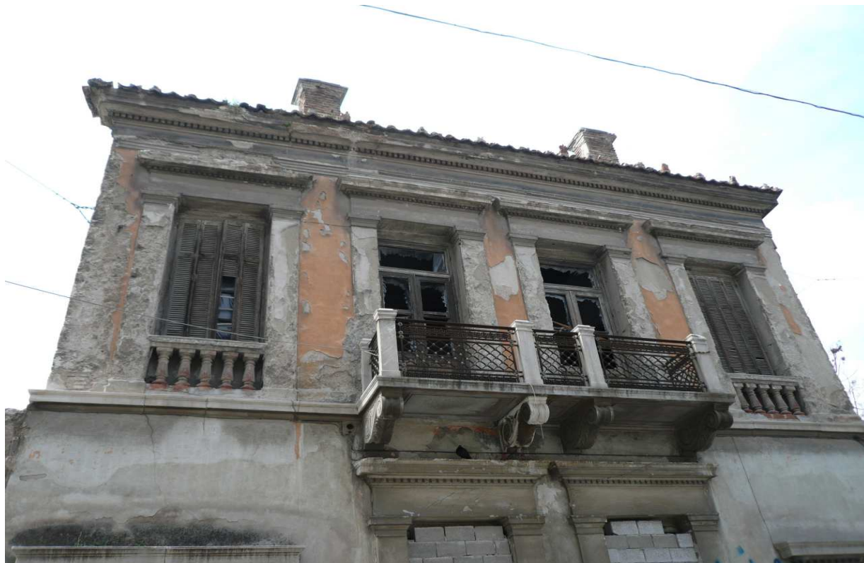
ΔΙΑΤΗΡΗΤΕΟ ΚΤΙΡΙΟ 2 (ΦΕΚ 545Δ/93) – ΟΔΟΣ ΚΑΛΟΓΗΡΟΥ ΣΑΜΟΥΗΛ
