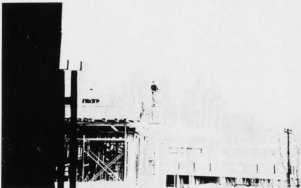
Εικόνα 5 : Ανυπαρξία δαπέδου εργασίας. Κανένα μέσο προστασίας (στηρίζεται μόνο πάνω στο σωλήνα της υποτυπώδους σκαλωσιάς).
