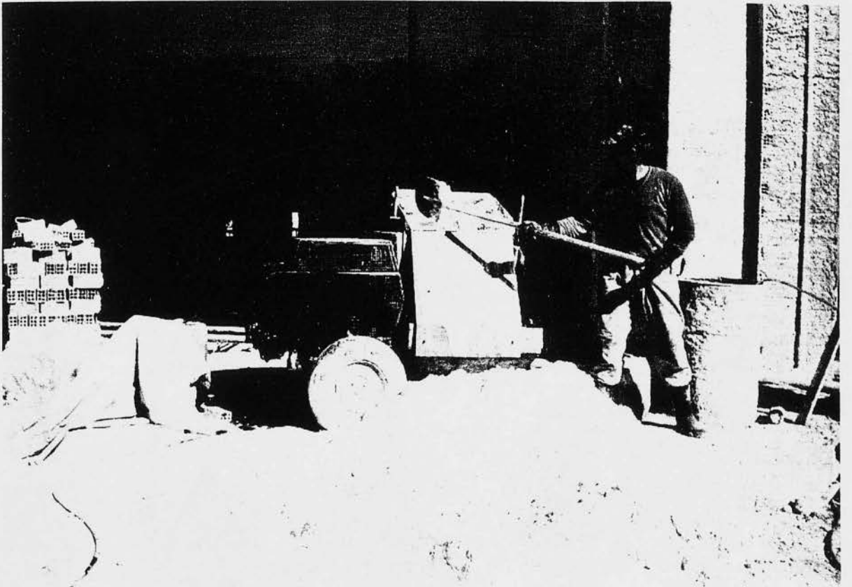
Εικόνα 13 : Εργαζόμενος σε εργασίες σοβατίσματος έχοντας λάβει μερικές από τις προφυλάξεις ασφαλείας όπως γάντια και παπούτσια, έχει ξεχάσει όμως γάντια και γυαλιά.
