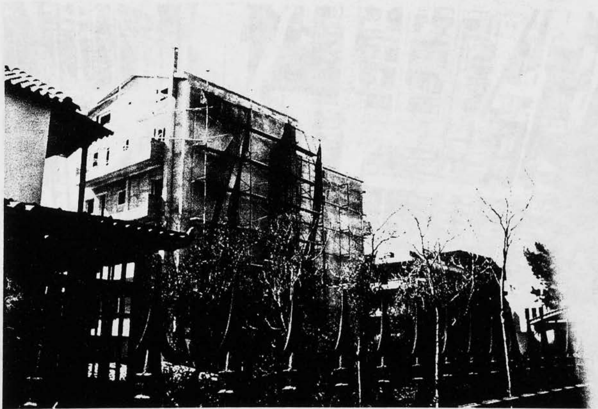
Εικόνα 8,9 : Σκαλωσιές, εγκατεστημένες περιμετρικά της οικοδομής εξασφαλίζοντας ασφαλή εργασία.
