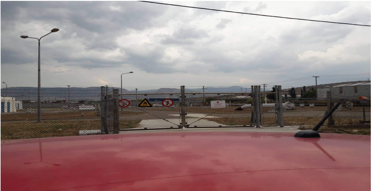
Εικόνα 55 Εργοστάσιο φωταερίου (πηγή:προσωπικό αρχείο)
