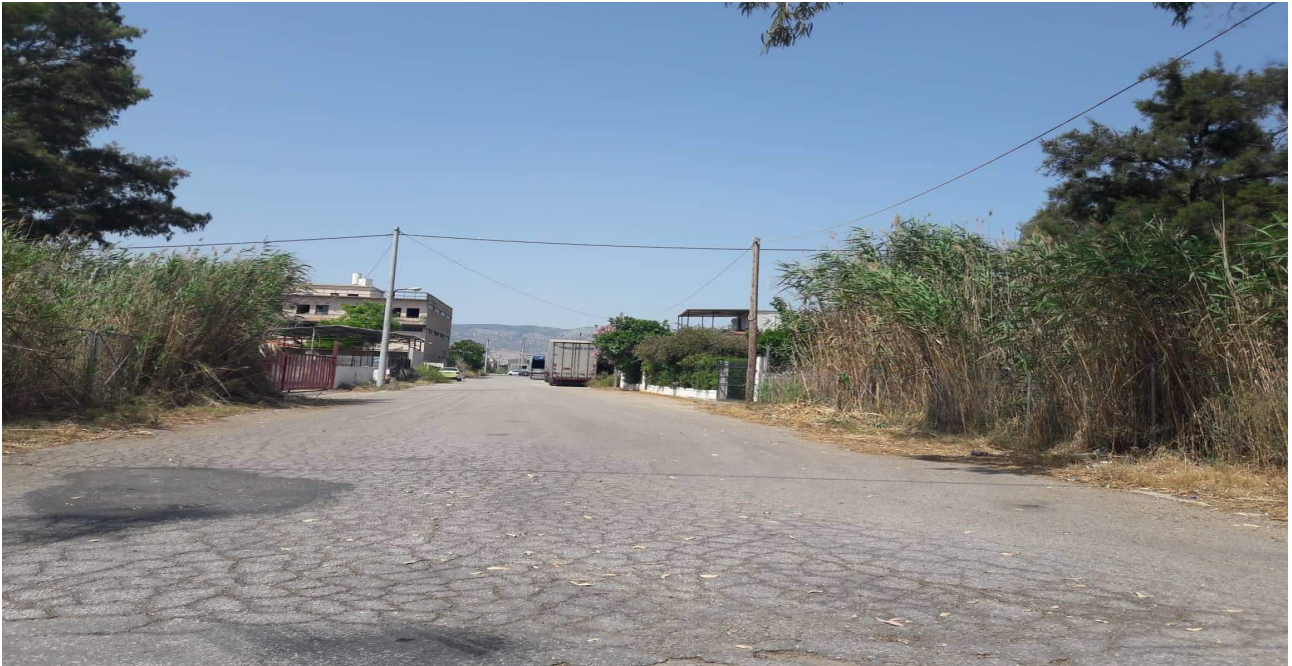
Εικόνα 37 Απεικόνιση ρηγματώσεων σε τοπική οδό (πηγή:προσωπικό αρχείο)
