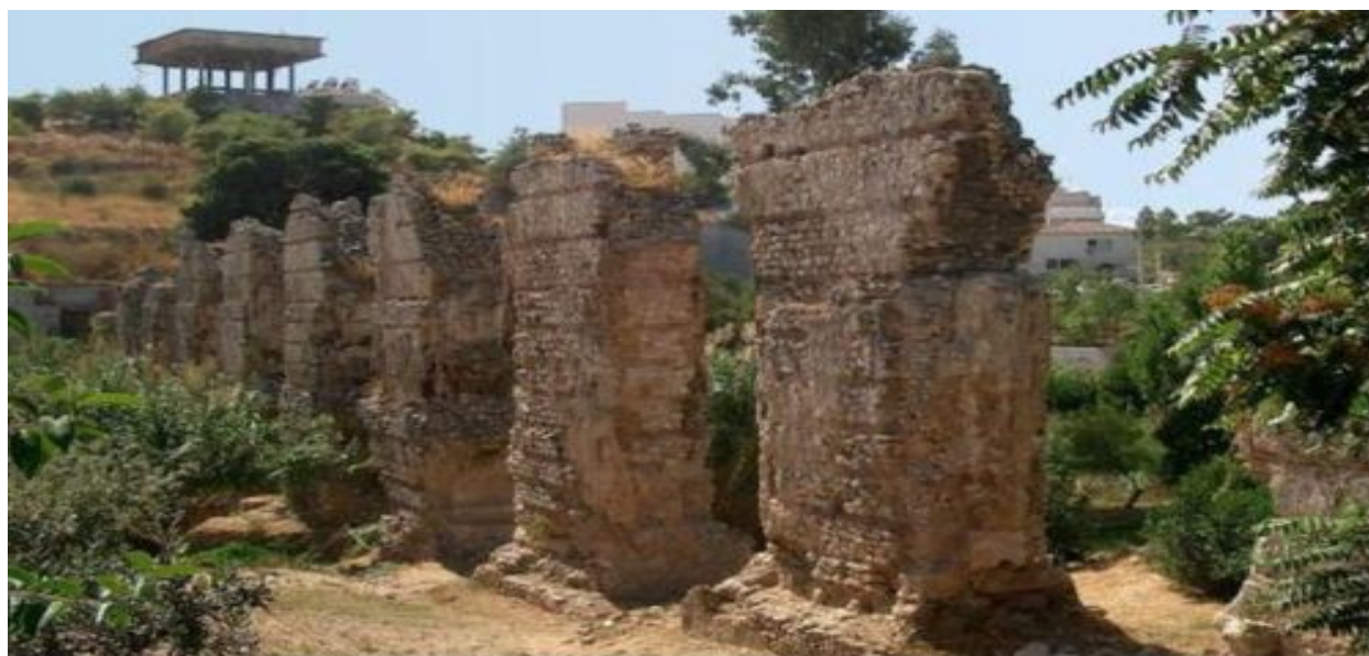
Εικόνα 48 (Αδριάνειο Υδραγωγείο Αθήνας) (πηγή: http://www.namanet.gr )
