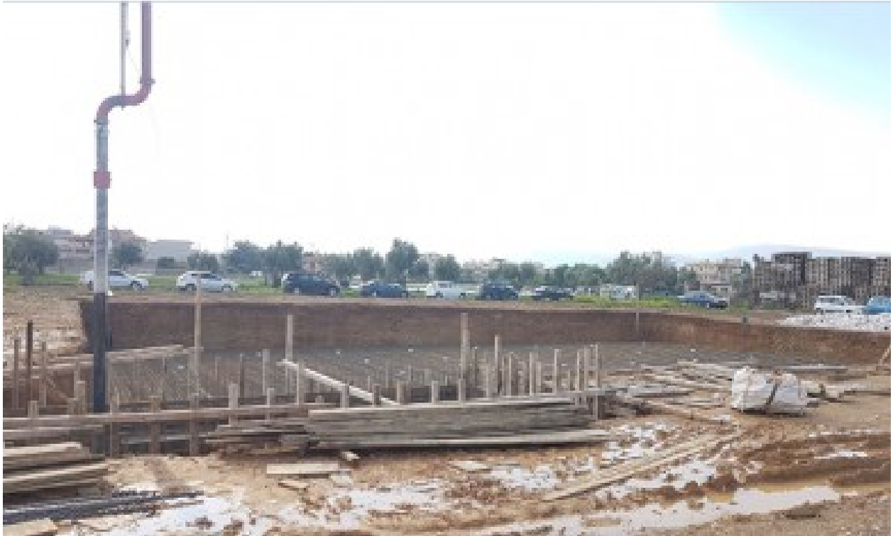
Εικόνα 2 (Θεμελίωση νέου κολυμβητηρίου στον Ασπρόπυργο) (πηγή: www.dimosaspropyrgou.gr )
