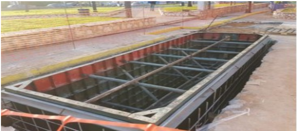
Εικόνα 9 (Απεικόνιση φάσης εργασιών για την τοποθέτηση υπόγειων κάδων) (πηγή 20 : www.thriassio.gr )
