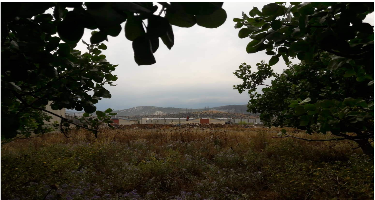
Εικόνα 56 Εργοστάσιο φωταερίου στο Δήμο Ασπροπύργου με υψηλή επικινδυνότητα εκδήλωσης πυρκαγιάς (πηγή: προσωπικό αρχείο)
