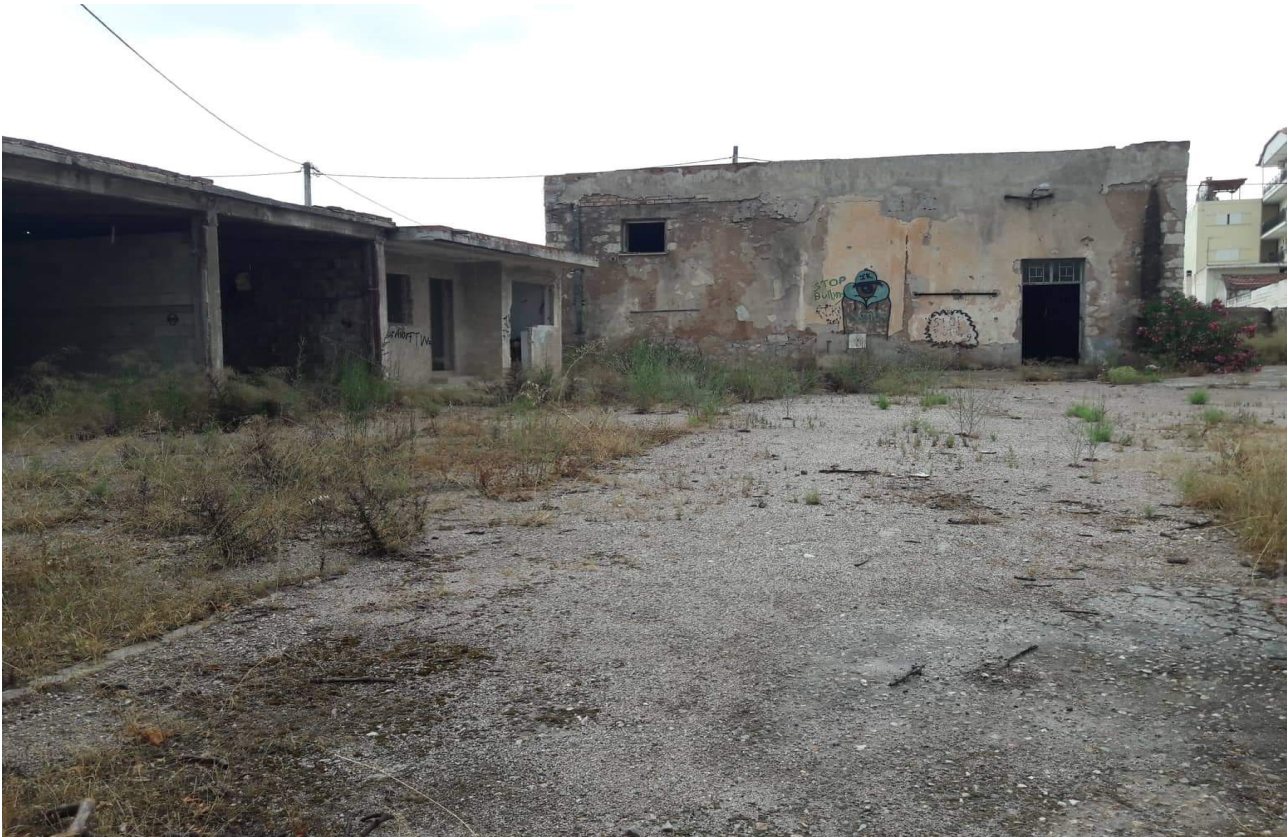
Εικόνα 16 (Παλιό υδραγωγείο Δήμου Ασπροπύργου) (πηγή: προχωπικό αρχείο)
