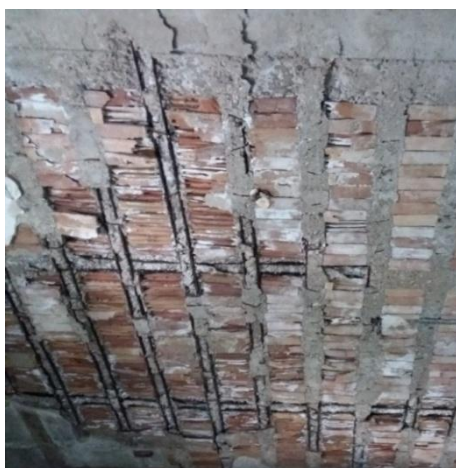
είκ.2.2: Πλάκα Οροφής Γ' Ορόφου
