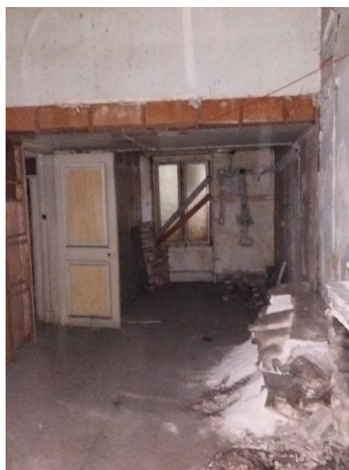
είκ. 2.17: Κουζίνα Α Ορόφου
