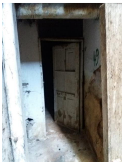
είκ. 2.8– 2.9: Υγρασία στο Υπόγειο (Μηχανοστάσιο)
