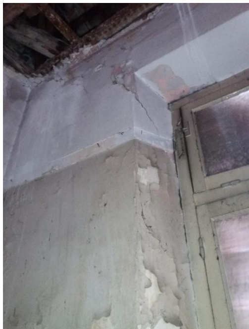
εικ. 2.8-2.9. Ρωγμές στα υπέρθυρα λόγω των εγκάρσιων σεισμικών δράσεων (τοιίχος t5 Β' και Γ' Όροφος)
