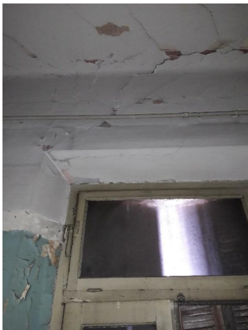
εικ. 2.10-2.11. Ρωγμές στα υπέρθυρα λόγω των εγκάρσιων σεισμικών δράσεων (τοιίχος t5 Β' και Γ' Όροφος)
