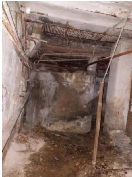
είκ. 2.8– 2.9: Υγρασία στο Υπόγειο (Μηχανοστάσιο)
