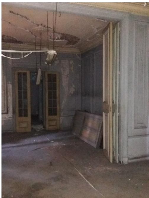
είκ. 2.16: Καθιστικό – Δωμάτιο Α Ορόφου
