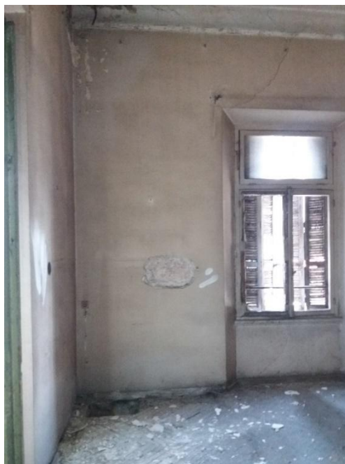
εικ. 2.8-2.9. Ρωγμές στα υπέρθυρα λόγω των εγκάρσιων σεισμικών δράσεων (τοιίχος t5 Β' και Γ' Όροφος)
