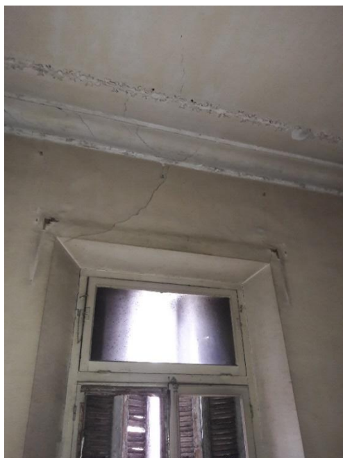
εικ. 2.10-2.11. Ρωγμές στα υπέρθυρα λόγω των εγκάρσιων σεισμικών δράσεων (τοιίχος t5 Β' και Γ' Όροφος)
